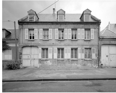
Elévation antérieure. Phot. Jean-Michel Perrin IVR22_19856000822V
