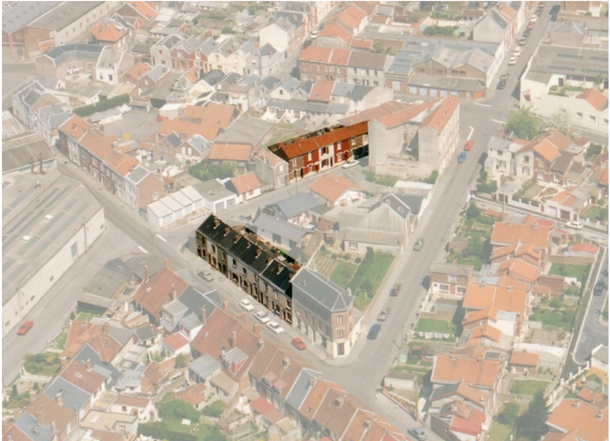
Vue aérienne vers 1989 (BM Saint-Quentin).
