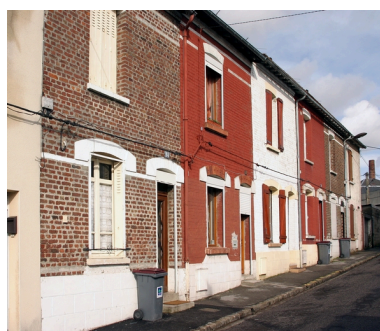
Les logements de la rue Ernest-Desfossez. Phot. Frédéric Pillet IVR22_20060205258NUCA
