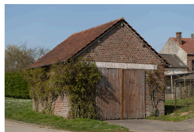
Remise des pompes à incendie, Neuve Rue, vue depuis le sud-est. Phot. Marc Kérignard IVR32_20226000209NUCA
