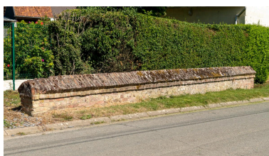
Mur d'une ancienne mare de La Neuve Rue, vue depuis l'est. Phot. Marc Kérignard IVR32_20226000719NUCA
