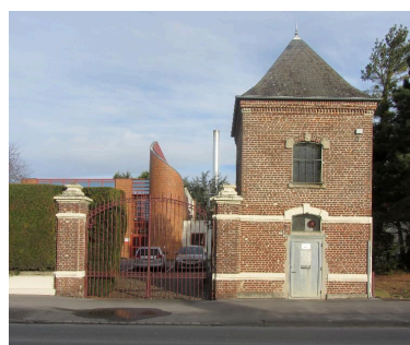
Les vestiges de l'ancienne sucrerie Bernot. Phot. Bertrand Fournier IVR32_20168005026NUCA
