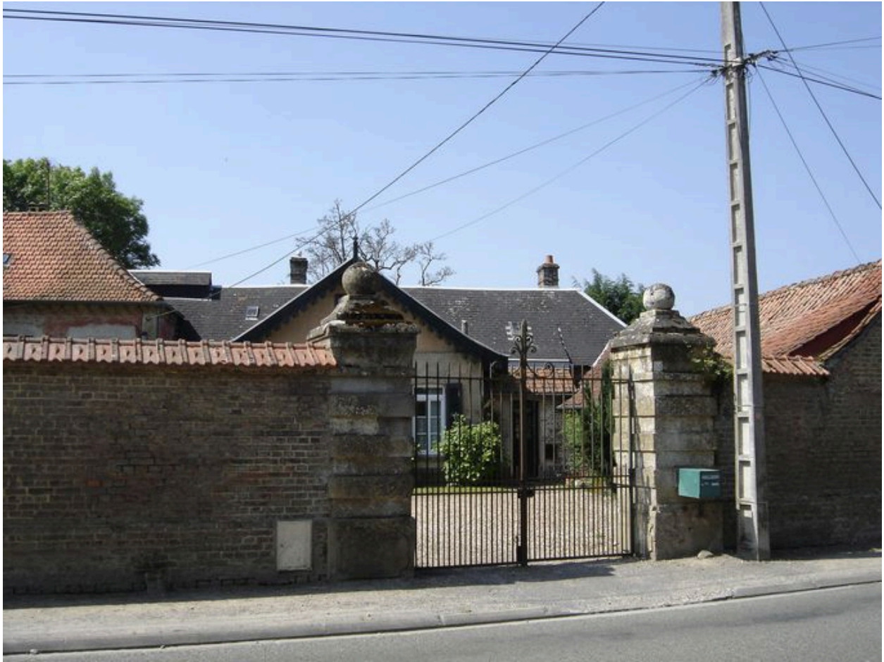
Vue de l'accès au n°55.
