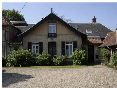
Vue du logis n°55. Phot. Inès Guérin IVR22_20058005887NUCA
