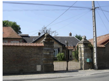
Vue de l'accès au n°55. Phot. Inès Guérin IVR22_20058005886NUCA
