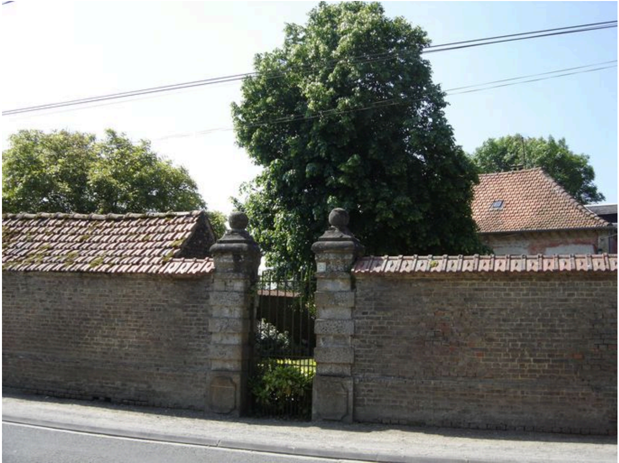
Vue du mur de clôture et de la porte d'accès du n°53.
