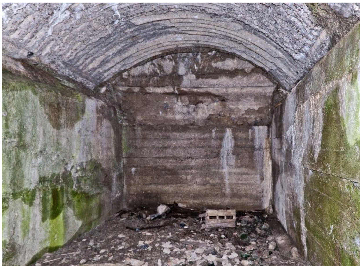
Bâtiment B, vue intérieure
