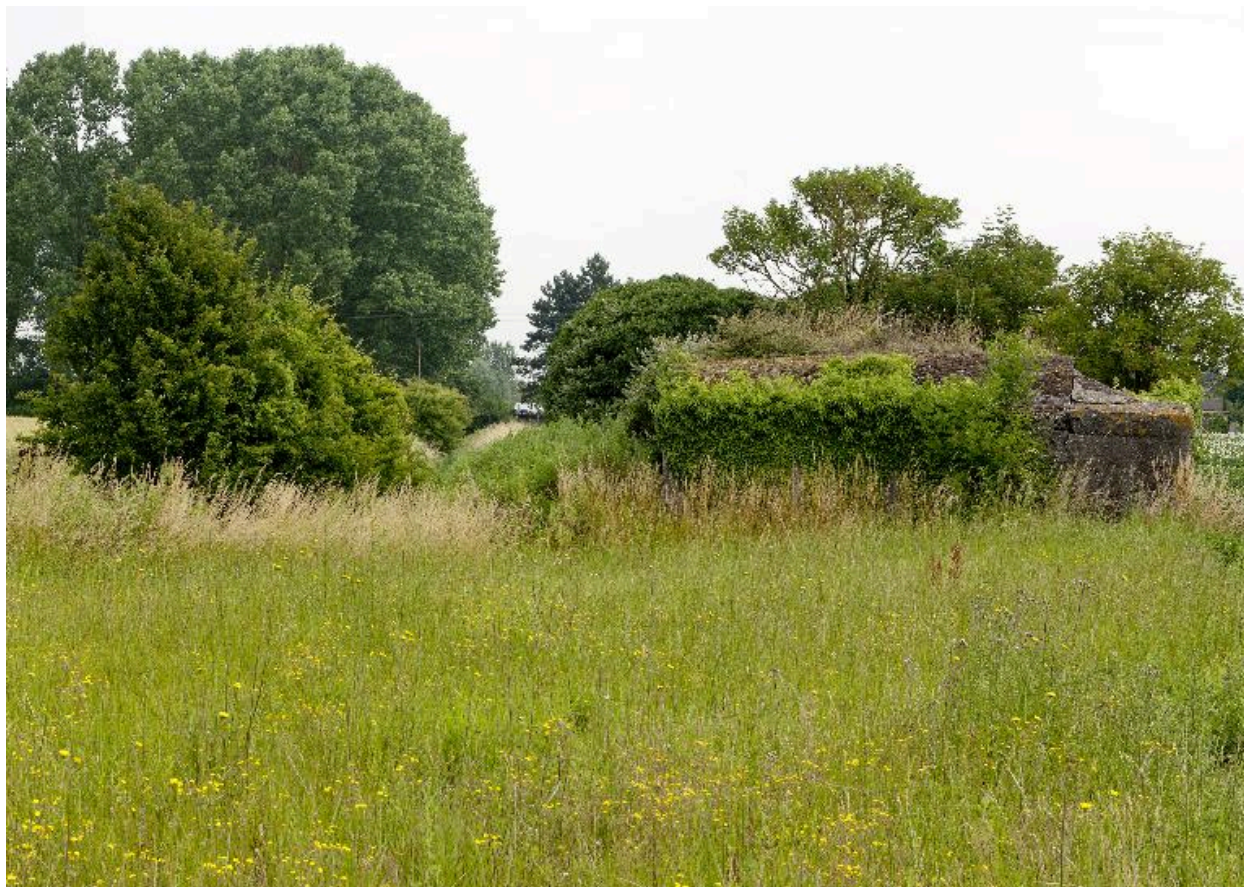
Bâtiment A, vue latérale, vers le nord
