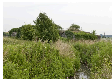
D'avant en arrière et sous la végétation, les bâtiments A et B Phot. Jean-Marc Ramette IVR31_20145904914NUCA
