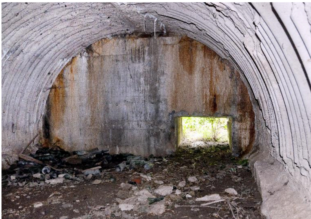
Bâtiment A, vue intérieure
