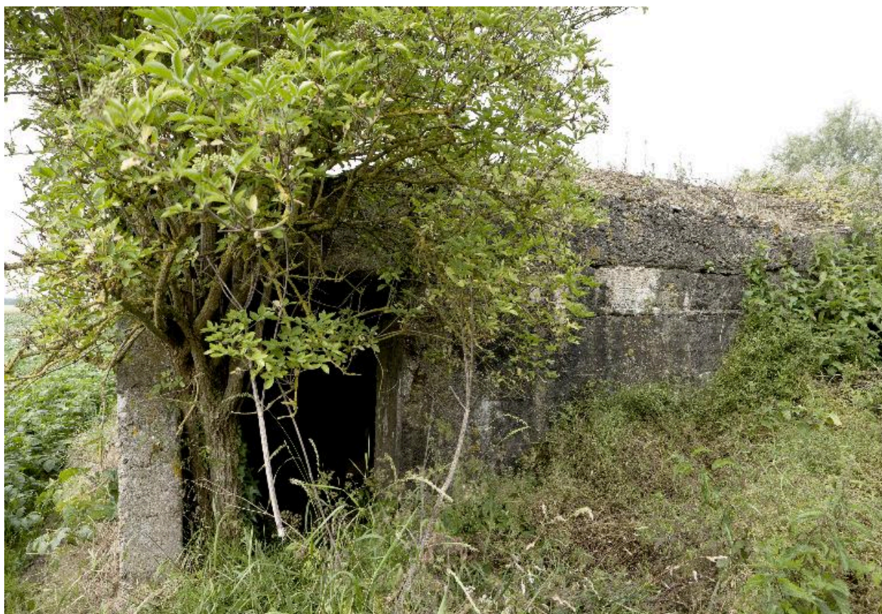
Bâtiment A, entrée sur l'élévation nord-est
