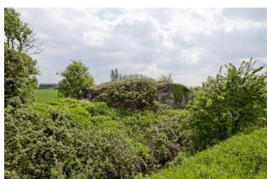
D'avant en arrière, les bâtiments A et B Phot. Jean-Marc Ramette IVR31_20145904921NUCA
