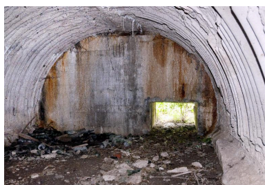
Bâtiment A, vue intérieure Phot. Jean-Marc Ramette IVR31_20145904924NUCA
