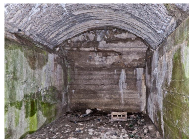
Bâtiment B, vue intérieure Phot. Jean-Marc Ramette IVR31_20145904923NUCA
