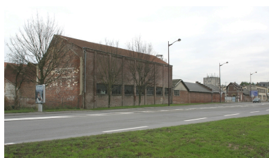
Vue du site depuis le boulevard de Verdun. Phot. Frédéric Pillet IVR22_20070205079NUCA
