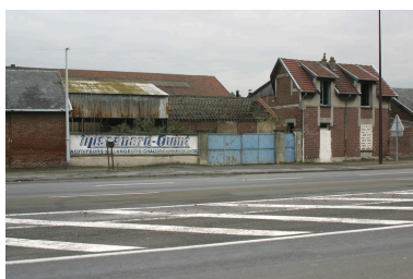
Entrée du site, boulevard de Verdun. Phot. Frédéric Pillet IVR22_20070205080NUCA
