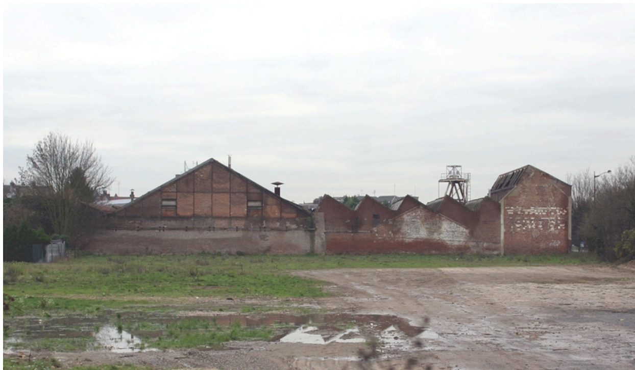
Vue du site depuis la rue de Pontoile.
