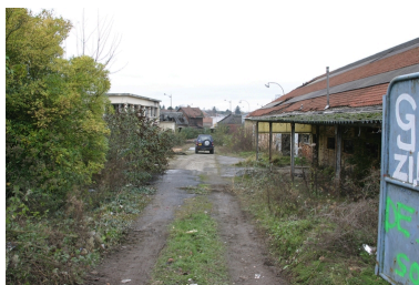
Entrée du site, boulevard Henri-Martin. Phot. Frédéric Pillet IVR22_20070205077NUCA
