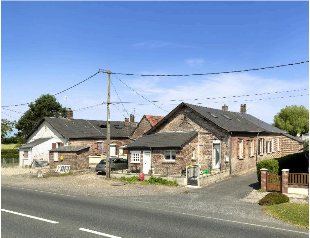
Vue d'ensemble depuis la route d'Abbeville.
