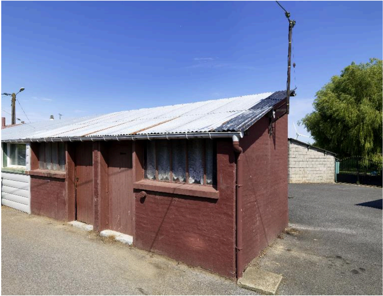
Anciennes boutiques d'artisan situées à l'arrière des logements ouvriers.
