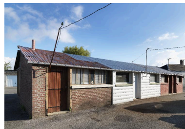
Vue de trois-quarts des anciennes boutiques d'artisan. Phot. Thierry Lefébure IVR22_20158000782NUC2A
