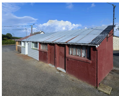
Vue de trois-quarts des anciennes boutiques d'artisan. Phot. Thierry Lefébure IVR22_20158000783NUC2A
