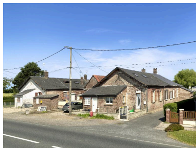
Vue d'ensemble depuis la route d'Abbeville. Phot. Thierry Lefébure IVR22_20158000565NUC2A
