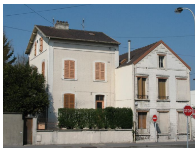
Ancienne maison du sous-chef de gare à gauche et magasins de l'usine à gaz à droite. Phot. Clarisse Lorieux IVR22_20076005143NUCA
