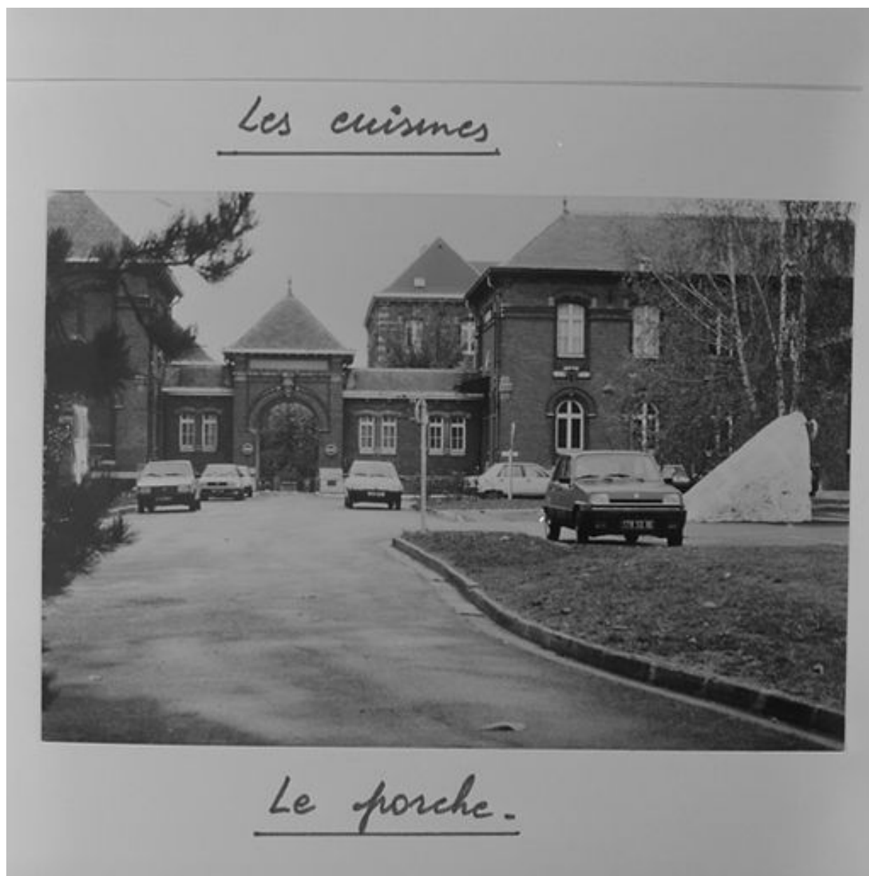
Vue d'un portail et d'une galerie de circulation couverte en 1989, avant les travaux de réaménagement et de destruction (coll. part.).
