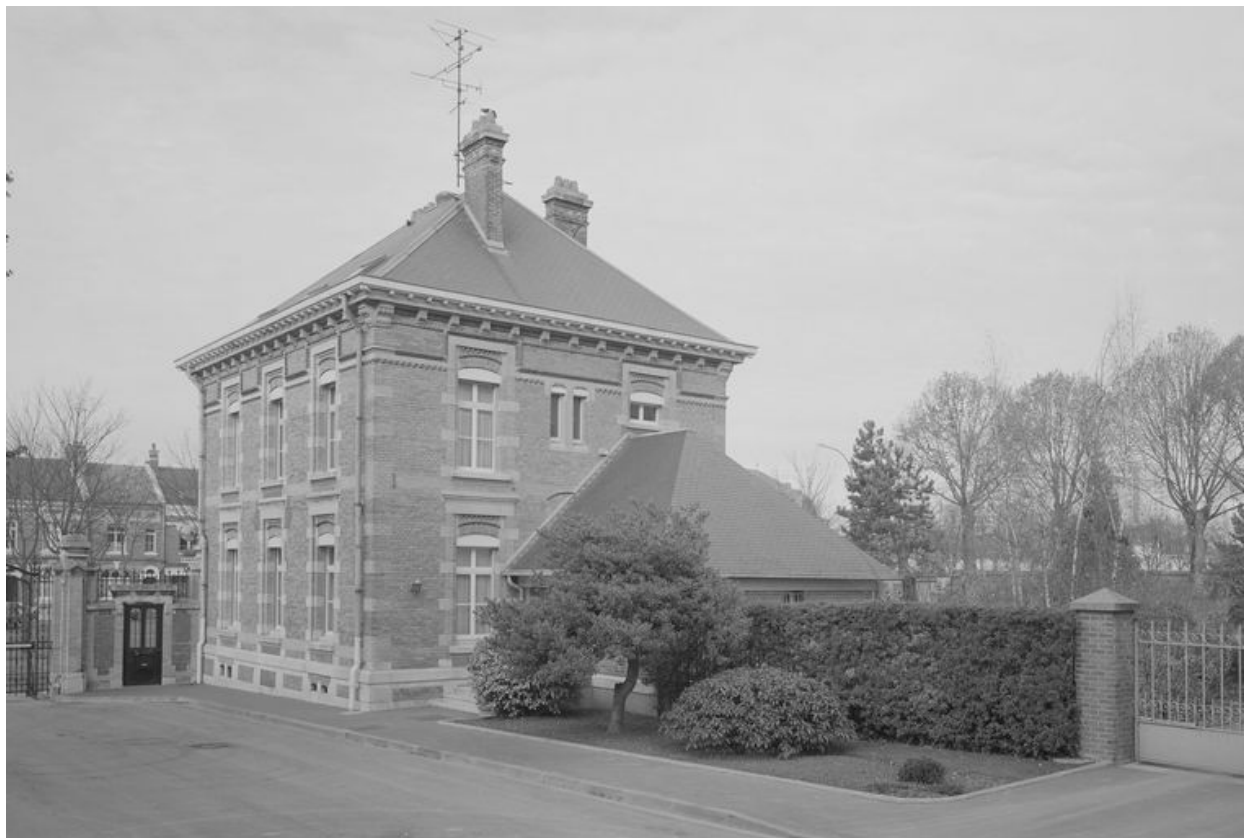
Élévation postérieure d'un pavillon d'entrée.
