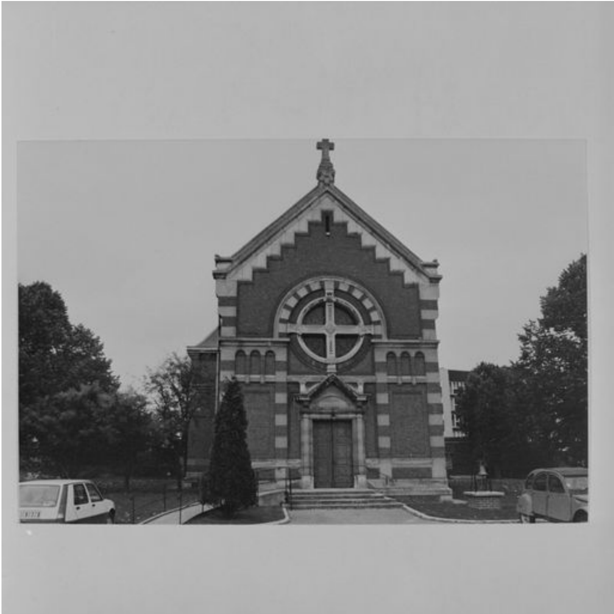
Vue de la chapelle, avant les travaux de réaménagement en 1989.
