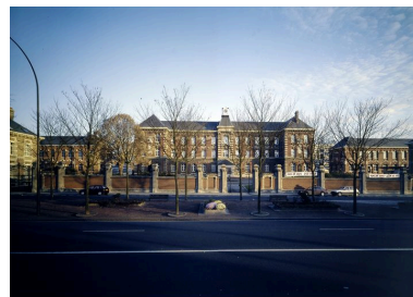
Vue générale. Phot. Thierry Lefébure IVR22_19978001215PA
