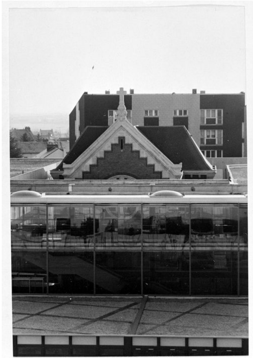
Pignon de la chapelle, après les travaux de réaménagement.
