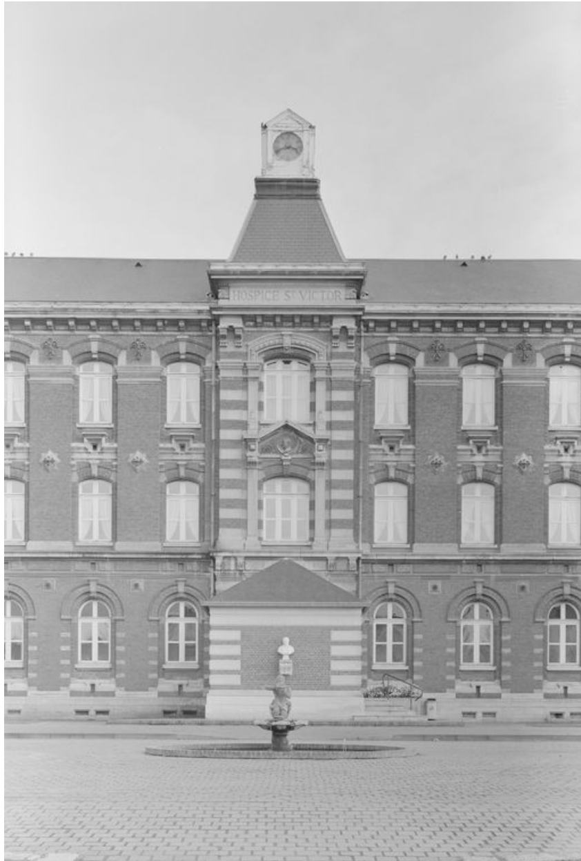
Détail de la façade principale du bâtiment central (clinique).
