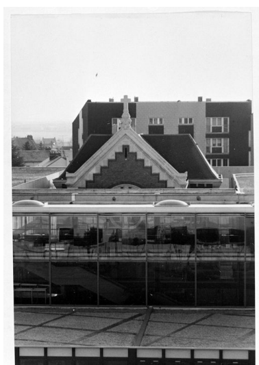
Pignon de la chapelle, après les travaux de réaménagement. Phot. Thierry Lefébure IVR22_19978001109XB
