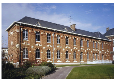
Élévation postérieure du bâtiment sur la cour d'honneur. Phot. Irwin Leullier IVR22_19978001214XA
