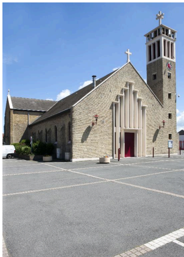
Vue de trois-quart de l'élévation antérieure de l'église. Phot. Pierre Thibaut IVR31_20155900344NUCA
