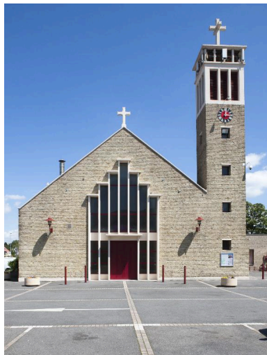
Élévation antérieure de l'église. Phot. Pierre Thibaut IVR31_20155900345NUCA
