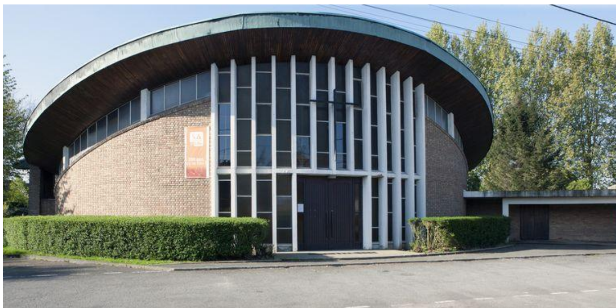
Élévation antérieure de trois quart gauche.
