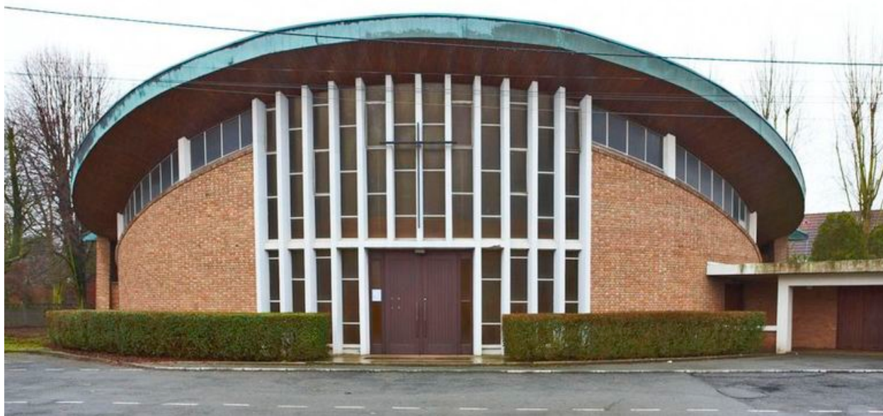
Vue de la façade.
