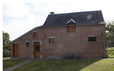
Vue d'une ancienne étable (?) située face au logis. Phot. Pierre Thibaut IVR31_20095903171NUCA
