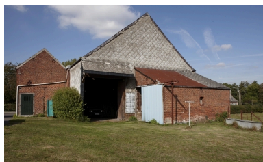
Vue de la grange et des remises qui lui sont accolées. Phot. Pierre Thibaut IVR31_20095903174NUCA
