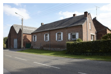
Vue générale de la ferme depuis la voie. Phot. Pierre Thibaut IVR31_20095903177NUCA
