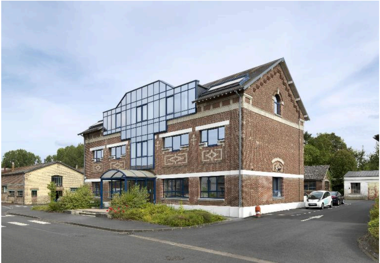
Bâtiment administratif, vue de trois-quarts.
