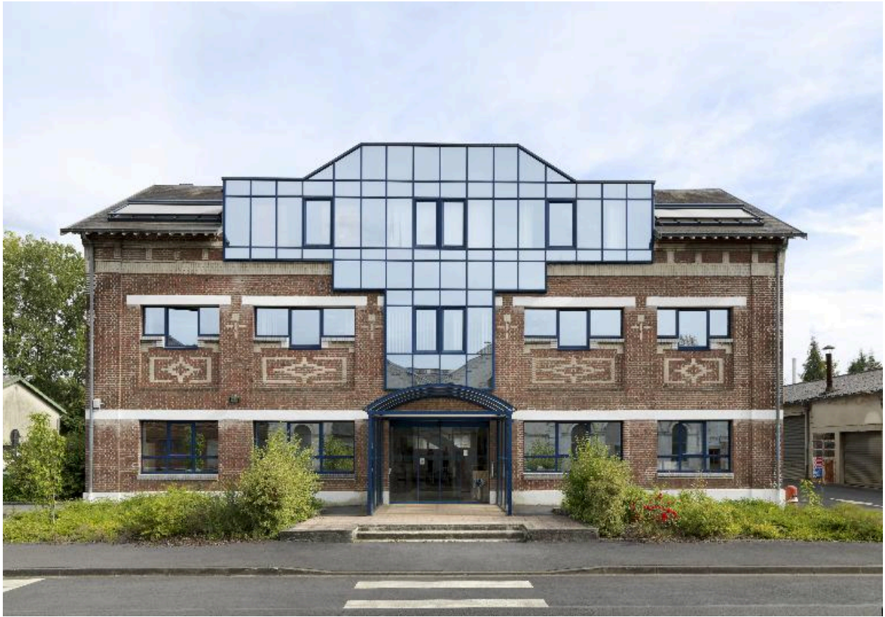
Bâtiment administratif, vue de face.
