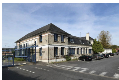
Les bureaux de l'usine, vue de trois-quarts. Phot. Thierry Lefébure IVR32_20160200135NUC2A
