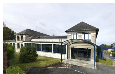
Les bureaux, façade sud. Phot. Thierry Lefébure IVR32_20160200137NUC2AQ
