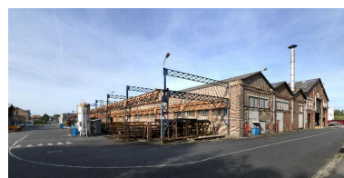
Atelier de chaudronnerie précédé du parc de matières premières, vue d'ensemble sud-est.
