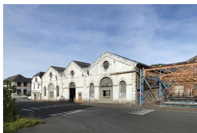
L'atelier de mécanique, vue d'ensemble est. Phot. Thierry Lefébure IVR32_20160200138NUC2A
