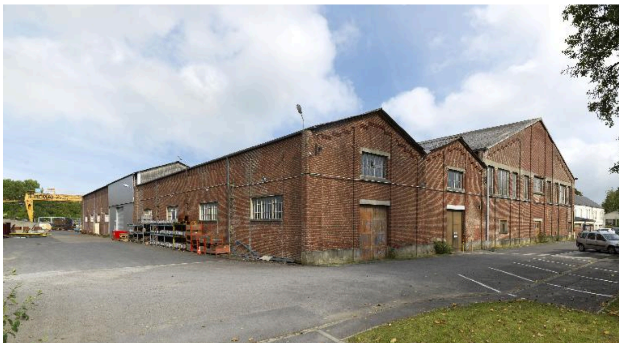
Atelier de mécanique et de chaudronnerie, vue d'ensemble sud-ouest.
