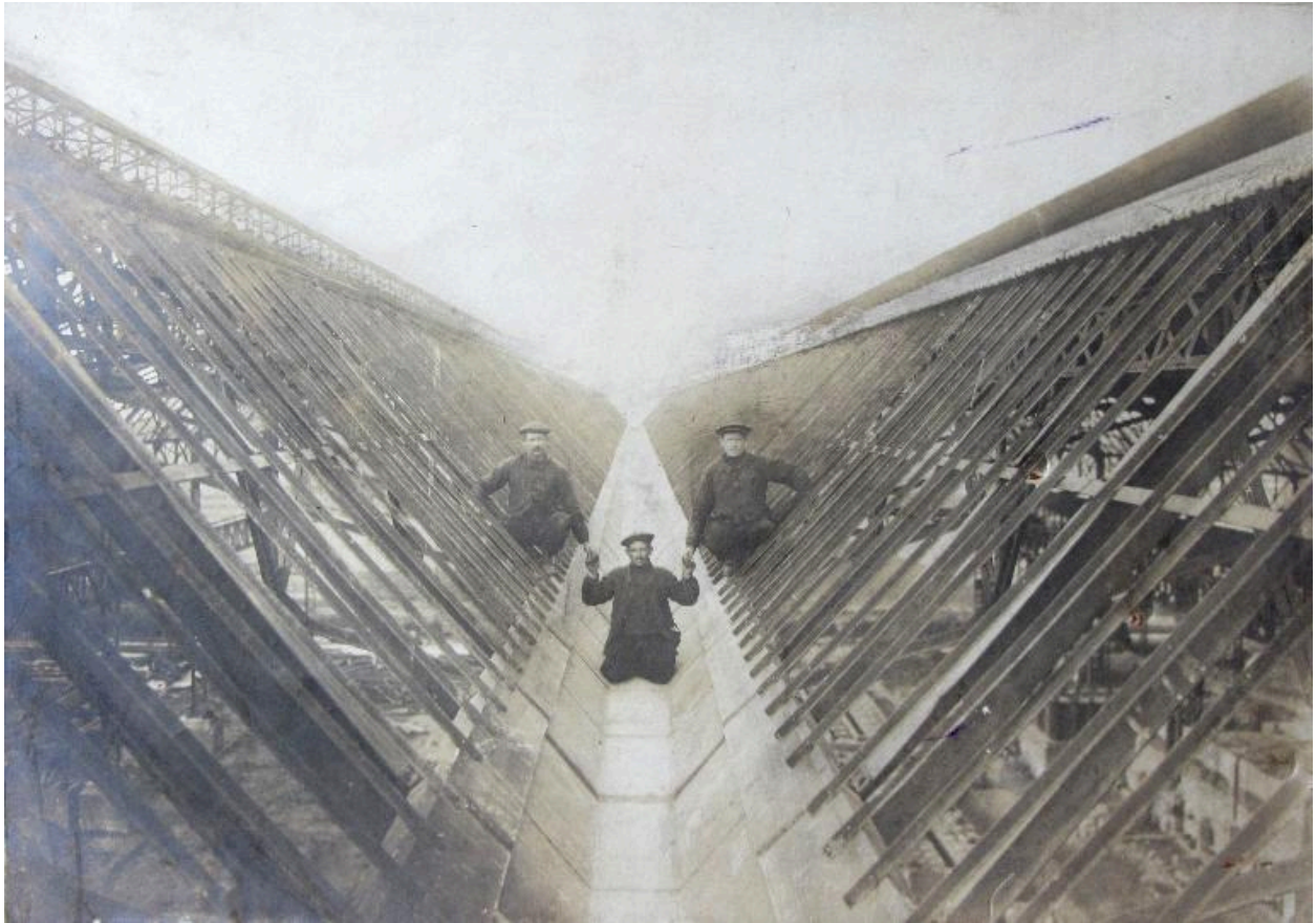
La construction de la charpente métallique des ateliers de l'usine, 1922 (coll. part.).
