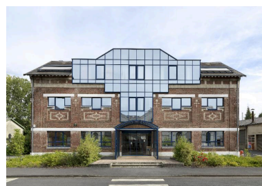
Bâtiment administratif, vue de face.
