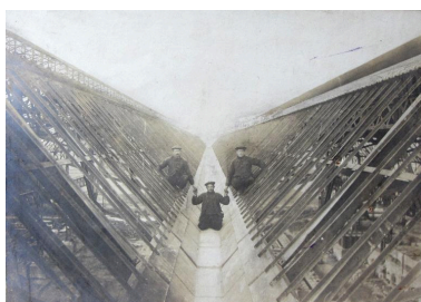
La construction de la charpente métallique des ateliers de l'usine, 1922 (coll. part.). Phot. Fournier Bertrand (reproduction) IVR32_20160205055NUC2A
