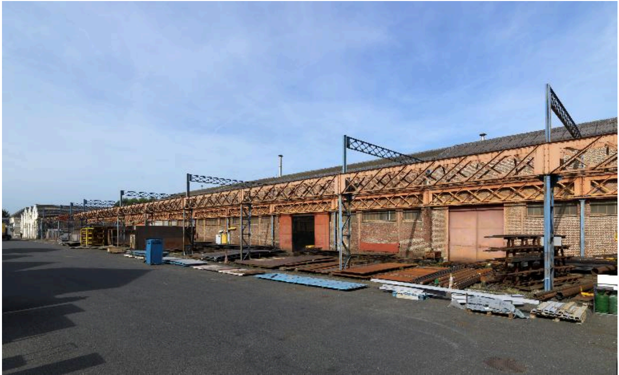
Parc de matières première au sud-est de l'atelier de chaudronnerie, vue d'ensemble.
