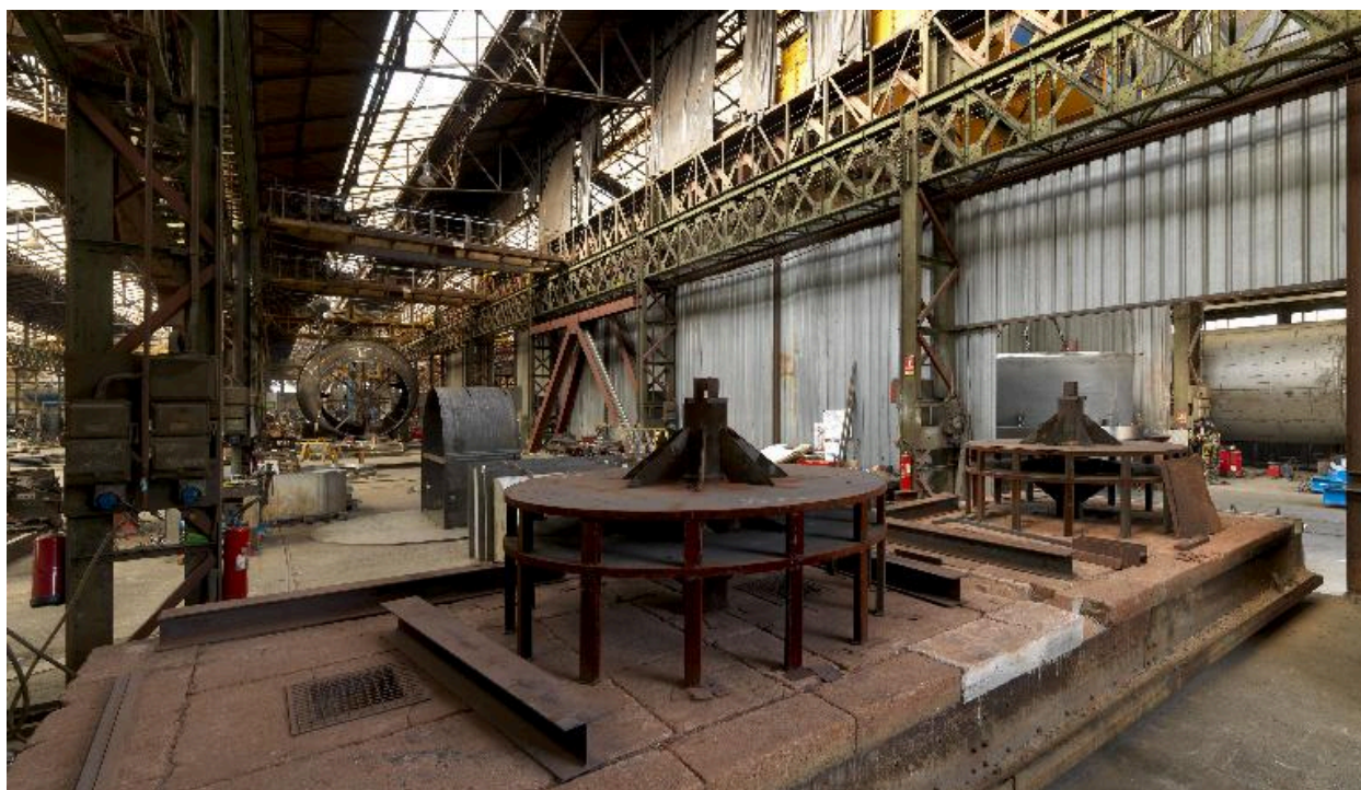
Atelier de chaudronnerie, vue d'ensemble vers l'ouest.
