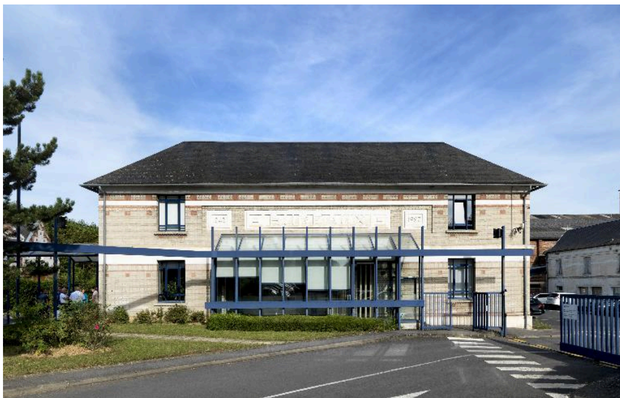
Les bureaux, façade est.
