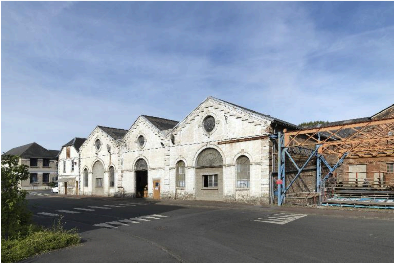
L'atelier de mécanique, vue d'ensemble est.
