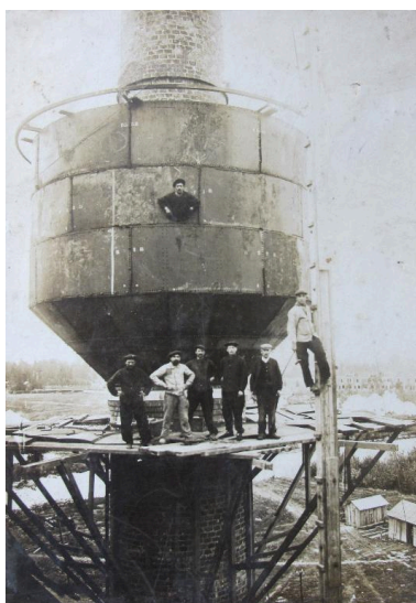
Les ouvriers de l'usine posant au sommet de la cheminée-reservoir en cours de construction, 1922 (coll. part.). Phot. Fournier Bertrand (reproduction) IVR32_20160205056NUC2A
