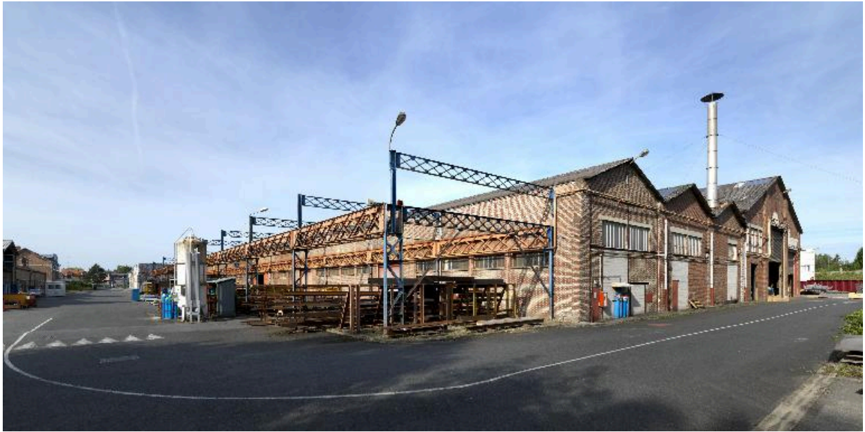
Atelier de chaudronnerie précédé du parc de matières premières, vue d'ensemble sud-est.
