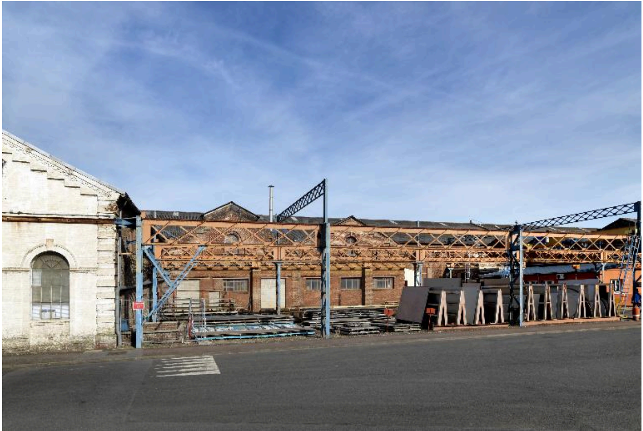
Parc de matières premières, à l'avant de l'atelier de mécanique, détail.
