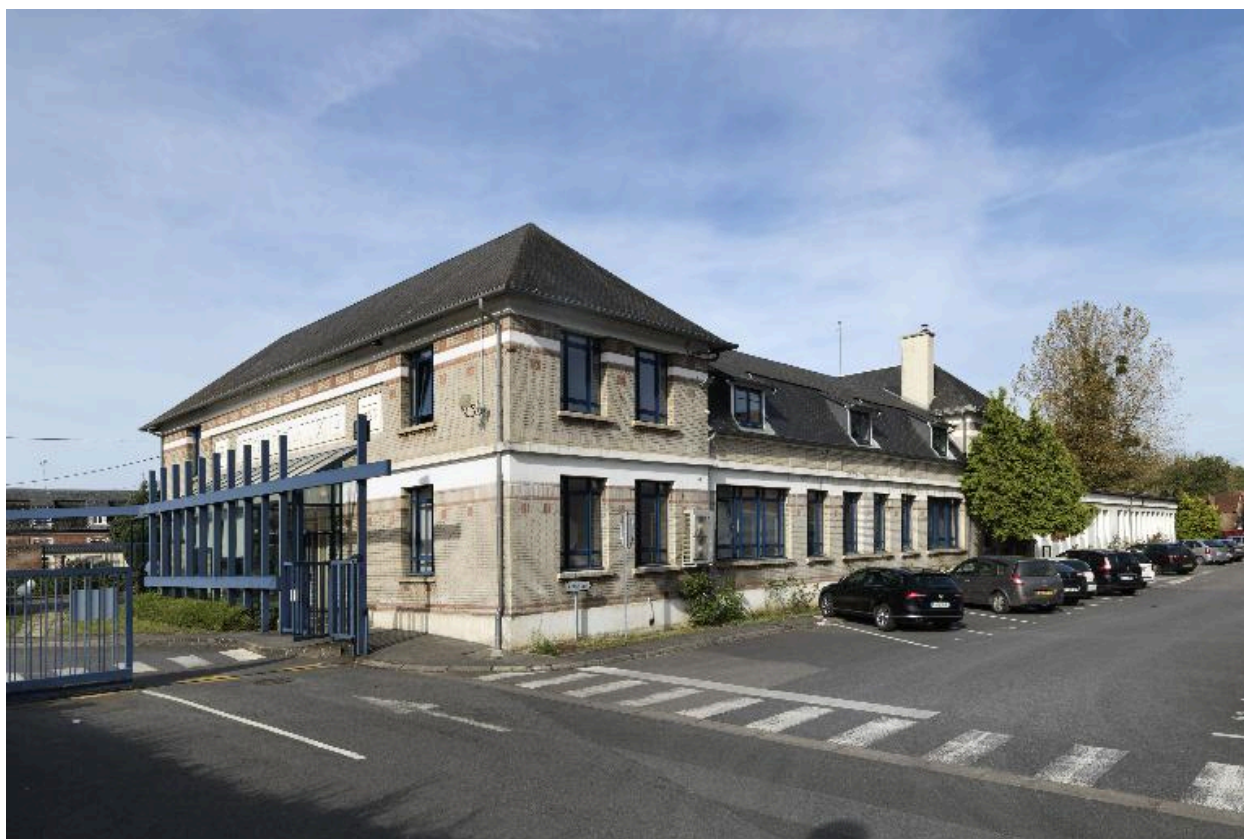
Les bureaux de l'usine, vue de trois-quarts.
