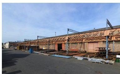
Parc de matières première au sud-est de l'atelier de chaudronnerie, vue d'ensemble. Phot. Thierry Lefébure IVR32_20160200152NUC2A
