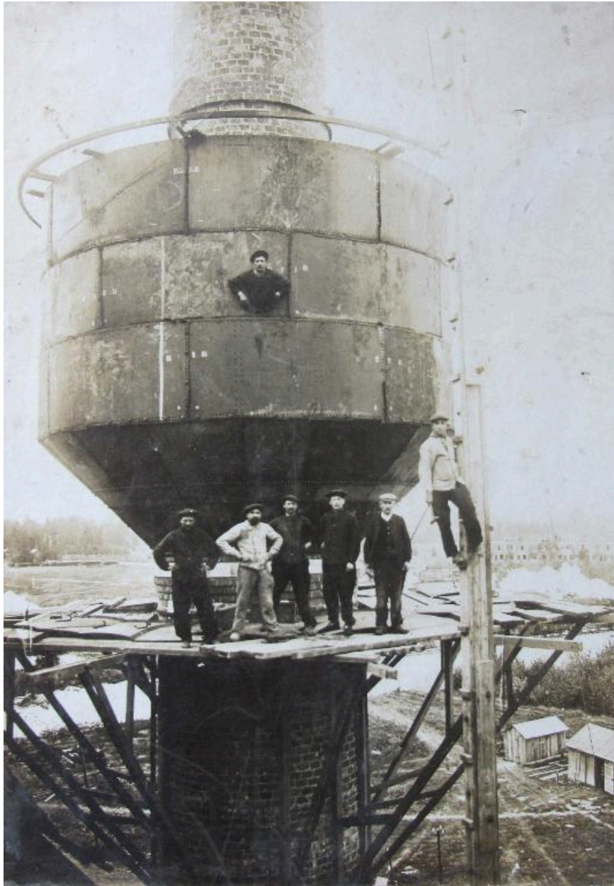
Les ouvriers de l'usine posant au sommet de la cheminée-reservoir en cours de construction, 1922 (coll. part.).
