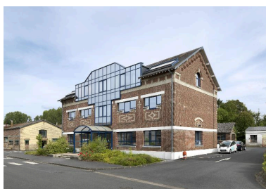
Bâtiment administratif, vue de trois-quarts.
