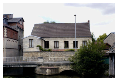
Vue de face de la façade sur rue de la filature, depuis l'îlot sur le Thérain.
