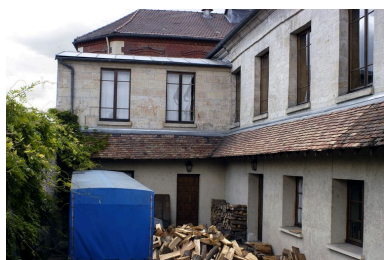
Vue d'ensemble de la filature, façade antérieure, avec son extension en retour. Phot. Thierry Lefébure IVR22_20046000214NUCA
