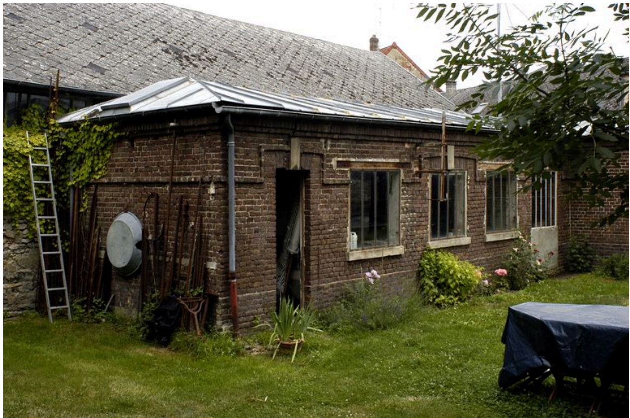
Remise à l'entrée de l'usine, vue d'ensemble.
