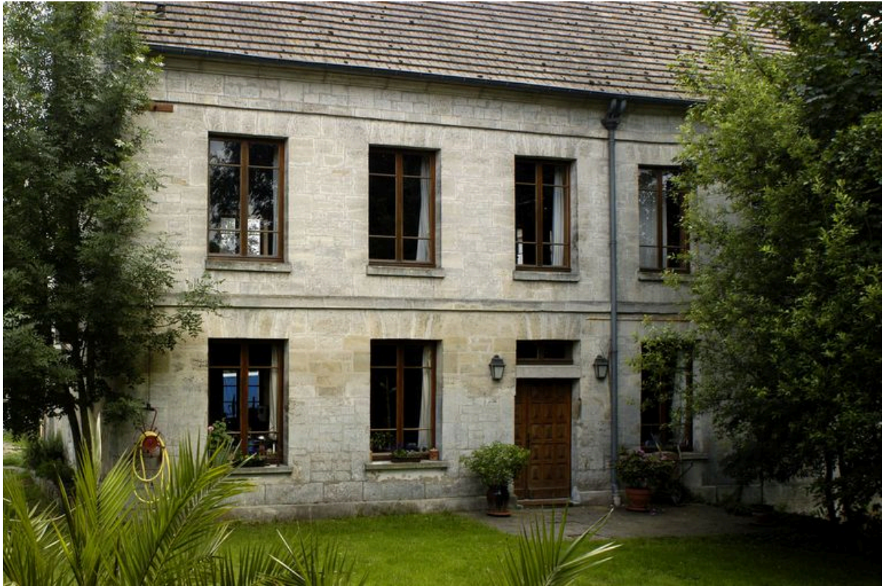
Façade postérieure de la filature.
