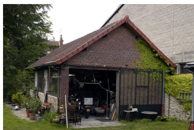
Atelier de montage des brosses. Phot. Thierry Lefébure IVR22_20046000215NUCA
