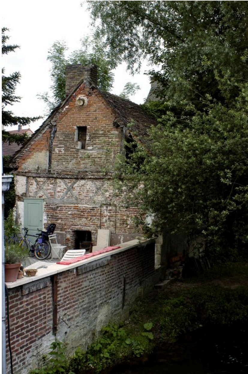
Bâtiment destiné au lavage des laines, vue du pignon depuis le pont sur la rivière.
