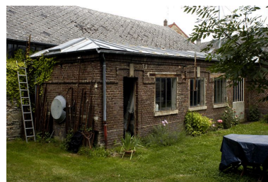
Remise à l'entrée de l'usine, vue d'ensemble. Phot. Thierry Lefébure IVR22_20046000217NUCA
