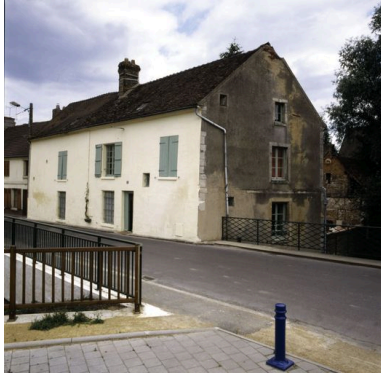
Le logement patronal, façade sur rue. Phot. Thierry Lefébure IVR22_20046000226XA
