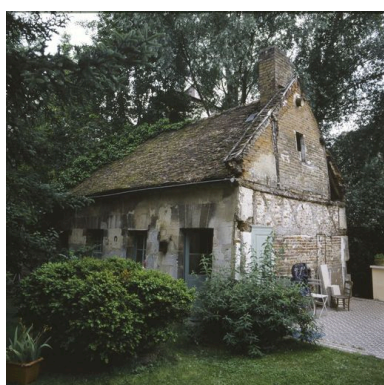
Bâtiment destiné au lavage des laines, vue d'ensemble sur cour. Phot. Thierry Lefébure IVR22_20046000218XA
