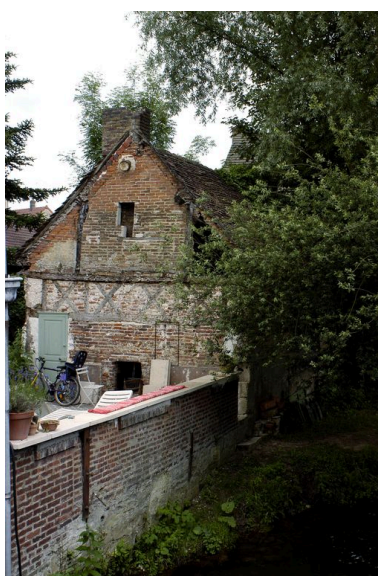
Bâtiment destiné au lavage des laines, vue du pignon depuis le pont sur la rivière. Phot. Thierry Lefébure IVR22_20046000223NUCA
