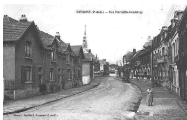
Bapaume (P.-de-C.). Rue Marcellin-Godefroy. Photo J. Souillard, Bapaume. Carte postale, vers 1930 (coll. part.). Les maisons groupées de M. Théry sont visibles à l'arrière plan à gauche. Phot. Bouvet Hubert IVR32_20196201046NUC1A
