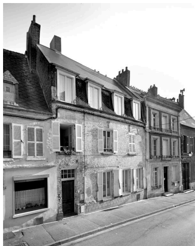
Vue de la façade sur rue. Phot. Thierry Lefébure IVR22_19990205988V
