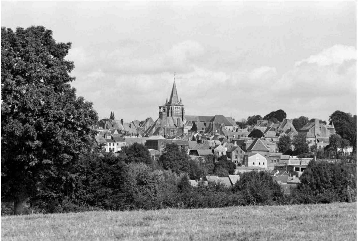
Vue générale, depuis le sud.
