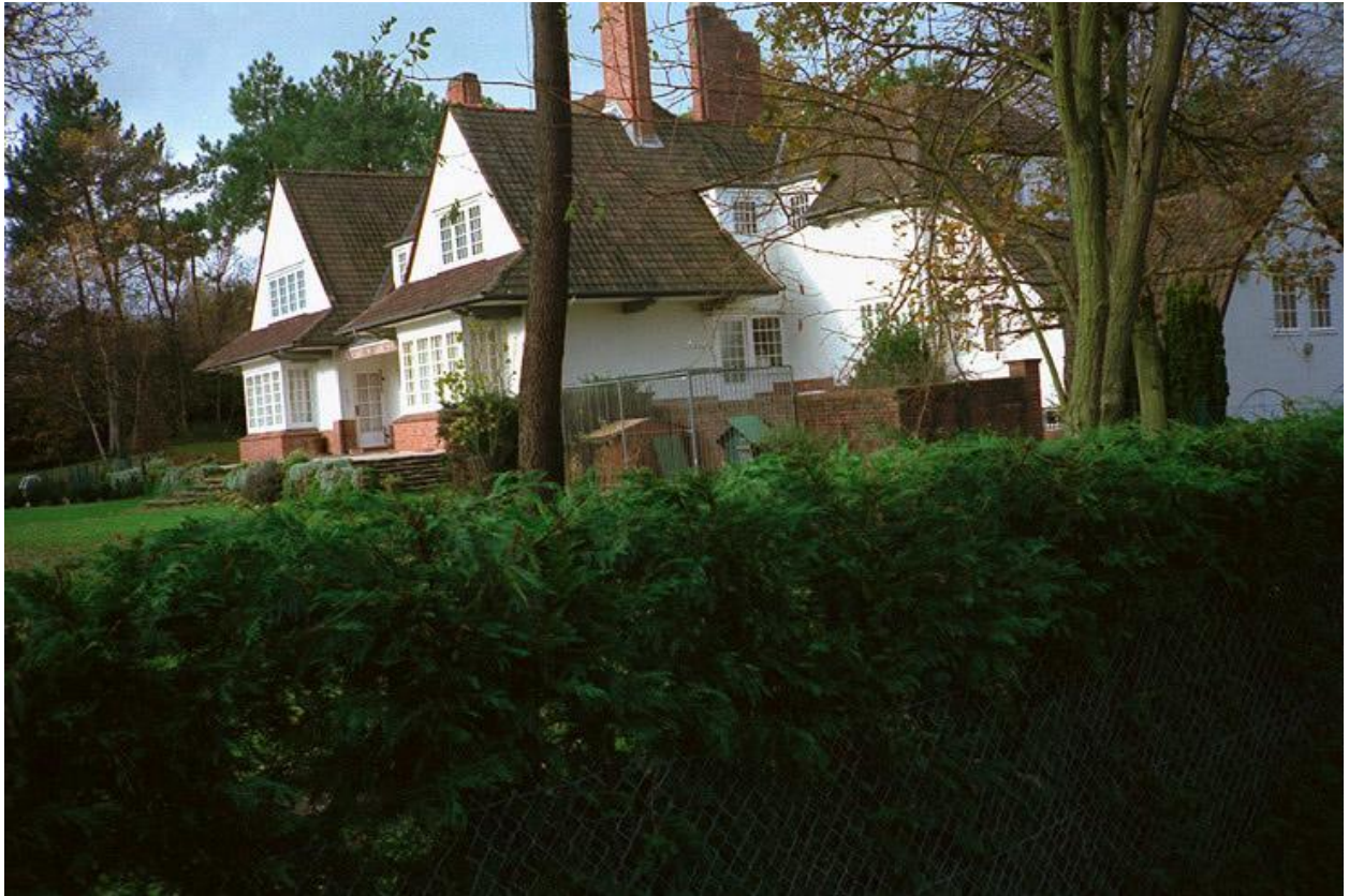
Vue d' ensemble latérale.
