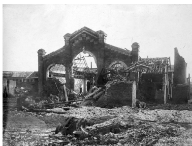
Façade antérieure de la fonderie, 1919 (AD Aisne). Phot. Pillet Frédéric IVR22_20060205372NUCAB
