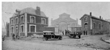
L'usine reconstruite, vers 1921 (Le Monde Illustré). Phot. Pillet Frédéric IVR22_20060205376NUCAB
