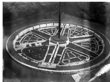
Préparation d'un moule pour la coulée d'un tambour d'enroulement, vers 1919-1921 (AD Aisne).
