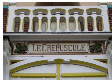
Détail du décor de céramique et du balcon situés au-dessus de la porte de la villa Le Crépuscule (n°74). Phot. Elisabeth Justome IVR22_20048001386NUCA
