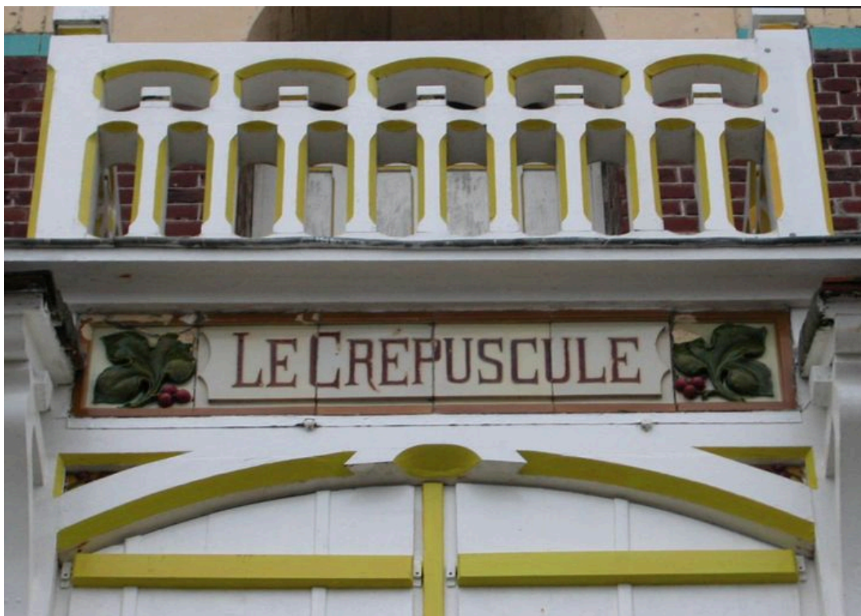
Détail du décor de céramique et du balcon situés au-dessus de la porte de la villa Le Crépuscule (n°74).
