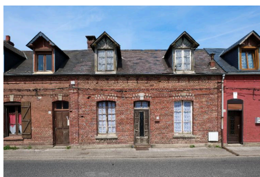
Vue d'un logement de contremaître ou d'ouvrier qualifié. Phot. Thierry Lefébure IVR22_20138000134NUC2A
