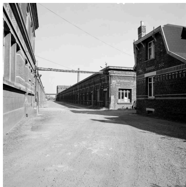
Vue en enfilade vers le nord entre les bureaux et le tissage à gauche, la conciergerie sud et le magasin aux fils, à droite. Phot. Philippe Dapvril IVR31_19885901224X
