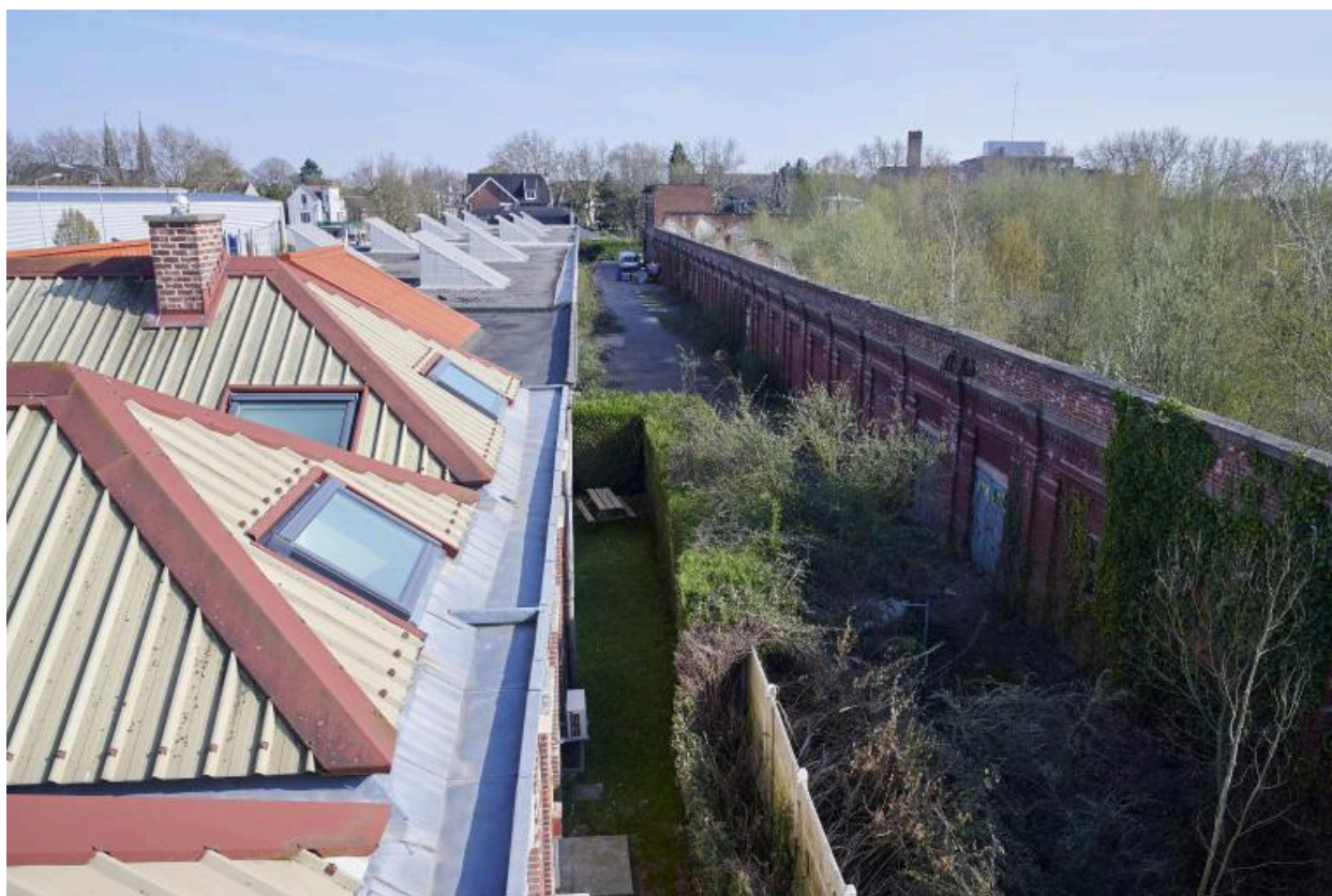
Le magasin aux fils à gauche et les vestiges du tissage à droite. Vue prise depuis le couverture vers le sud.
