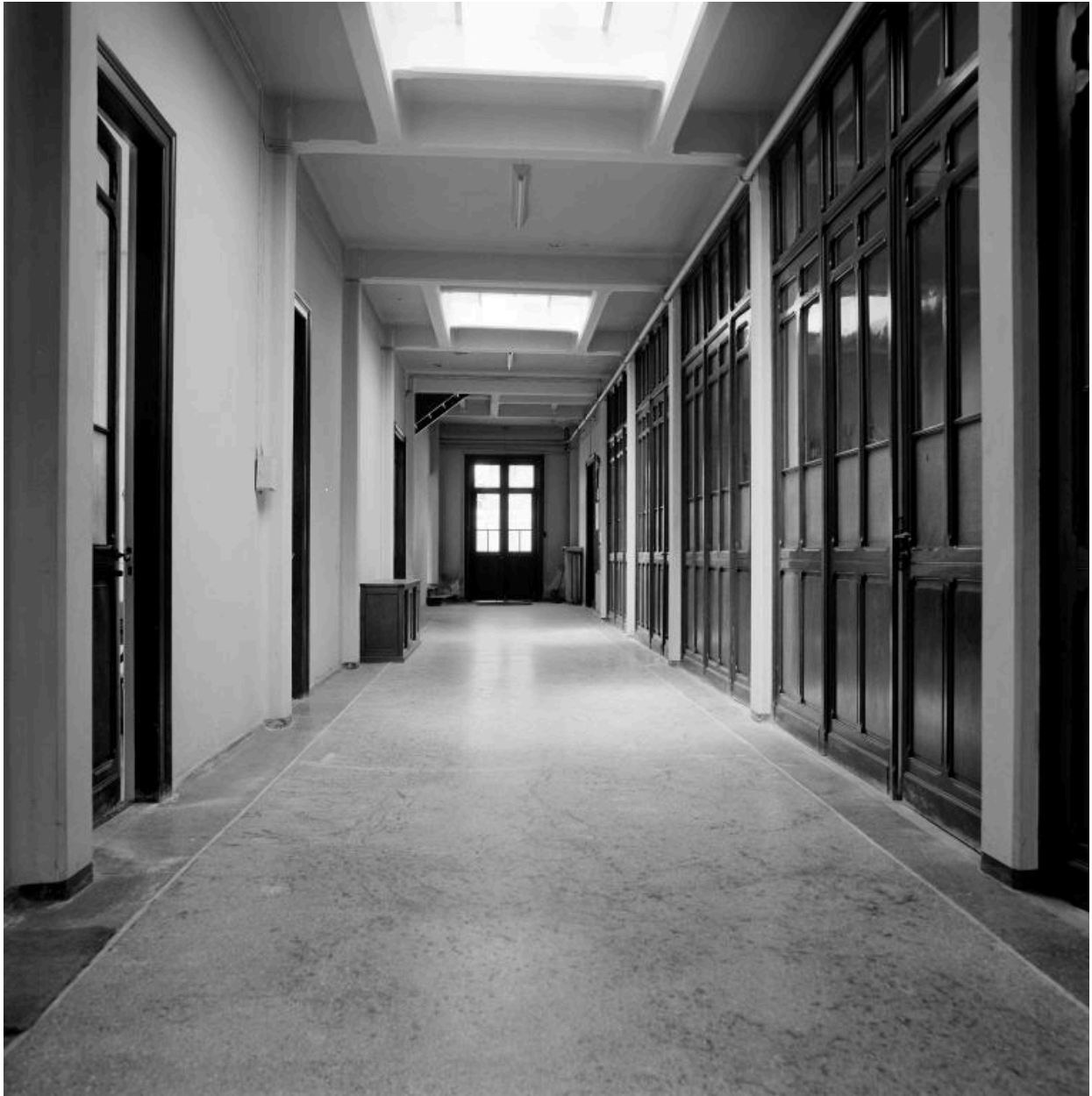
Bureaux. Couloir longitudinal.
