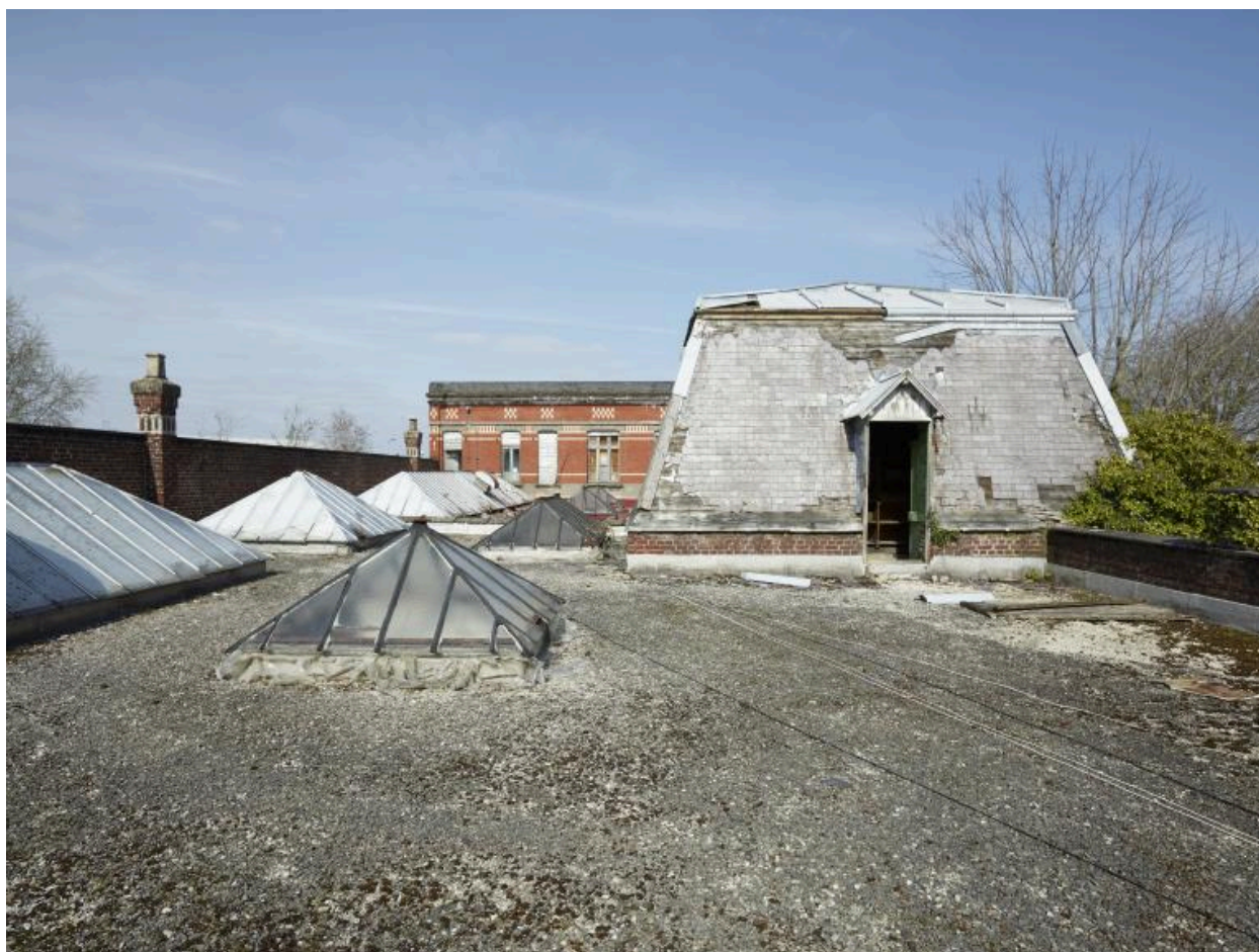
Bureaux. Couvrement. Vue prise vers l'est.
