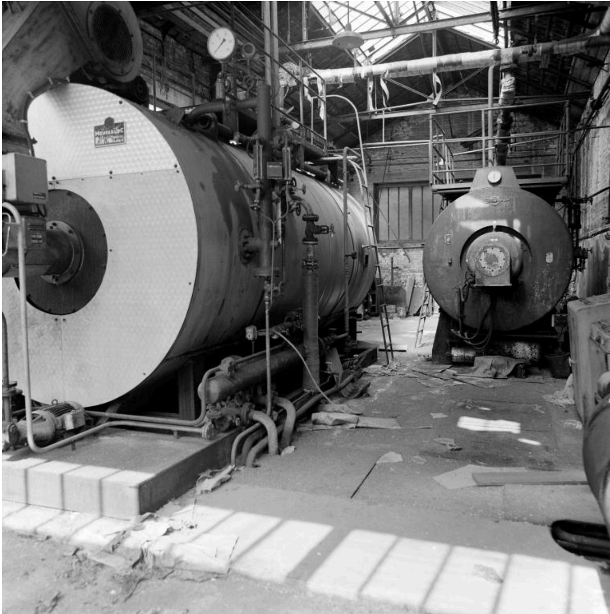
Chaufferie, vue intérieure. Chaudières.
