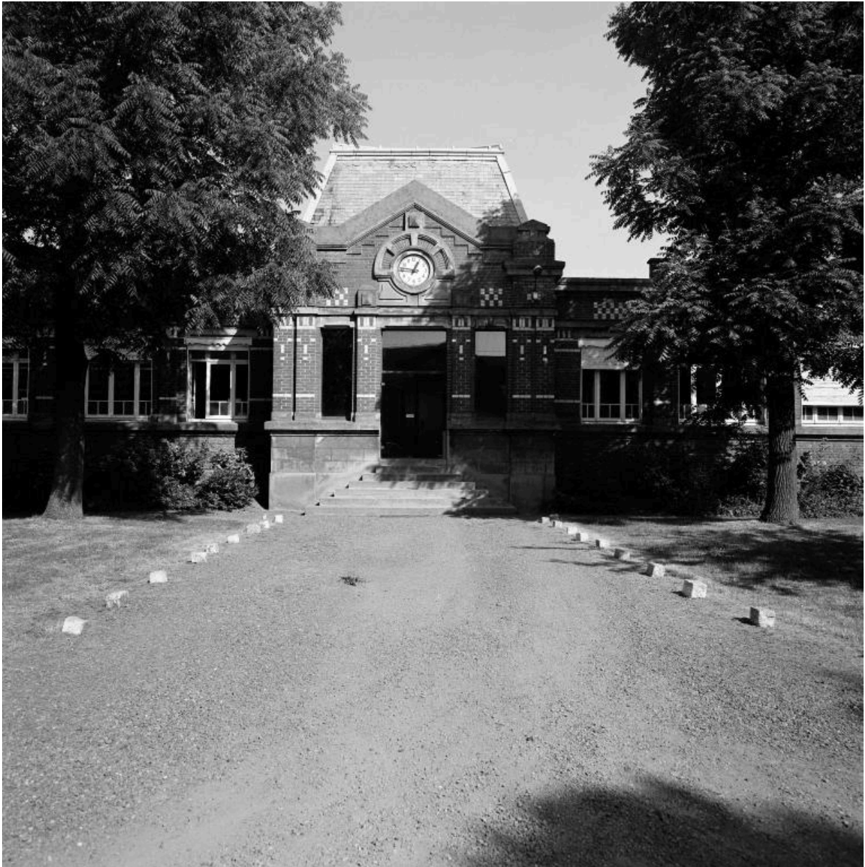
Bureaux vus depuis l'entrée. Corps central.
