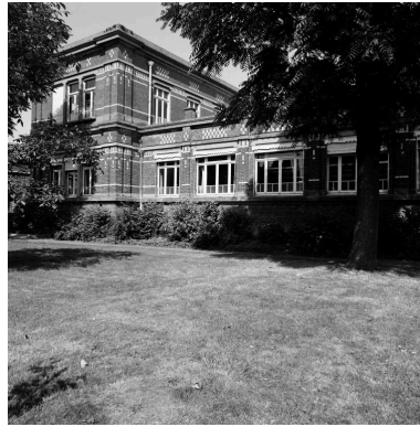
Bureaux. Aile ouest vue depuis la cour. Phot. Philippe Dapvril IVR31_19885901266X
