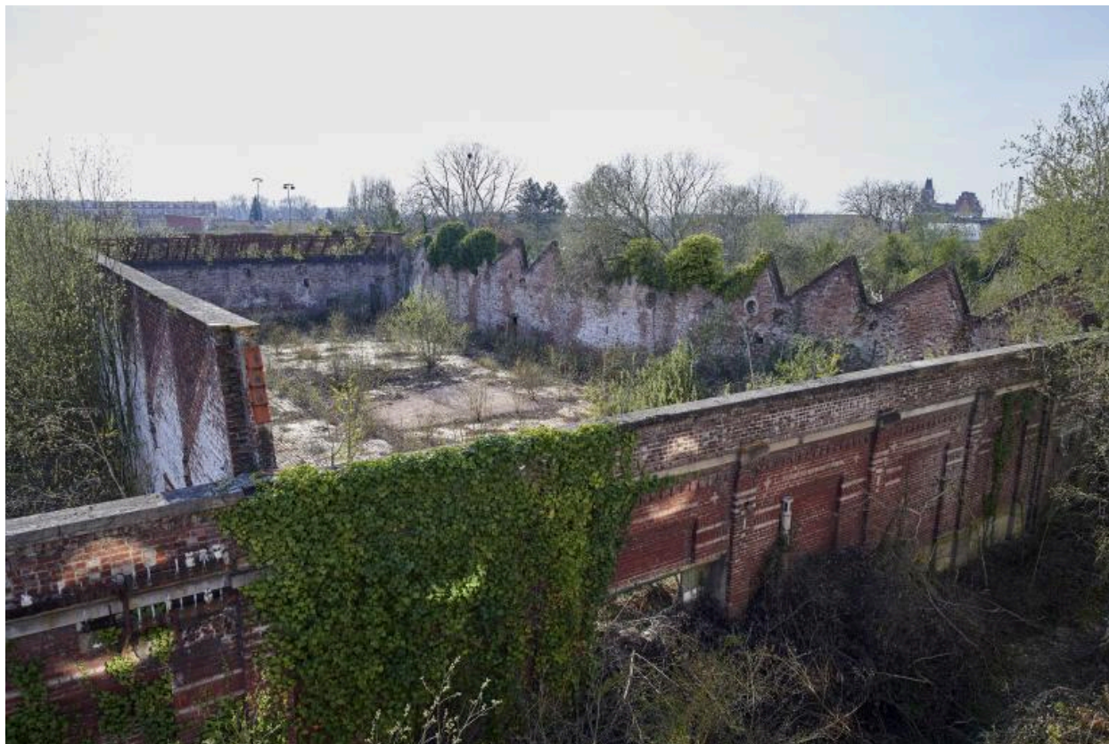
Vestiges sud du tissage. Vue prise vers l'ouest, depuis le couvrement du magasin aux fils.
