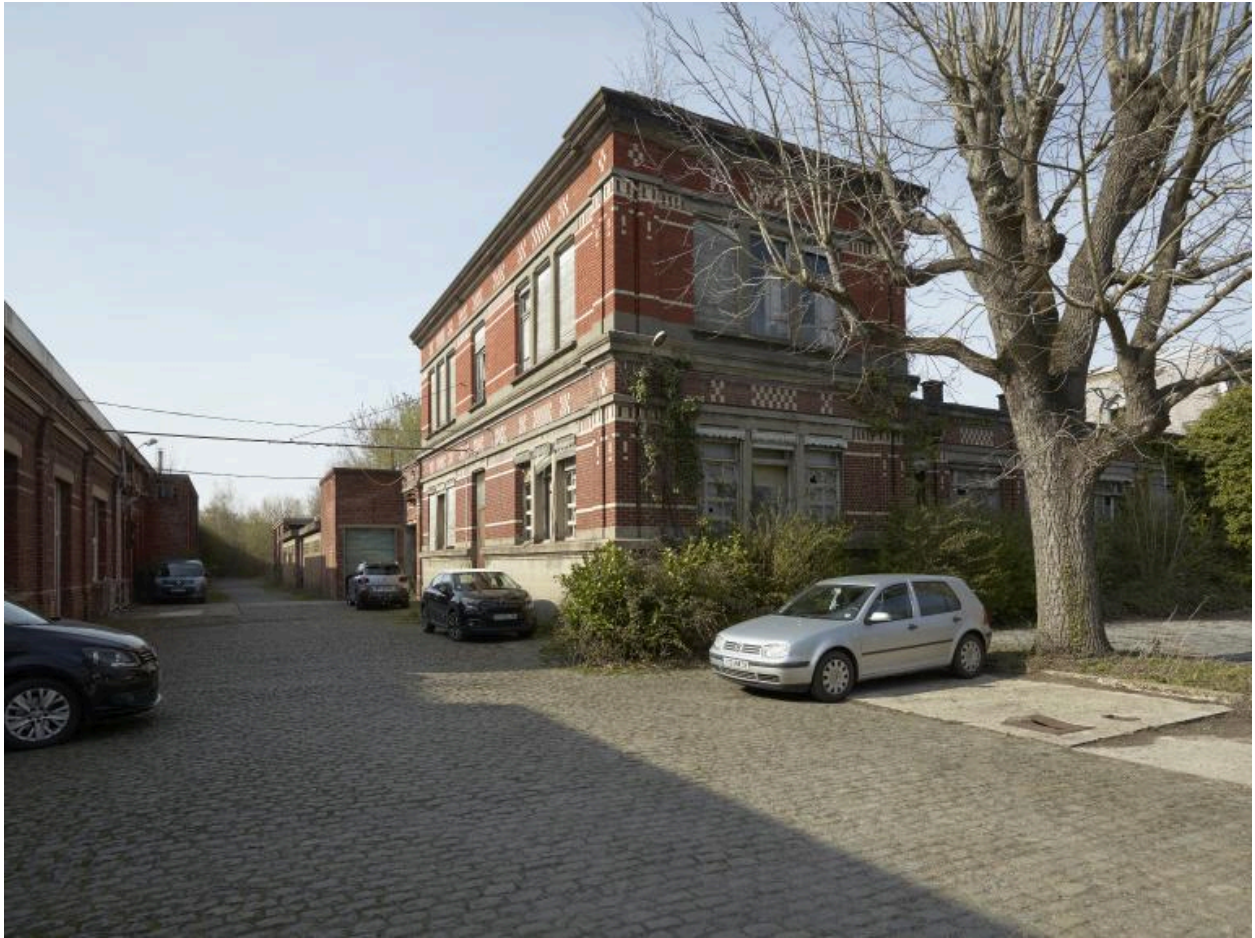
Aile ouest des bureaux, au centre. À gauche, le magasin aux toiles.
