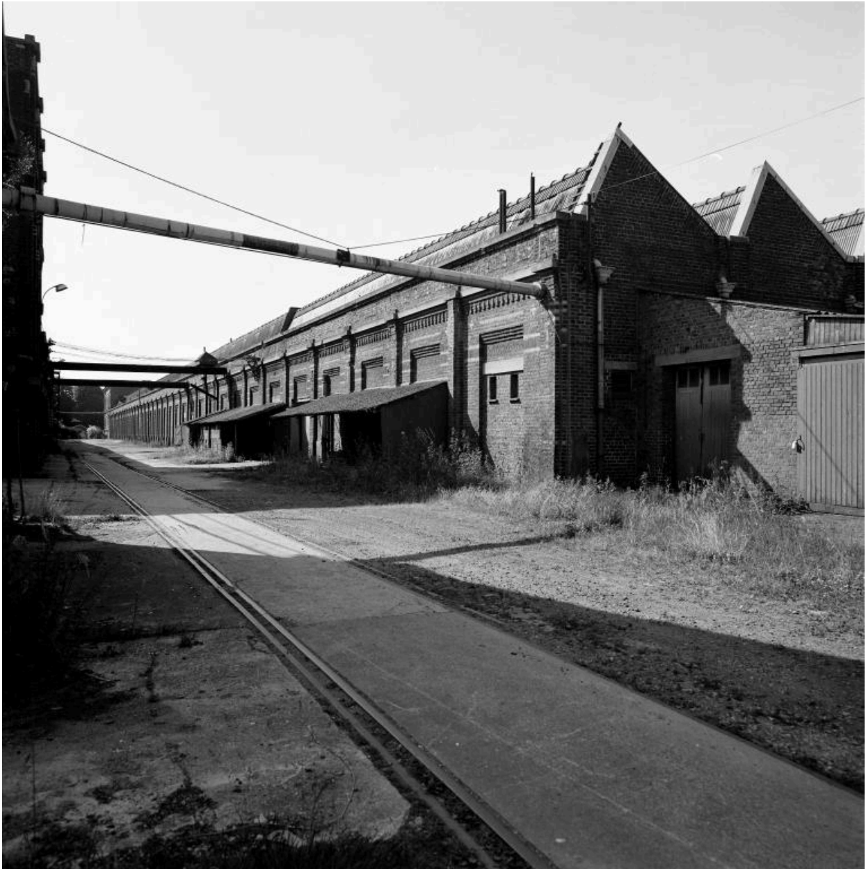
Tissage, élévation ouest. Vue prise vers le sud.
