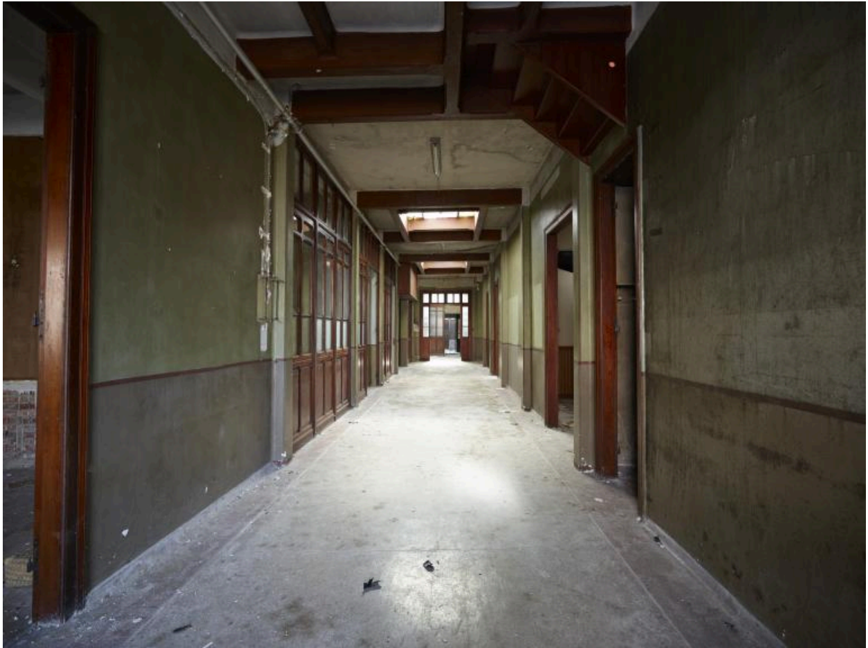
Bureaux. Couloir longitudinal vers l'ouest.
