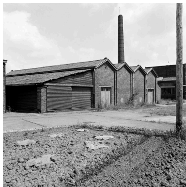
Hangar aux bois et menuiserie. Vue prise vers l'est. Phot. Philippe Dapvril IVR31_19885901249X
