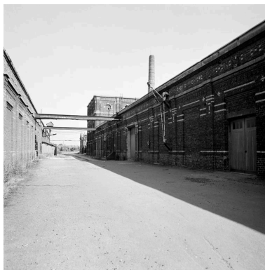
Vue en enfilade vers le nord entre le tissage à gauche et le magasin aux fils à droite. Phot. Philippe Dapvril IVR31_19885901223X
