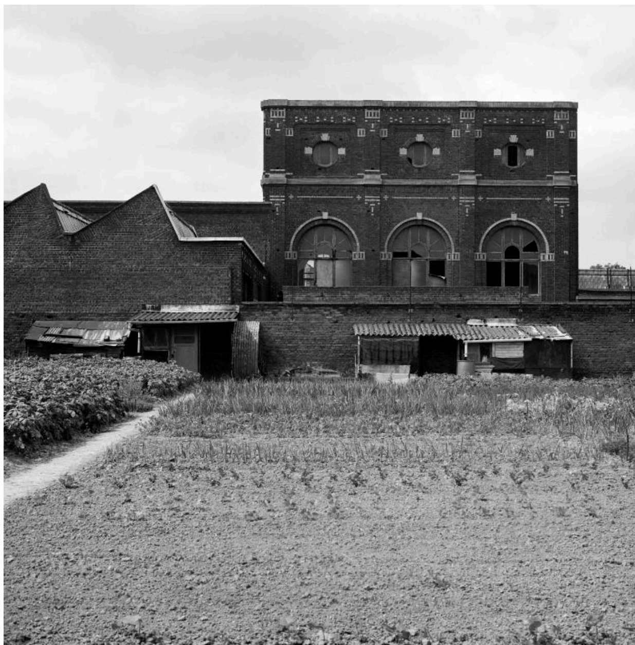
Vue générale depuis les jardins ouvriers, vers le sud-est. La salle des machines, élévation ouest.
