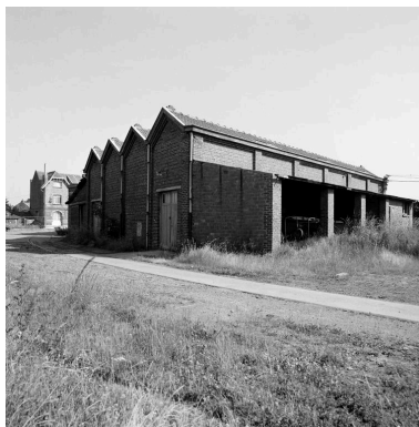
Menuiserie, conciergerie nord. Vue prise vers le nord. Phot. Philippe Dapvril IVR31_19885901219X
