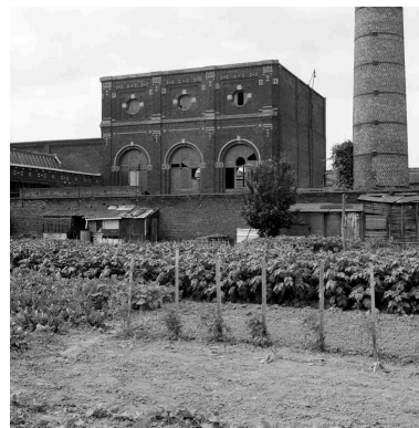
Vue générale depuis les jardins ouvriers, vers le sud-est. La salle des machines et la cheminée. Phot. Philippe Dapvril IVR31_19885901256X
