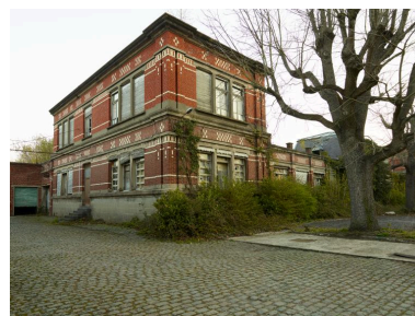
Vue de trois quarts des bureaux. Vue prise vers le nord. Phot. Delphine Volto-Jourdan IVR32_20215900040NUCA
