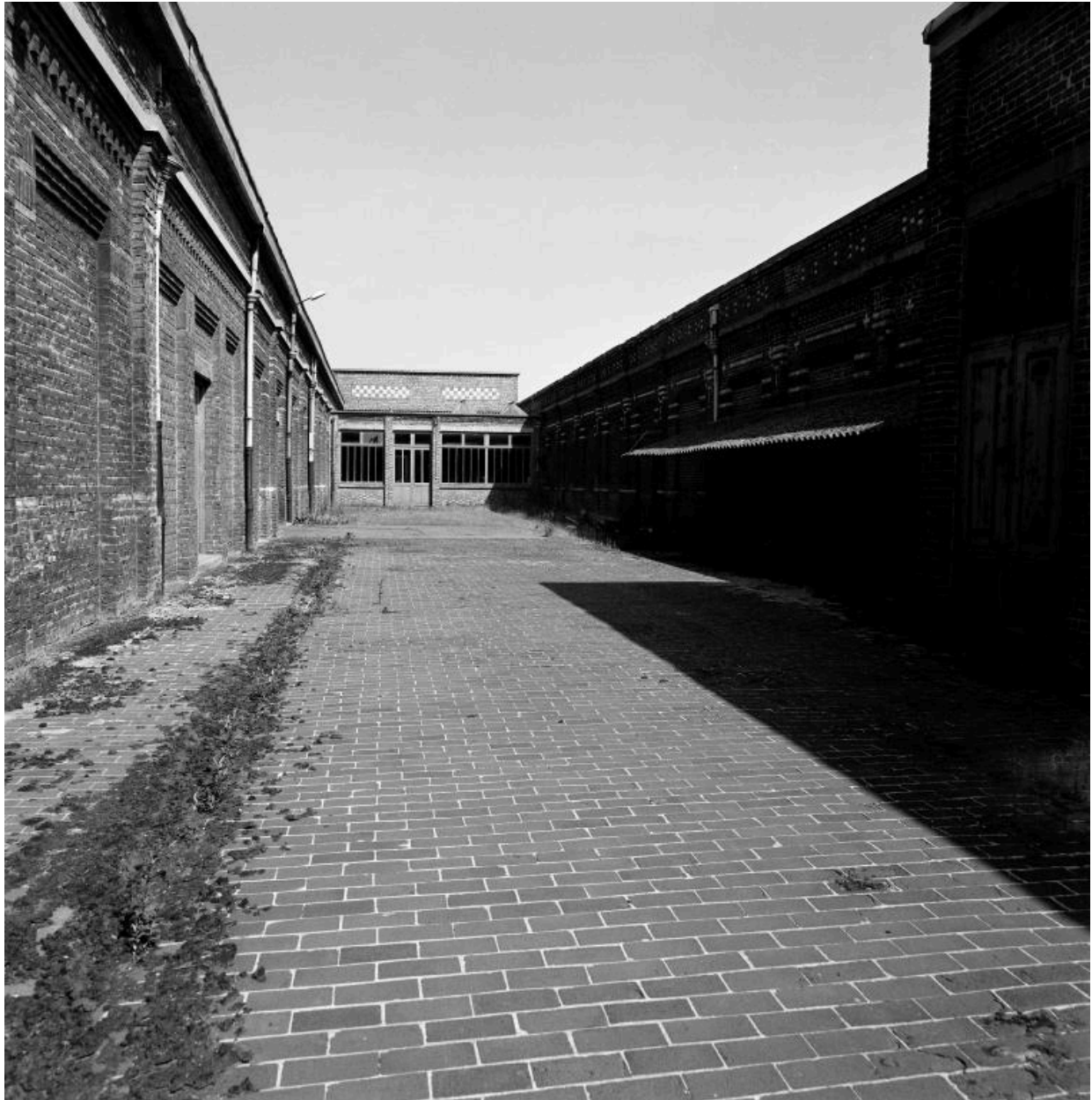
Vue en enfilade prise vers le nord, entre les bureaux et le magasin aux toiles à gauche et le tissage à droite.
