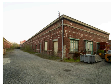
Vue prise vers le nord entre le tissage à gauche et le magasin aux fils à droite. Phot. Delphine Volto-Jourdan IVR32_20215900045NUCA
