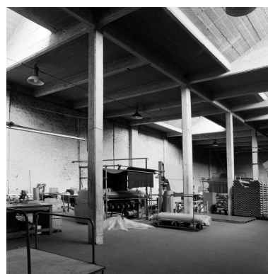
Magasin aux toiles, vue intérieure. Phot. Philippe Dapvril IVR31_19885901283X
