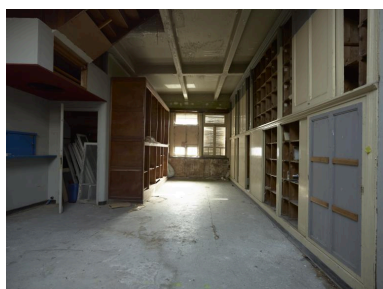
Bureaux. Salle des archives au premier étage. Phot. Delphine Volto-Jourdan IVR32_20215900019NUCA
