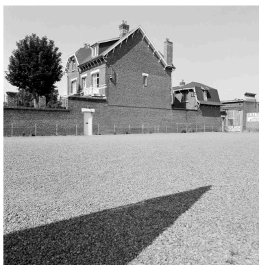
Logement patronal. Vue prise depuis la rue, vers l'ouest. Phot. Philippe Dapvril IVR31_19885901282X
