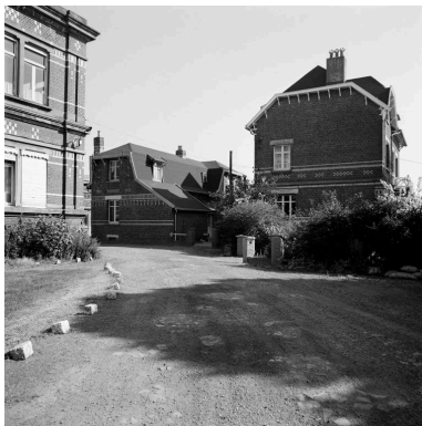
Conciergerie au sud et logement patronal vus depuis la cour. Phot. Philippe Dapvril IVR31_19885901226X
