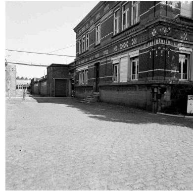
Bureaux. Aile ouest, pignon ouest. Phot. Philippe Dapvril IVR31_19885901267X
