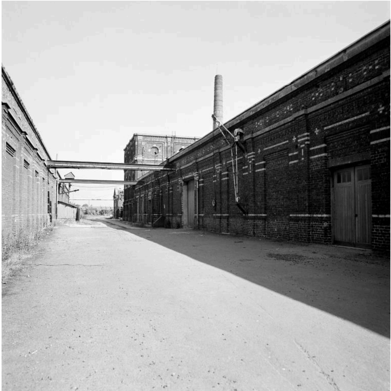
Vue en enfilade vers le nord entre le tissage à gauche et le magasin aux fils à droite.
