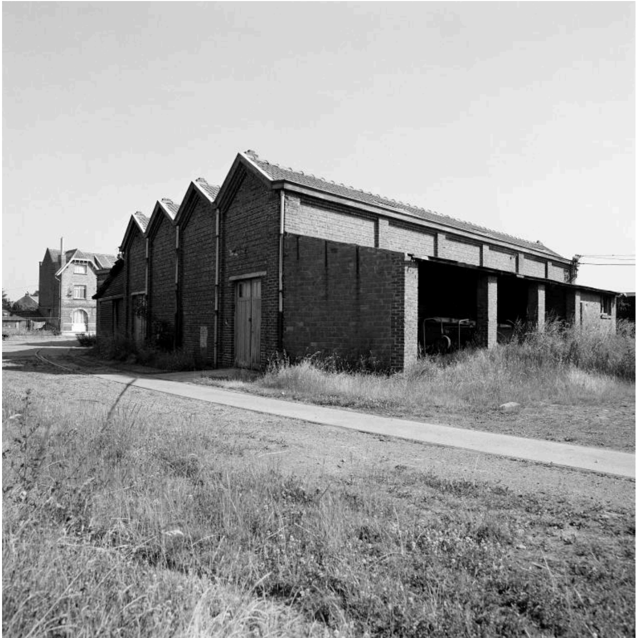
Menuiserie, conciergerie nord. Vue prise vers le nord.
