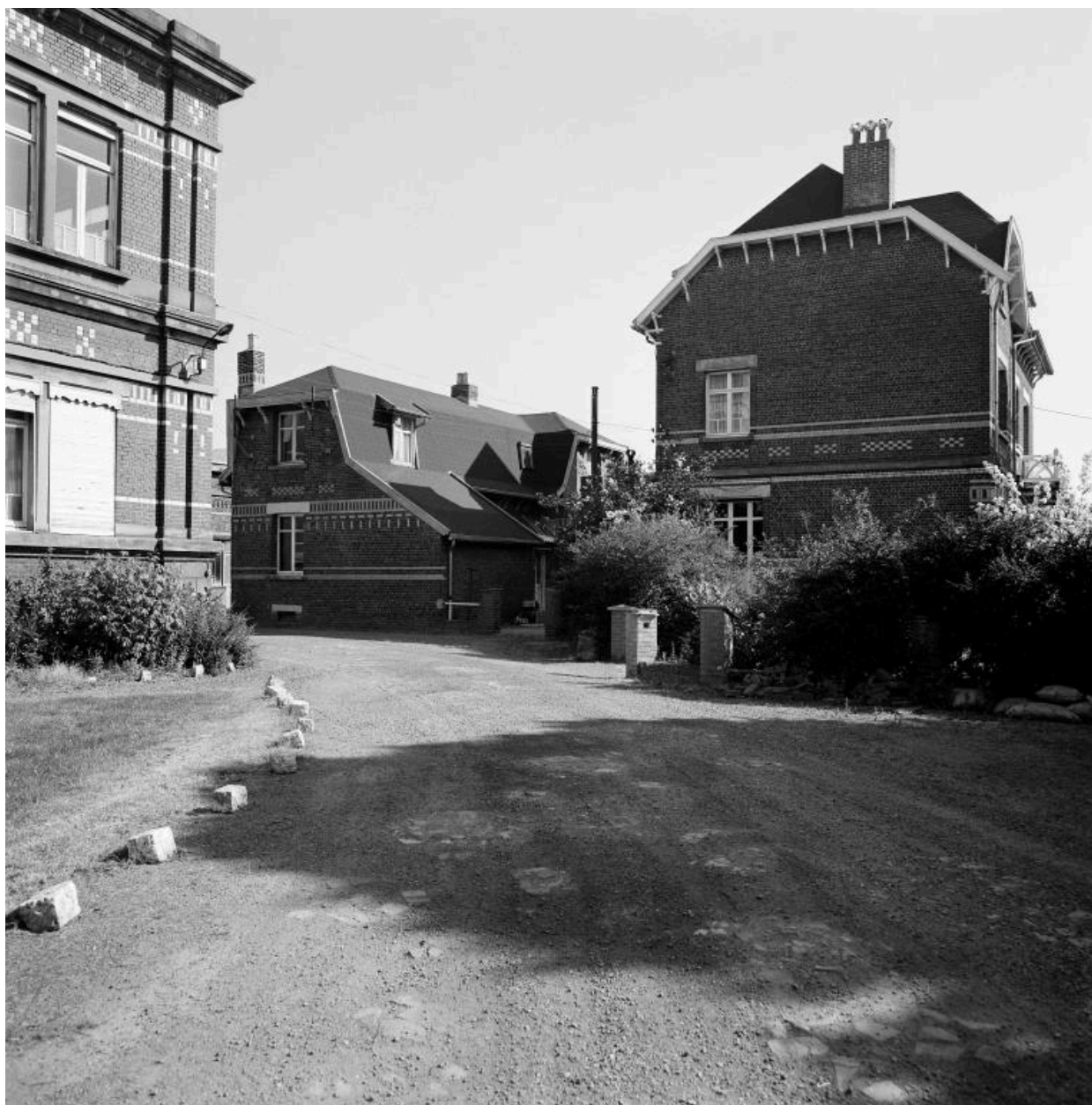
Conciergerie au sud et logement patronal vus depuis la cour.
