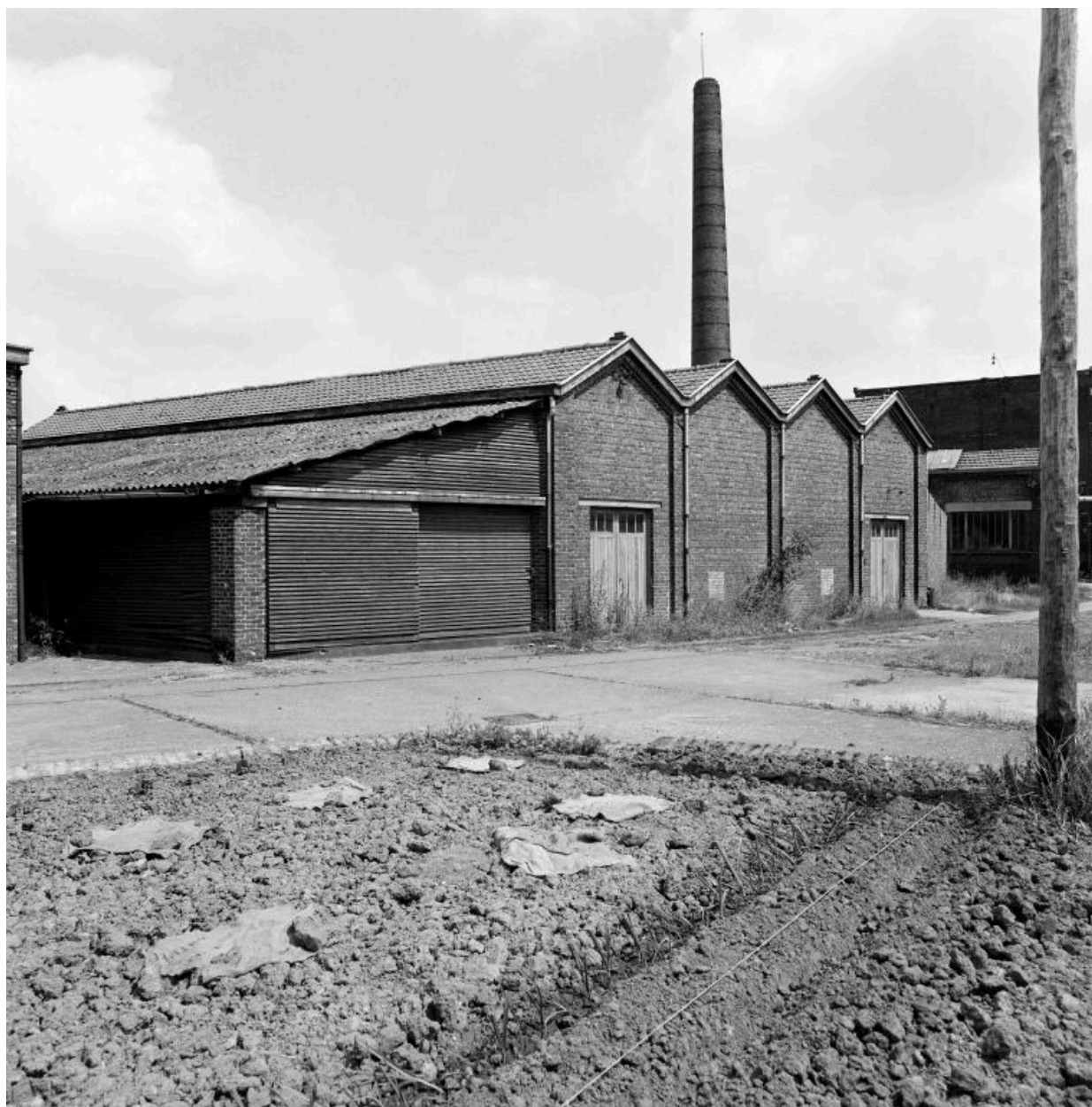
Hangar aux bois et menuiserie. Vue prise vers l'est.
