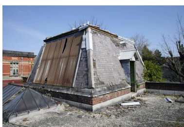
Bureaux. Vue du lanterneau depuis le couvrement. Phot. Delphine Volto-Jourdan IVR32_20215900034NUCA
