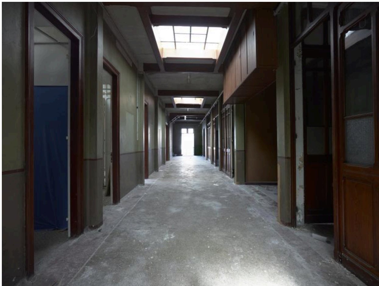
Bureaux. Couloir longitudinal vers l'est.
