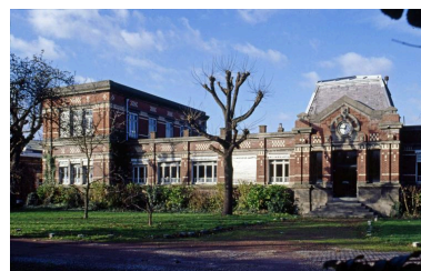
Corps central et aile ouest des bureaux depuis la cour (1996). Phot. Thierry Petitberghien IVR31_19965901538ZA
