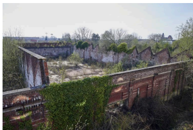
Vestiges sud du tissage. Vue prise vers l'ouest, depuis le couvrement du magasin aux fils. Phot. Delphine Volto-Jourdan IVR32_20215900037NUCA
