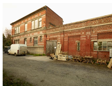
Pignon est des bureaux. Vue prise vers le sud.
