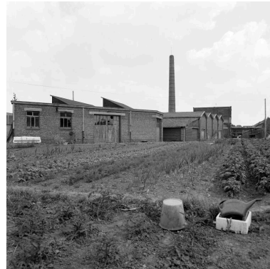
Vue générale vers le sud, prise depuis les jardins ouvriers. De gauche à droite : hangar aux bois, menuiserie, chaufferie, cheminée et salle des machines. Phot. Philippe Dapvril IVR31_19885901250X
