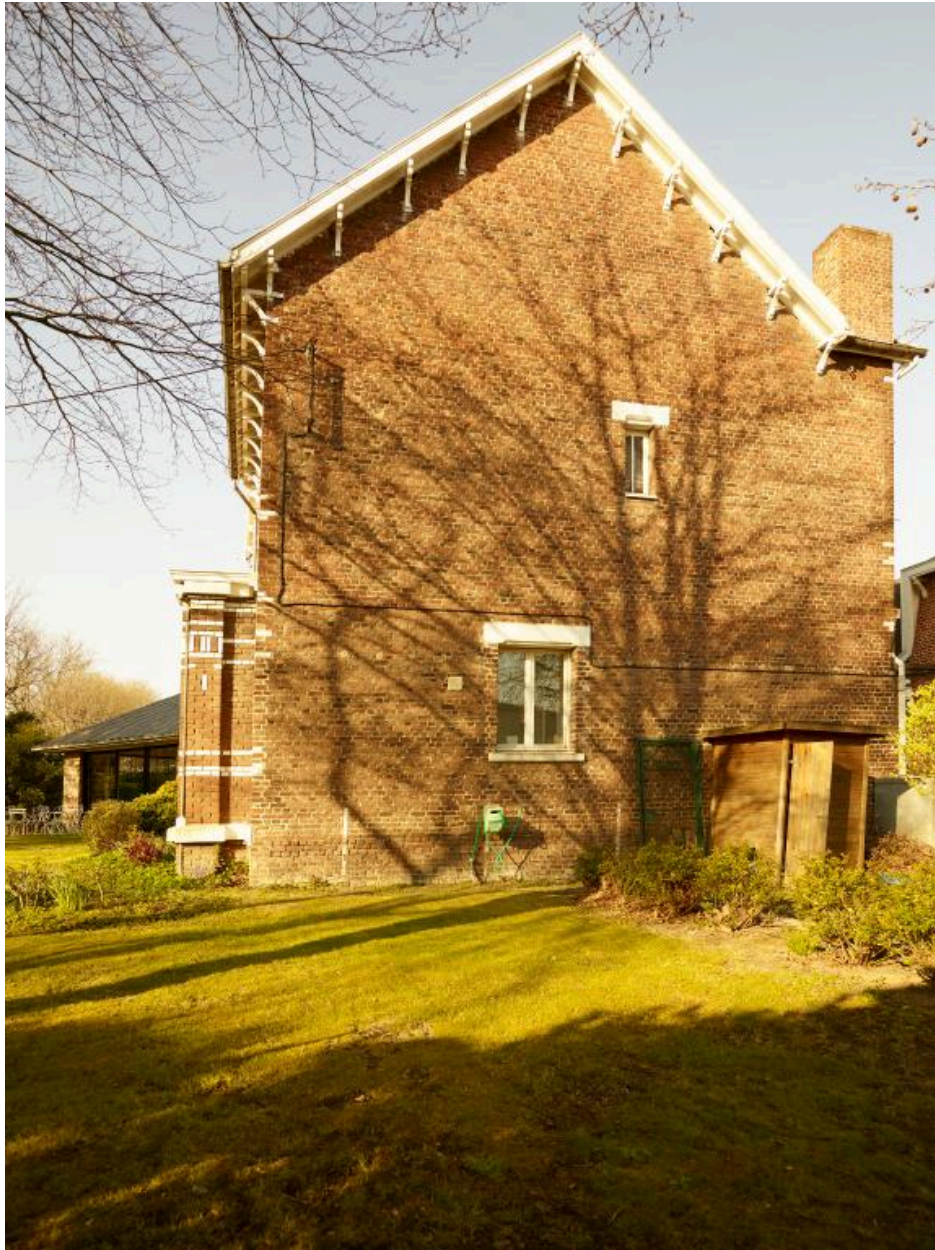
Logement patronal, pignon ouest.
