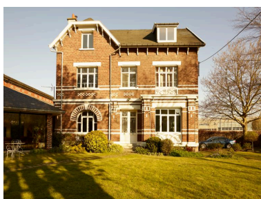
Logement patronal, élévation sud. Phot. Delphine Volto-Jourdan IVR32_20215900050NUCA
