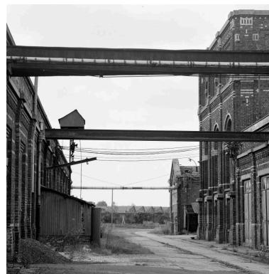
Vue vers le nord entre le tissage, à gauche, et la salle des machines, à droite, reliés par un palan monorail. Phot. Philippe Dapvril IVR31_19885901252X
