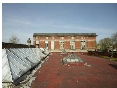
Bureaux. Couvrement. Vue prise vers l'est. Phot. Delphine Volto-Jourdan IVR32_20215900022NUCA
