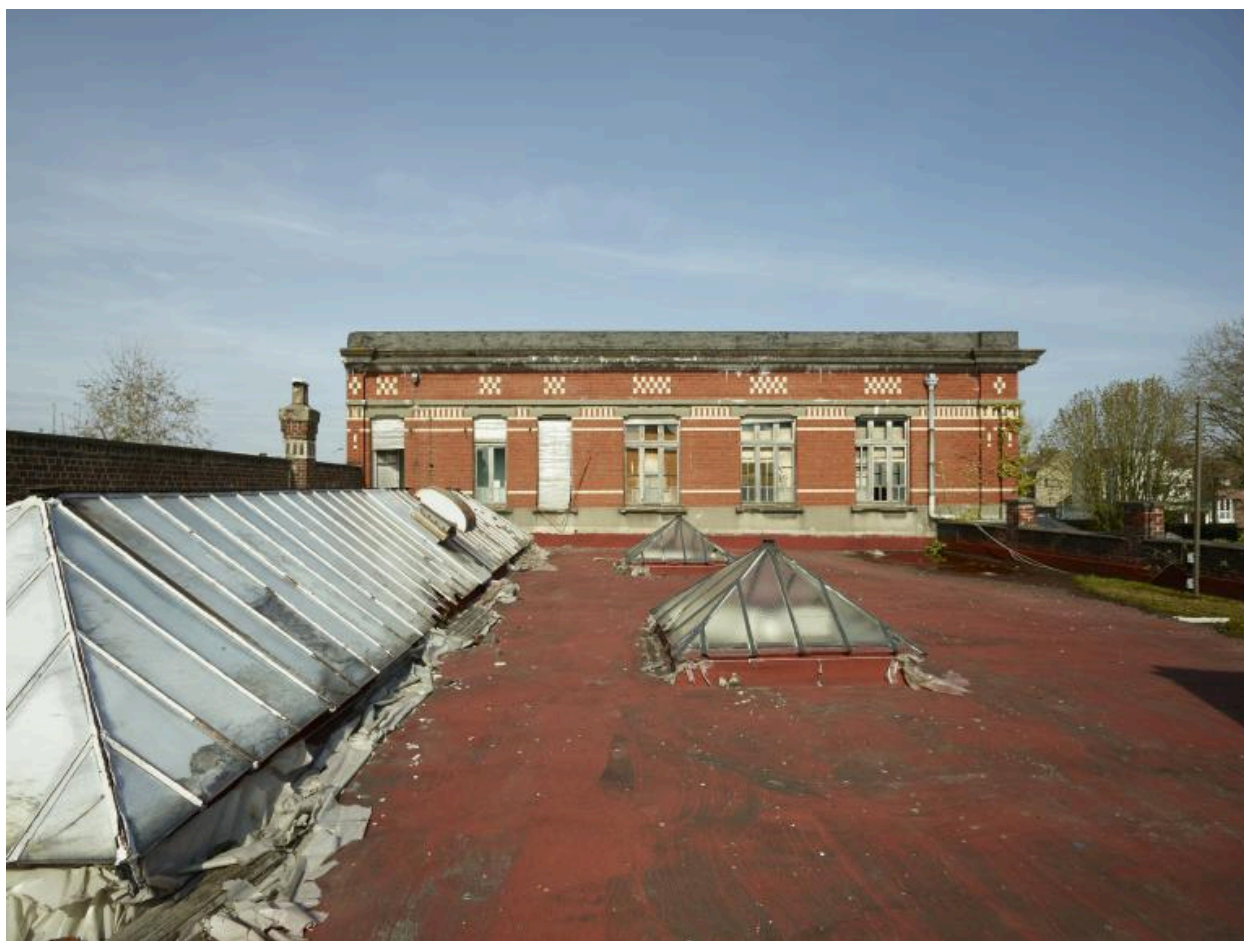
Bureaux. Couvrement. Vue prise vers l'est.
