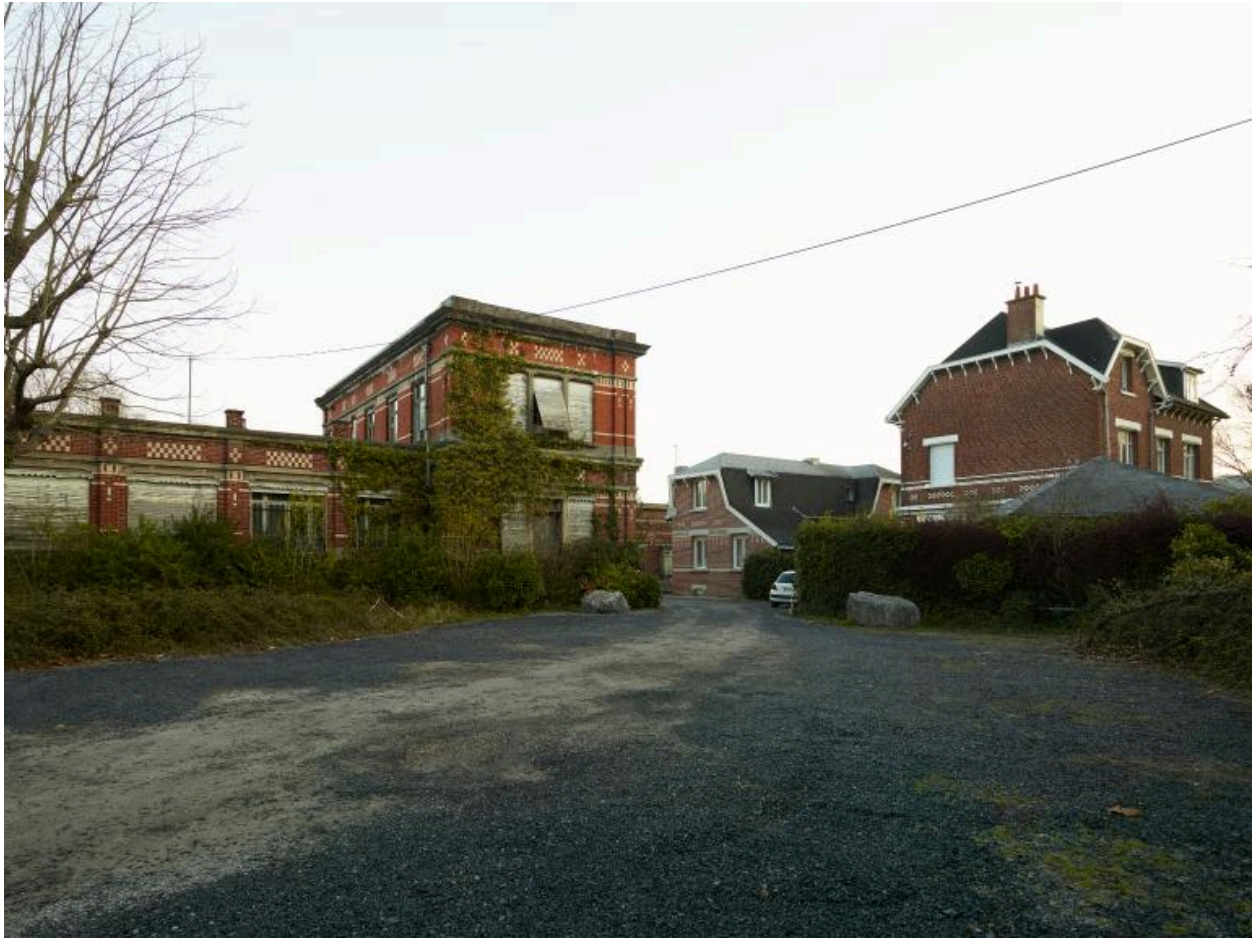
De gauche à droite, vers le nord : aile est des bureaux, conciergerie sud et logement patronal.
