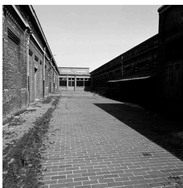
Vue en enfilade prise vers le nord, entre les bureaux et le magasin aux toiles à gauche et le tissage à droite. Phot. Philippe Dapvril IVR31_19885901265X
