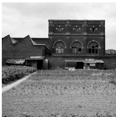
Vue générale depuis les jardins ouvriers, vers le sud-est. La salle des machines, élévation ouest. Phot. Philippe Dapvril IVR31_19885901257X
