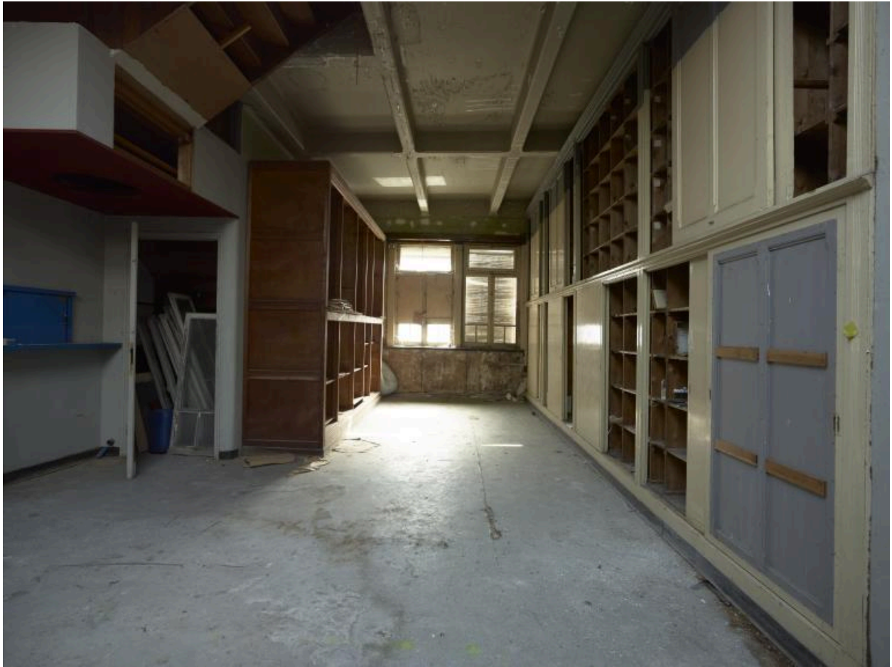
Bureaux. Salle des archives au premier étage.
