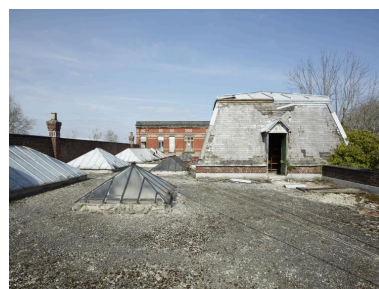
Bureaux. Couvrement. Vue prise vers l'est. Phot. Delphine Volto-Jourdan IVR32_20215900021NUCA
