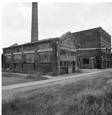
Chaufferie, à gauche, et salle des machines à droite. Vue prise vers l'est. Phot. Philippe Dapvril IVR31_19885901251X
