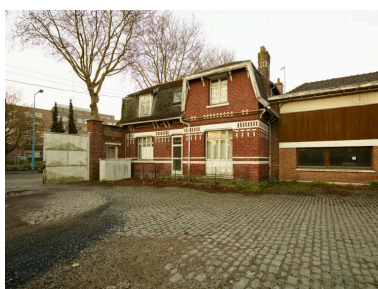
Conciergerie ouest (ancien garage). Vue prise vers le sud, depuis la cour.
