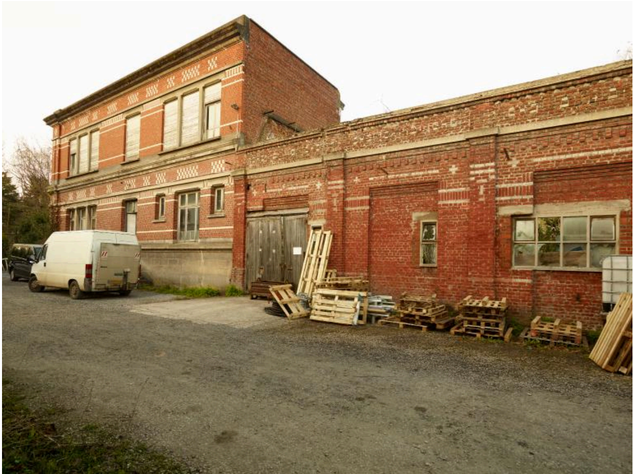
Pignon est des bureaux. Vue prise vers le sud.
