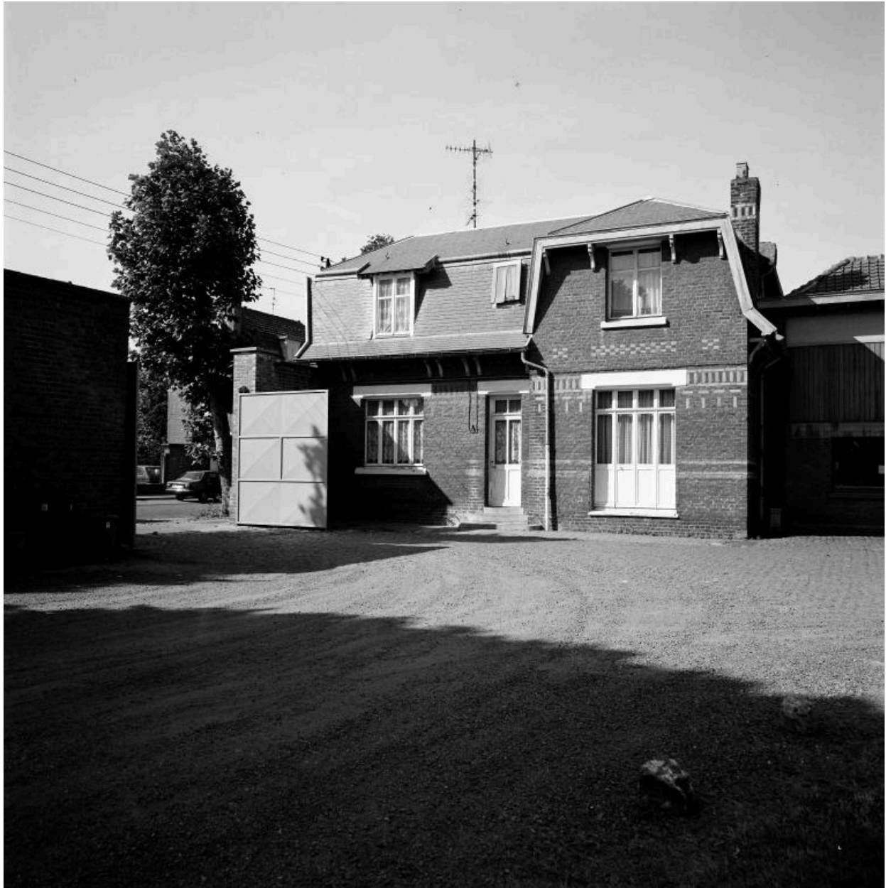
Conciergerie (ancien garage) depuis la cour, vue prise vers l'ouest.
