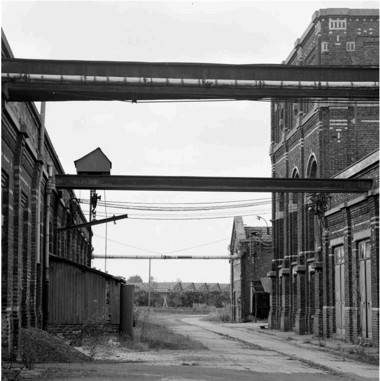
Vue vers le nord entre le tissage, à gauche, et la salle des machines, à droite, reliés par un palan monorail.
