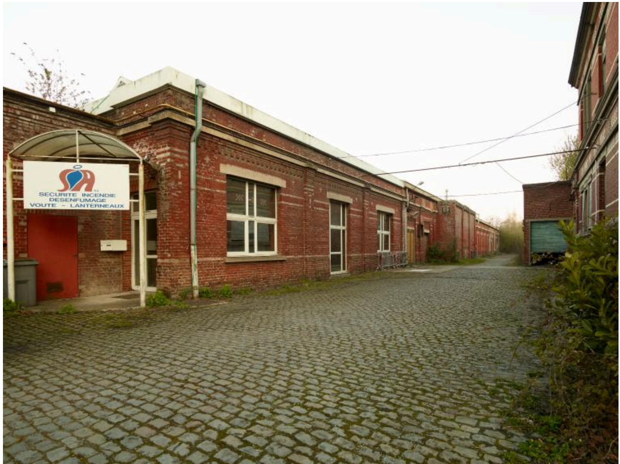
Magasin au toiles. Vue prise vers l'ouest.
