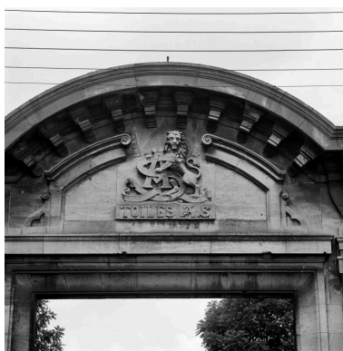
Portail d'entrée, rue Jules- Lebleu. Détail du tympan aux armes de l'entreprise. Phot. Philippe Dapvril IVR31_19885901253X
