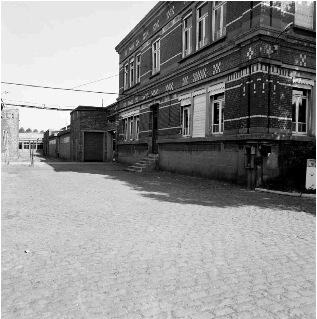
Bureaux. Aile ouest, pignon ouest.
