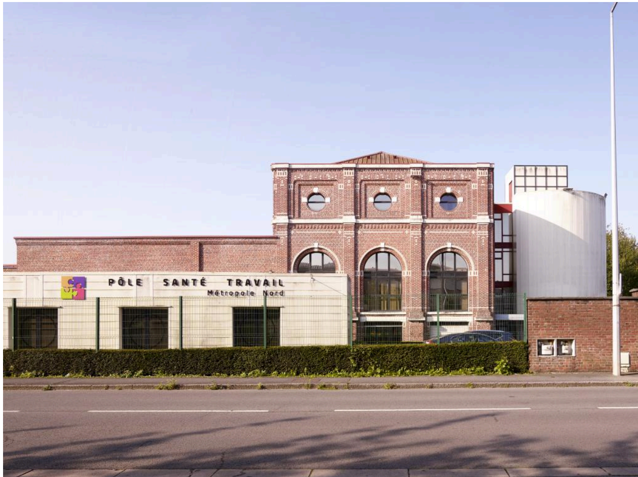
Vue vers le sud-ouest de l'ancienne salle des machines aujourd'hui transformée en bureaux, depuis le boulevard Faidherbe.
