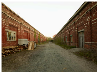
Vue prise vers le nord entre le tissage à gauche et le magasin aux fils à droite. Phot. Delphine Volto-Jourdan IVR32_20215900043NUCA
