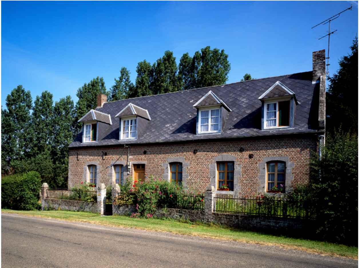
Façade du logis.
