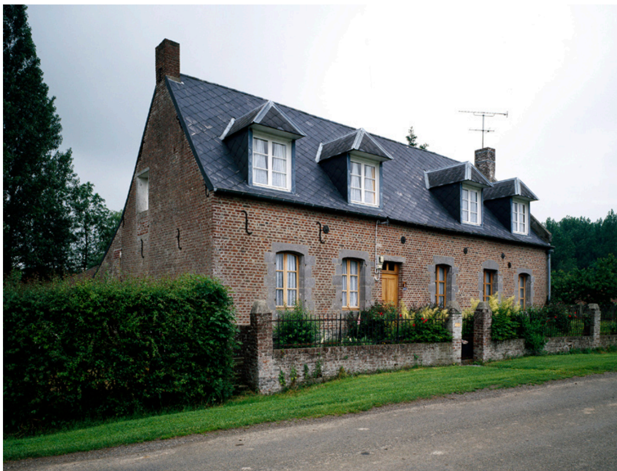
Vue générale sud-ouest du logis.
