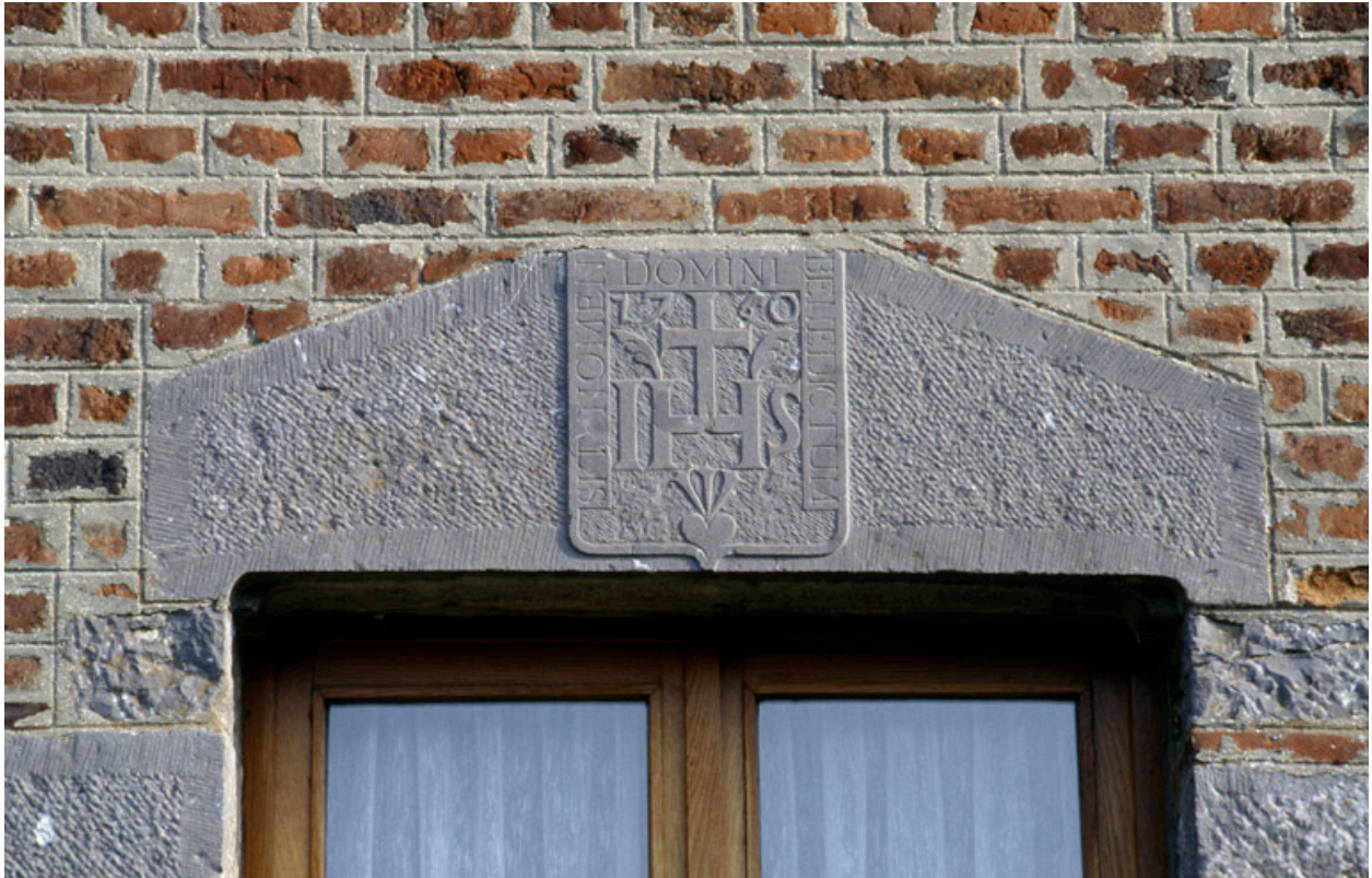
Détail du linteau de la porte du logis.
