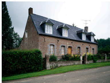
Vue générale sud-ouest du logis. Phot. Thierry Lefébure IVR22_19930200788VA
