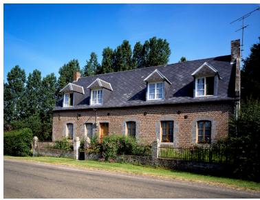
Façade du logis. Phot. Thierry Lefébure IVR22_19930200851VA
