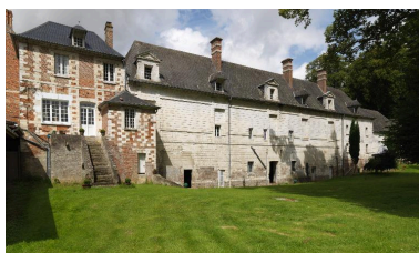
Élévations arrières du pavillon est du logis et de l'aile des communs sur la basse-cour. Phot. Marie-Laure Monnehay-Vulliet IVR22_20128000776NUC2A
