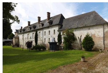
Élévations arrières de l'aile des communs et des garages sur la basse-cour. Phot. Marie-Laure Monnehay-Vulliet IVR22_20128000775NUC2A
