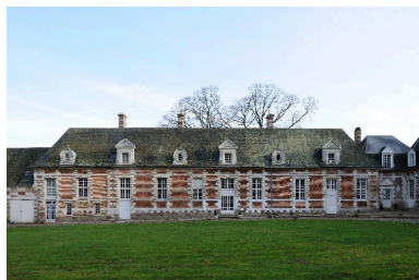
Aile des communs. Phot. Marie-Laure Monnehay-Vulliet IVR22_20128001214NUC2A
