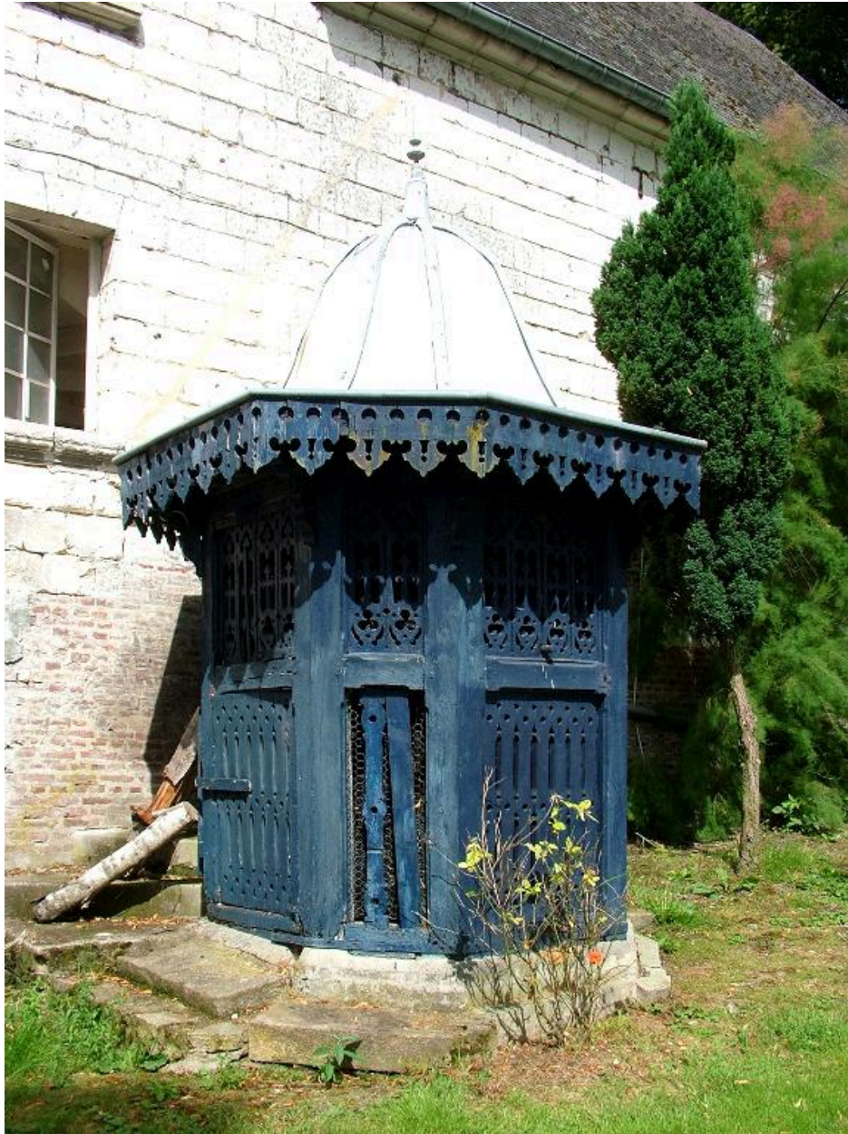
Puits dans la basse-cour.
