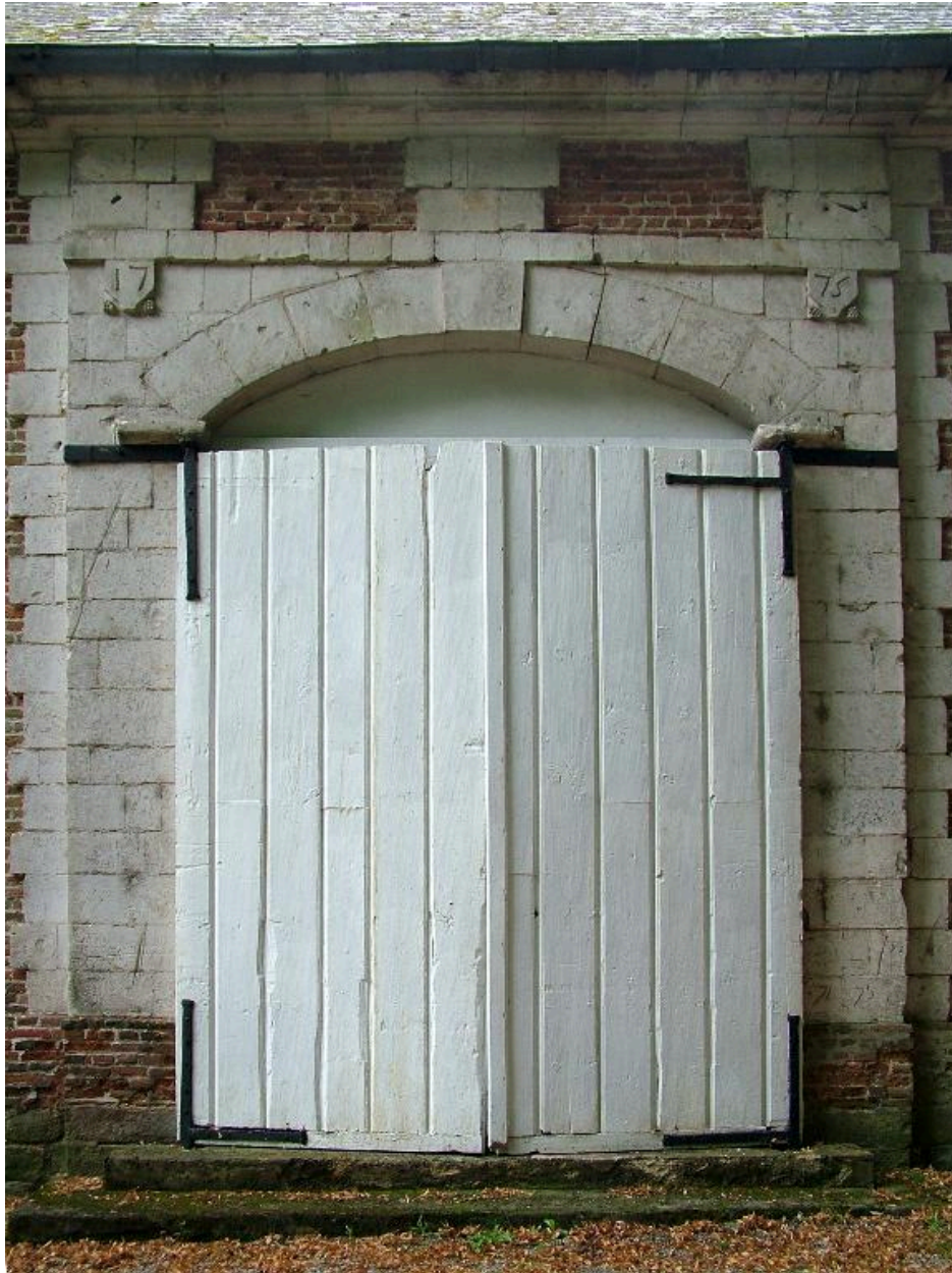
Porte extérieure du bâtiment d'exploitation portant la date de 1775.
