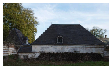
Élévation arrière du logement sur le potager. Phot. Marie-Laure Monnehay-Vulliet IVR22_20128001065NUC2A
