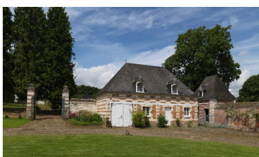
Porte du potager, logement et pavillon d'entrée. Phot. Marie-Laure Monnehay-Vulliet IVR22_20128000770NUC2A
