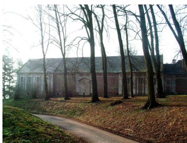
Vue extérieure du bâtiment d'exploitation. Phot. Frédéric Fournis IVR22_20118001007NUCA
