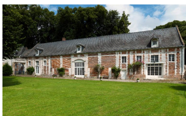
Vue du bâtiment d'exploitation depuis la basse-cour. Phot. Marie-Laure Monnehay-Vulliet IVR22_20128000774NUC2A
