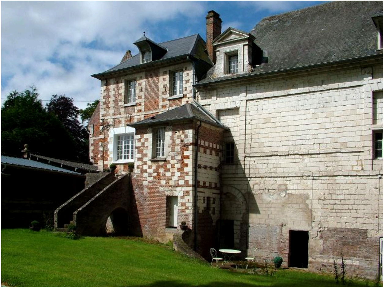
Vue partielle de l'élévation de l'aile des communs sur la basse-cour.
