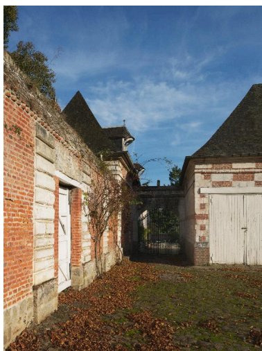
Passage entre la cour et la basse-cour (vue large). Phot. Marie-Laure Monnehay-Vulliet IVR22_20128001062NUC2A
