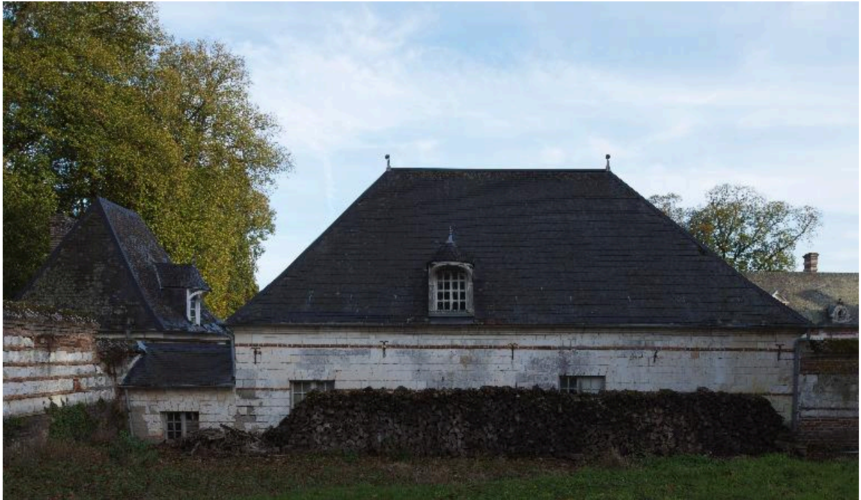
Élévation arrière du logement sur le potager.
