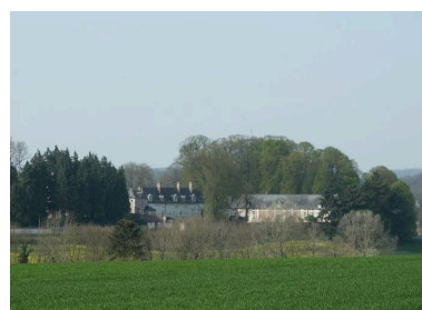
Vue de situation de la basse-cour depuis le sud-est. Phot. Marie-Laure Monnehay-Vulliet
