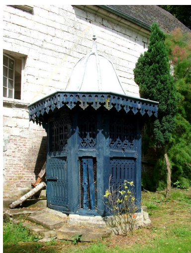
Puits dans la basse-cour.
