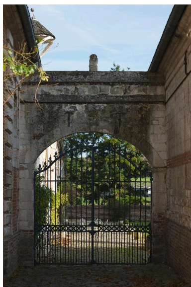
Porte entre la cour et la basse-cour. Phot. Marie-Laure Monnehay-Vulliet IVR22_20128001060NUC2A
