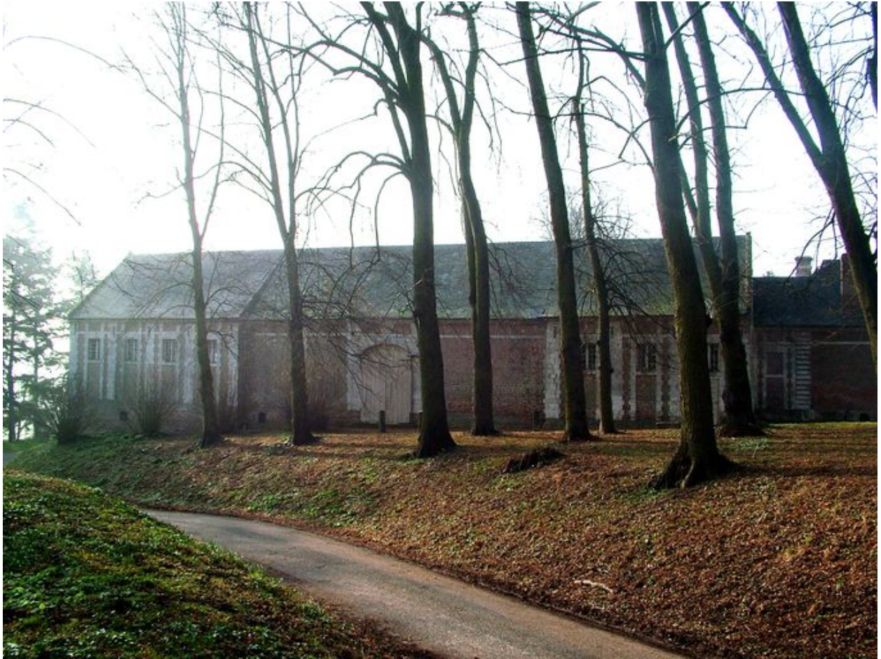
Vue extérieure du bâtiment d'exploitation.
