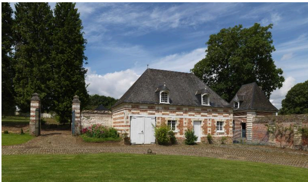
Porte du potager, logement et pavillon d'entrée.
