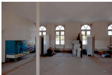
Deuxième étage, une ancienne classe, vue vers les fenêtres en plein cintre donnant sur la rue. Phot. Pierre Thibaut IVR31_20135900148NUCA
