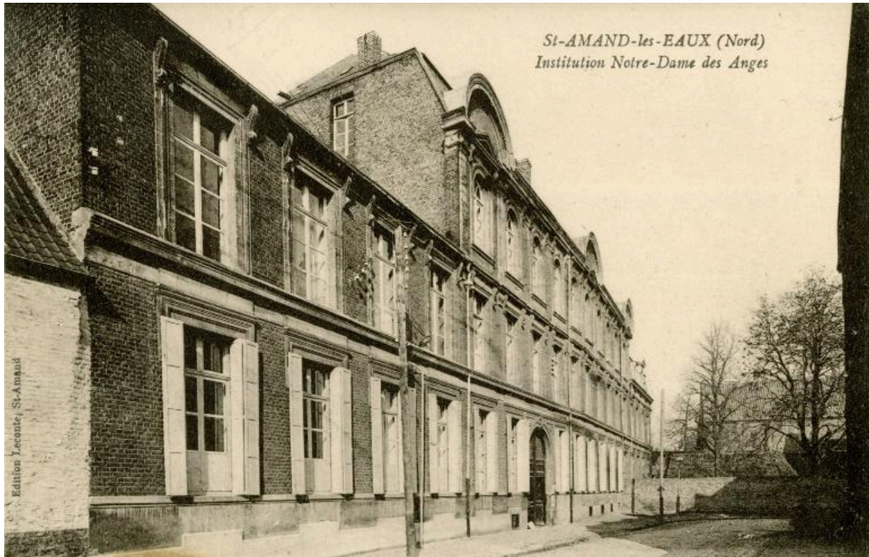
Vue générale de l'institution Notre Dame des Anges, carte postale sans date (Médiathèque Saint-Amand-les-Eaux).
