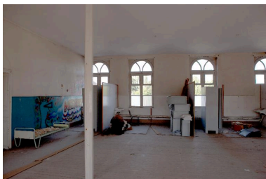
Deuxième étage, une ancienne classe, vue vers les fenêtres en plein cintre donnant sur la rue. Phot. Pierre Thibaut IVR31_20135900148NUCA
