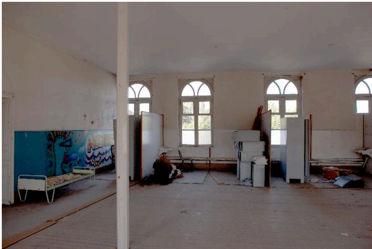
Deuxième étage, une ancienne classe, vue vers les fenêtres en plein cintre donnant sur la rue.
