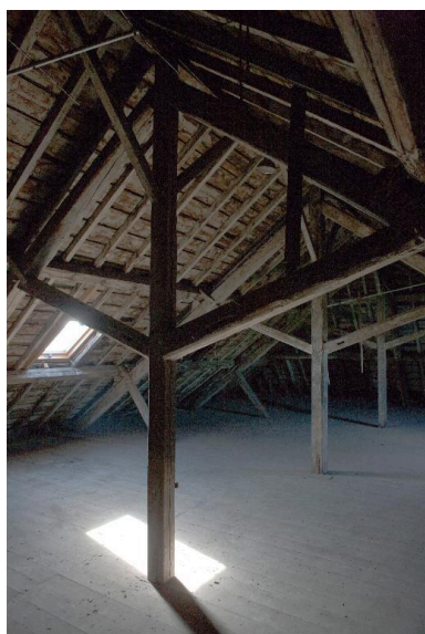
Les combles et la charpente du collège Notre Dame des Anges rue du Bruille. Phot. Pierre Thibaut IVR31_20135900151NUCA
