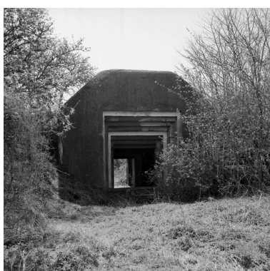
Vue générale depuis le nord. Phot. Philippe Dapvril IVR31_20045900204X
