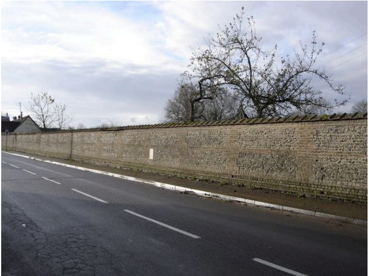
Vue du mur d'enceinte sur la rue du Général Leclerc.
