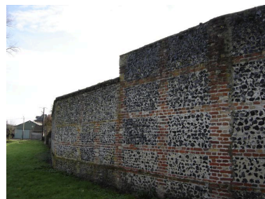
Vue du mur d'enceinte sur la rue du Riot. Phot. Inès Guérin IVR22_20058005241NUCA
