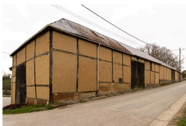
Grange de ferme, n°15 rue de Choqueuse, vue depuis le nord-est. Phot. Marc Kérignard IVR32_20216000186NUCA
