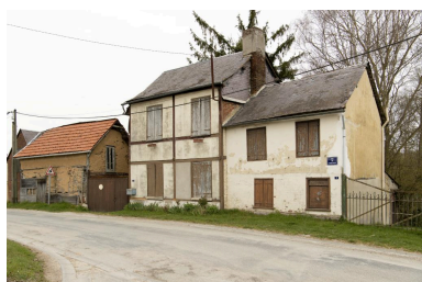
Vue depuis la rue de maisons d'artisans ou commerçants, n°2 et 4 rue de Choqueuse. Phot. Marc Kérignard IVR32_20216000180NUCA
