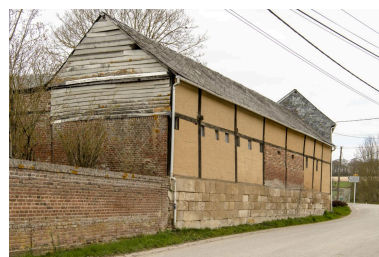
Bâtiment d'étable, n°15 rue de Choqueuse, vue depuis le sud. Phot. Marc Kérignard IVR32_20216000184NUCA
