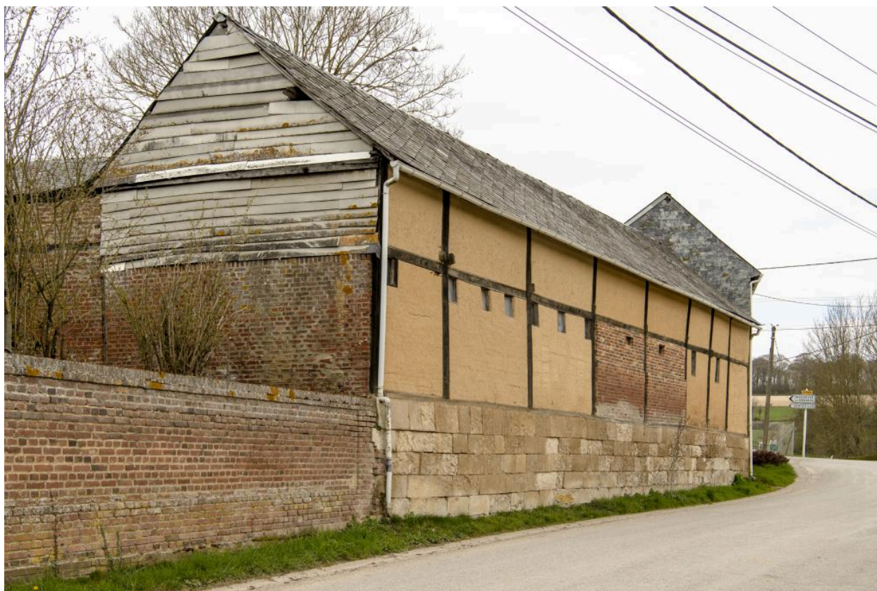
Bâtiment d'étable, n°15 rue de Choqueuse, vue depuis le sud.
