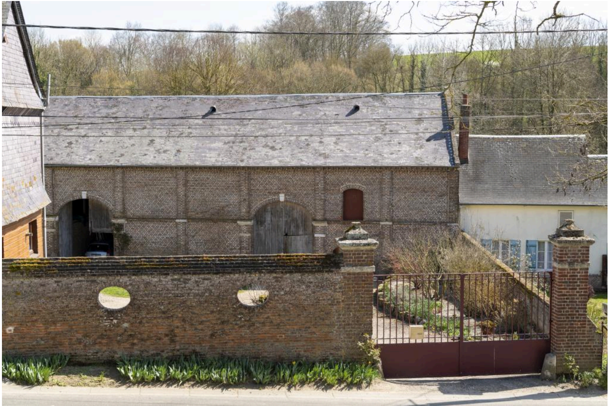
Grange, n°10 rue Principale, vers 1860, vue depuis la rue du Chauffour.
