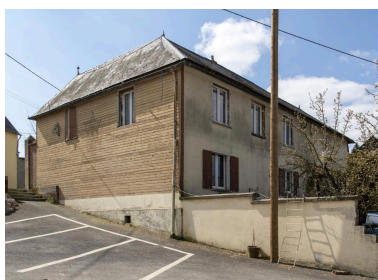
Logis de ferme, n°1 rue Lavaquerie, pignon est et façade nord sur cour, vue depuis le nord-est. Phot. Marc Kérignard IVR32_20216000200NUCA
