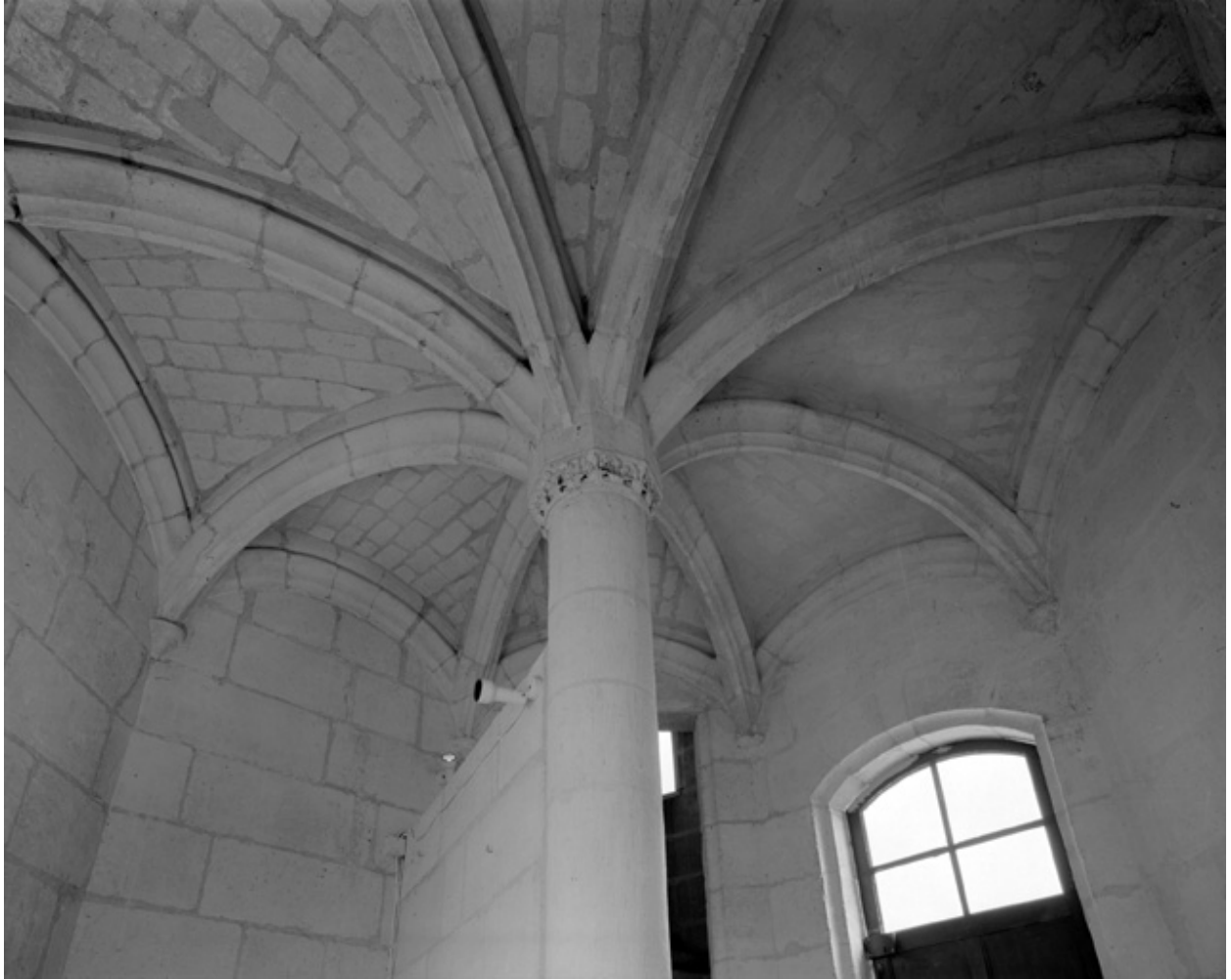
La voûte de la cage d'escalier.
