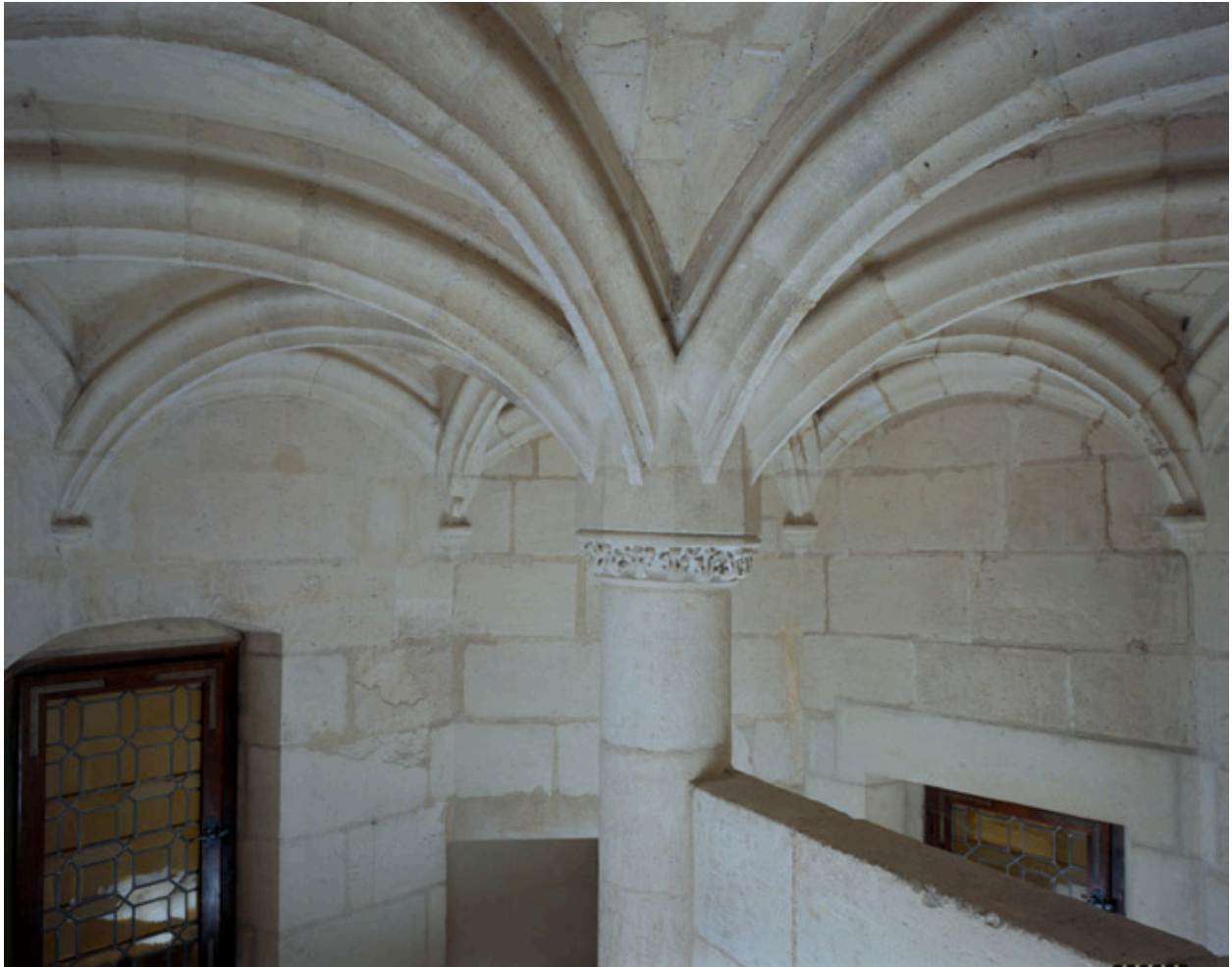
La voûte vue de côté.
