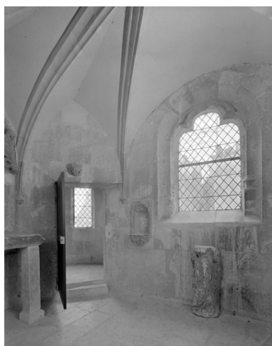
Vue de la chapelle. Phot. Patrick Glotain IVR22_19930200521V
