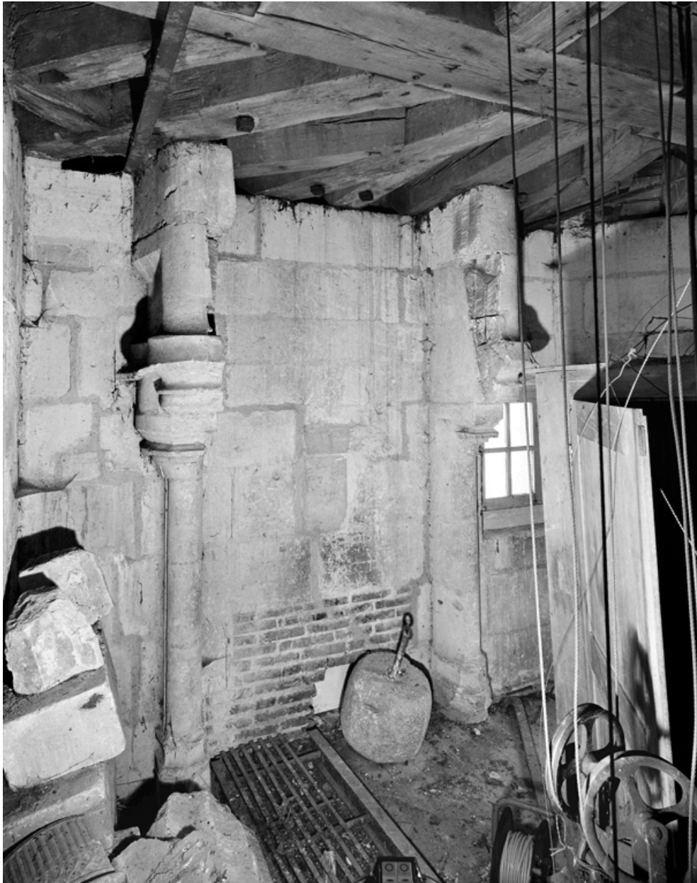
La chambre à feu au sommet de la tour.
