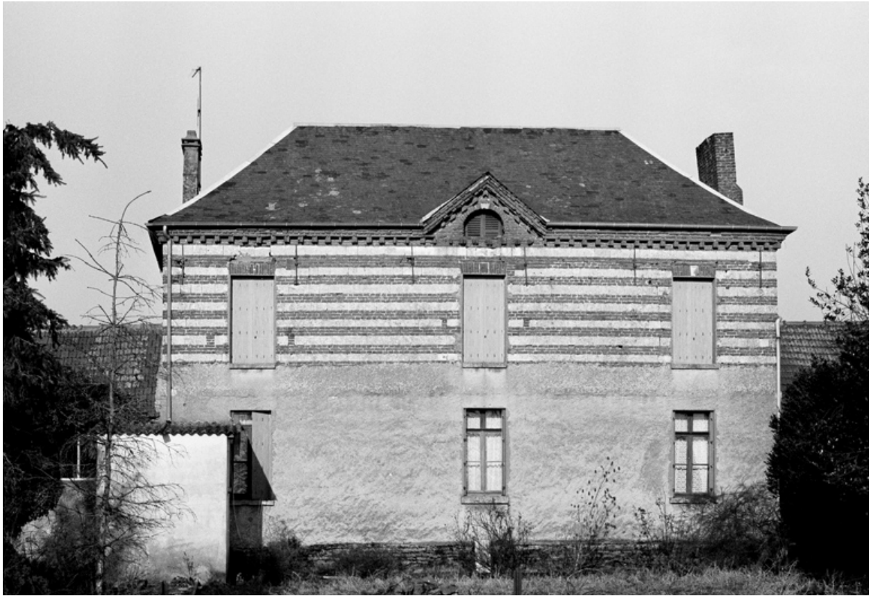
Façade postérieure du logis.
