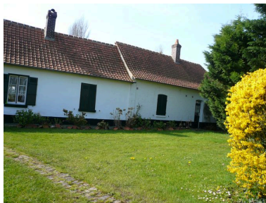
Vue de la partie réservée aux animaux. Phot. Inès Guérin IVR22_20078005762NUCA
