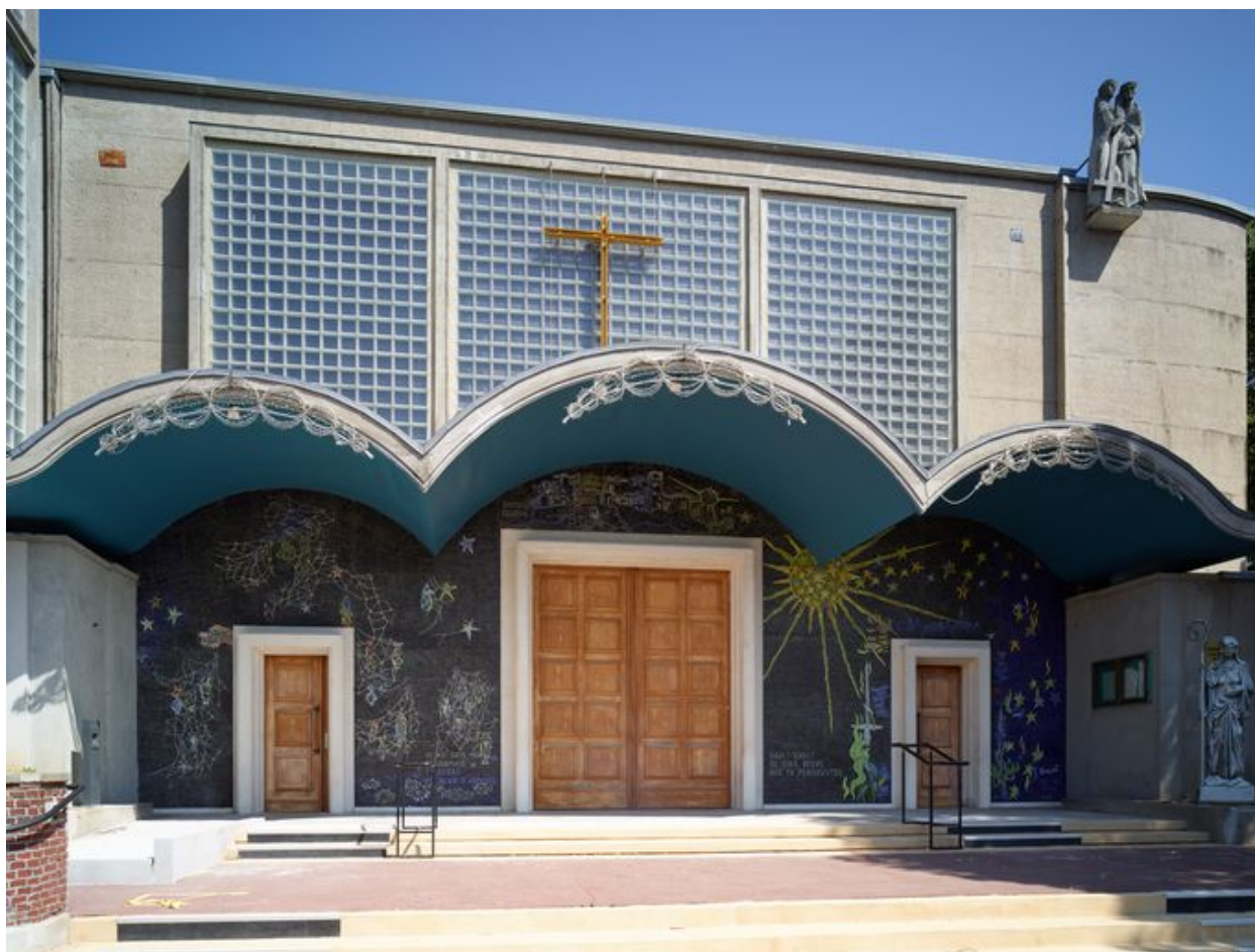
Vue générale de trois quart gauche du porche.
