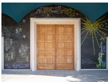
Détail de la partie centrale du porche. Phot. Pierre Thibaut IVR31_20155901495NUCA
