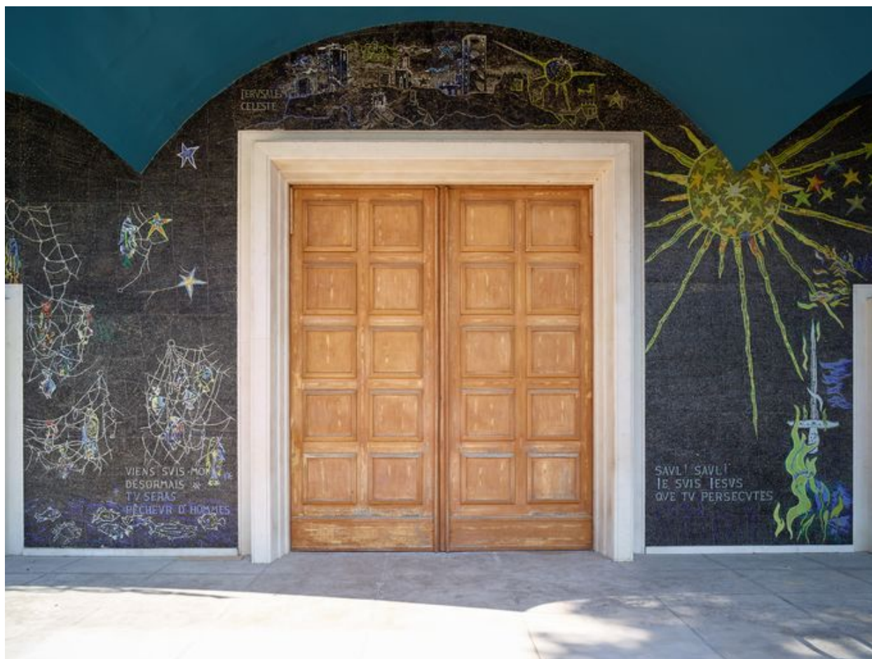
Détail de la partie centrale du porche.
