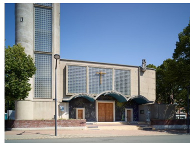
Détail de l'élévation antérieure de l'église. Phot. Pierre Thibaut IVR31_20155901490NUCA
