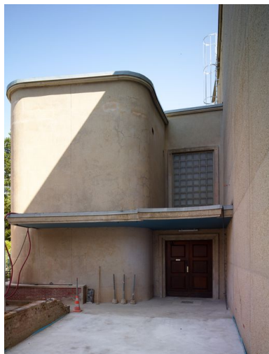
Vue extérieure de l'entrée latérale de l'église. Phot. Pierre Thibaut IVR31_20155901486NUCA
