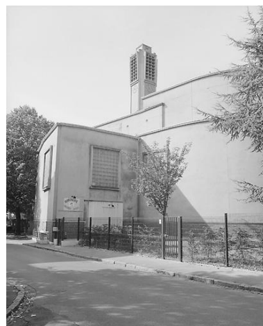
Vue générale depuis le nord-est : le déambulatoire, le chœur, la chapelle orientale et le clocher.
