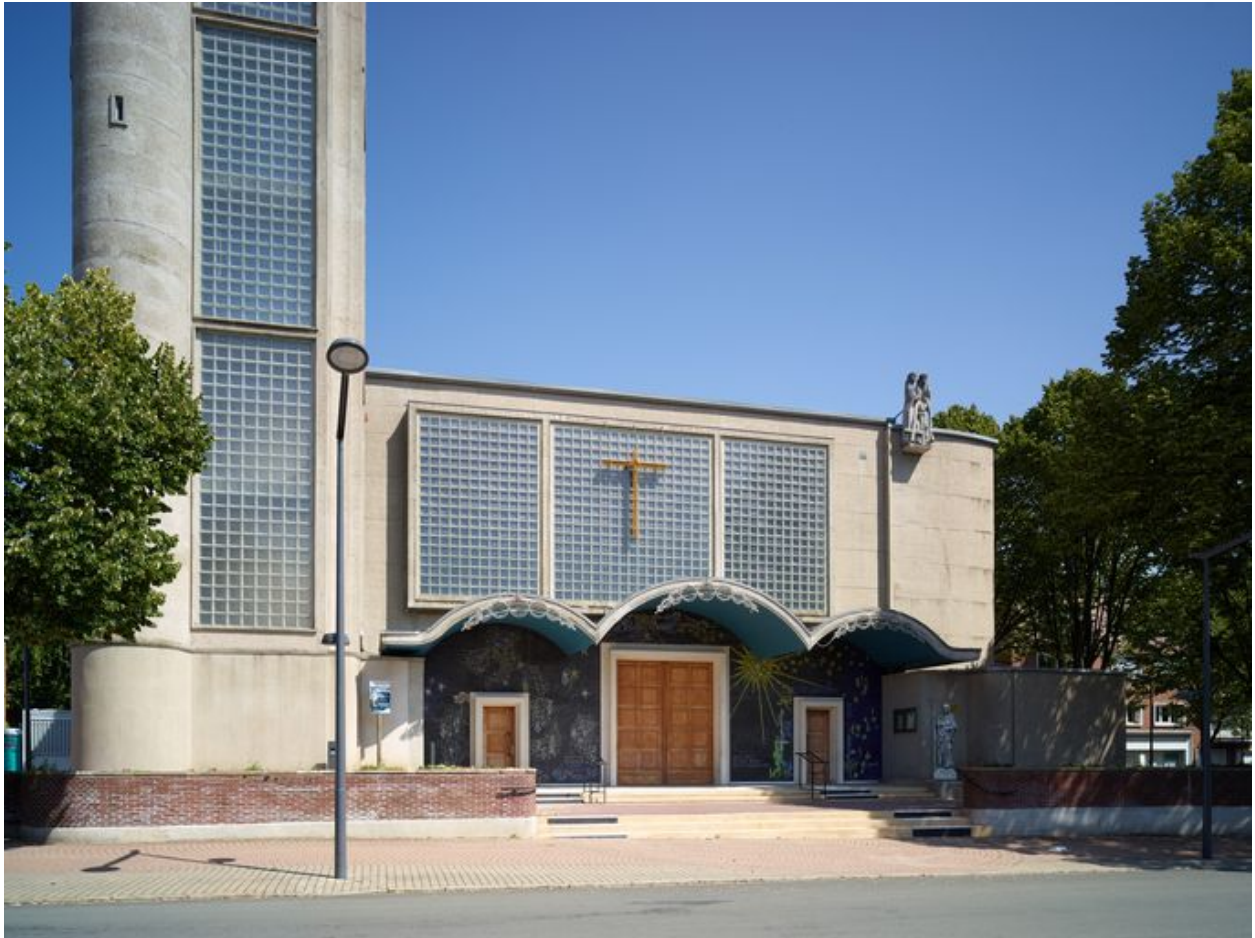
Détail de l'élévation antérieure de l'église.
