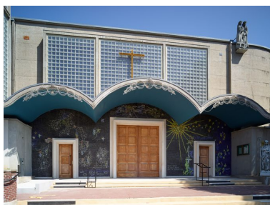
Vue générale de trois quart gauche du porche. Phot. Pierre Thibaut IVR31_20155901491NUCA
