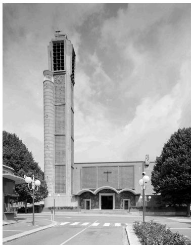
Élévation antérieure sud. Phot. Thierry Petitberghien IVR22_19945901549V
