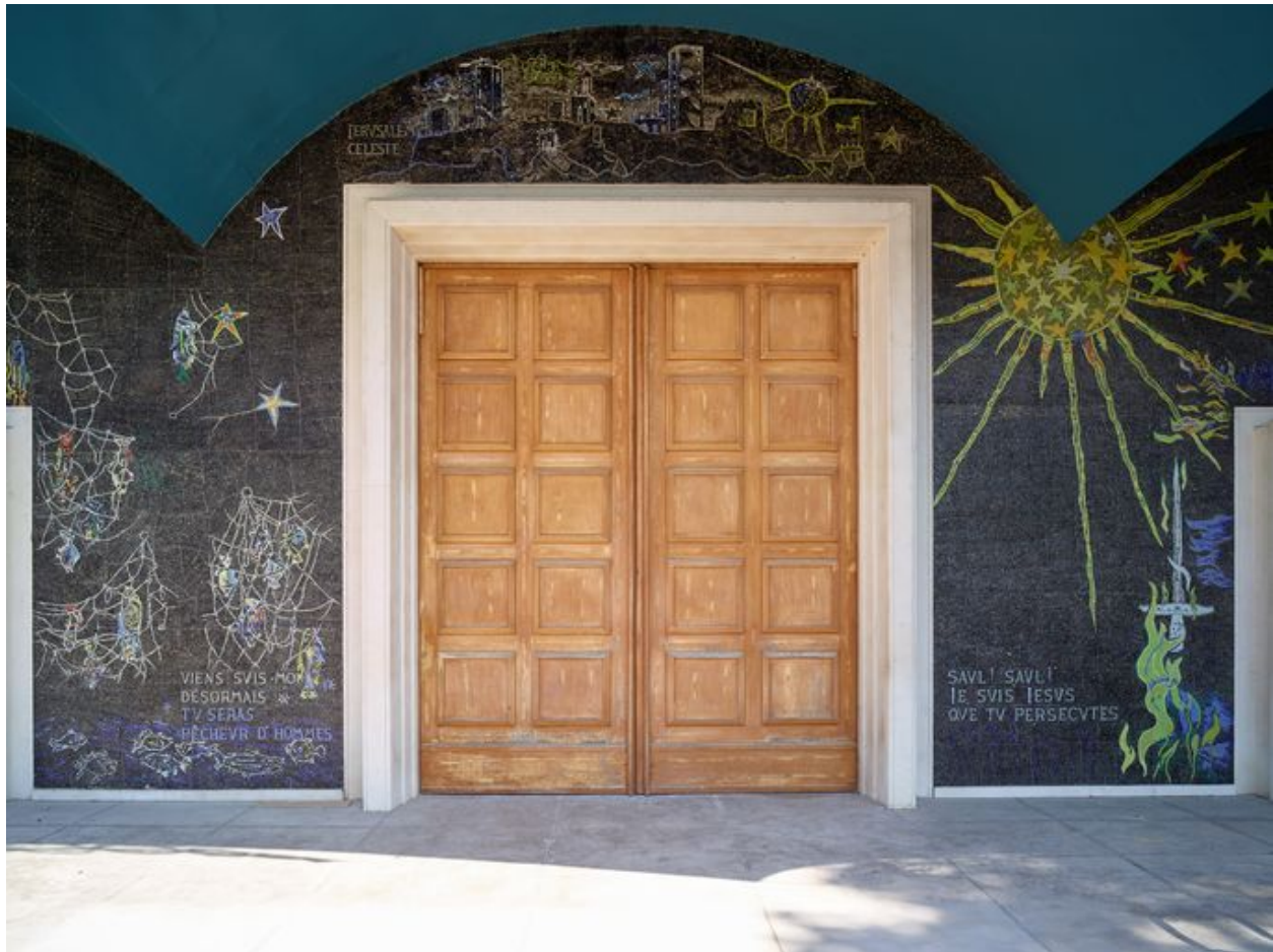
Détail de la partie centrale du porche.
