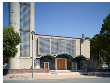
Détail de l'élévation antérieure de l'église. Phot. Pierre Thibaut IVR31_20155901490NUCA
