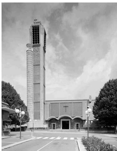
Élévation antérieure sud. Phot. Thierry Petitberghien IVR22_19945901549V
