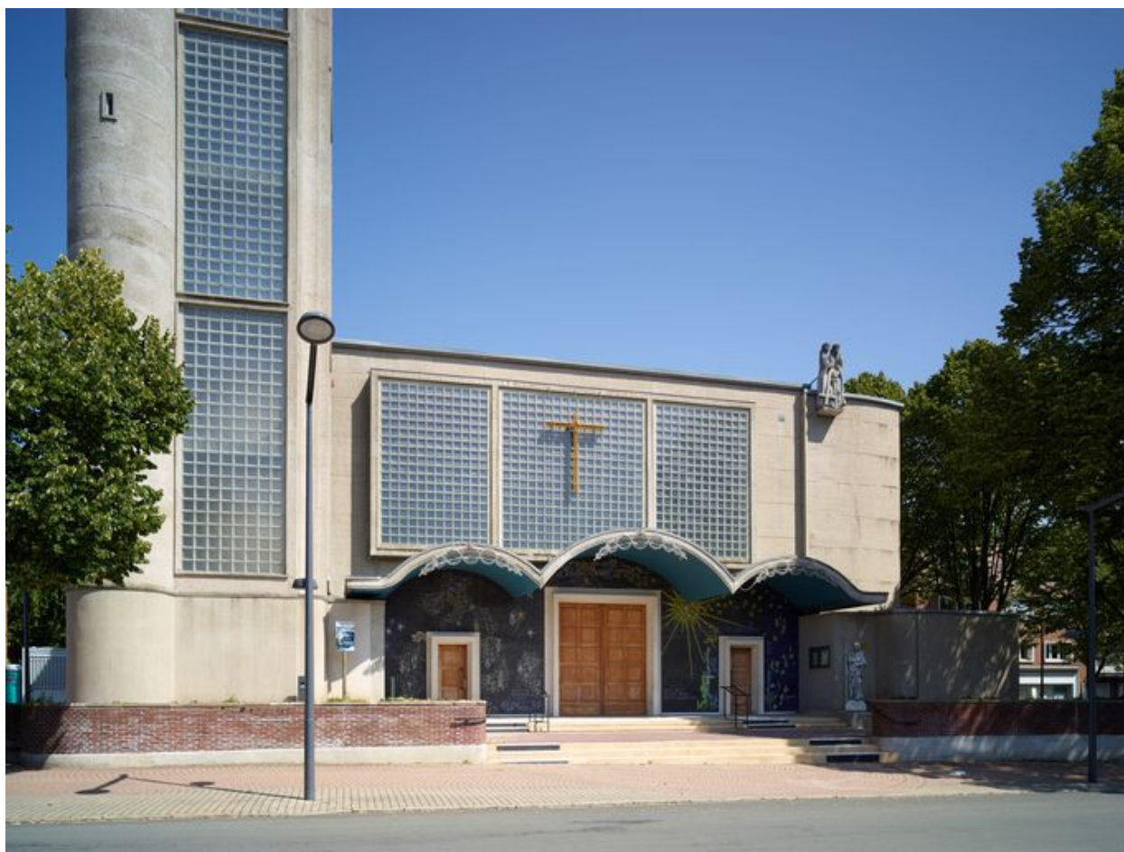
Détail de l'élévation antérieure de l'église.
