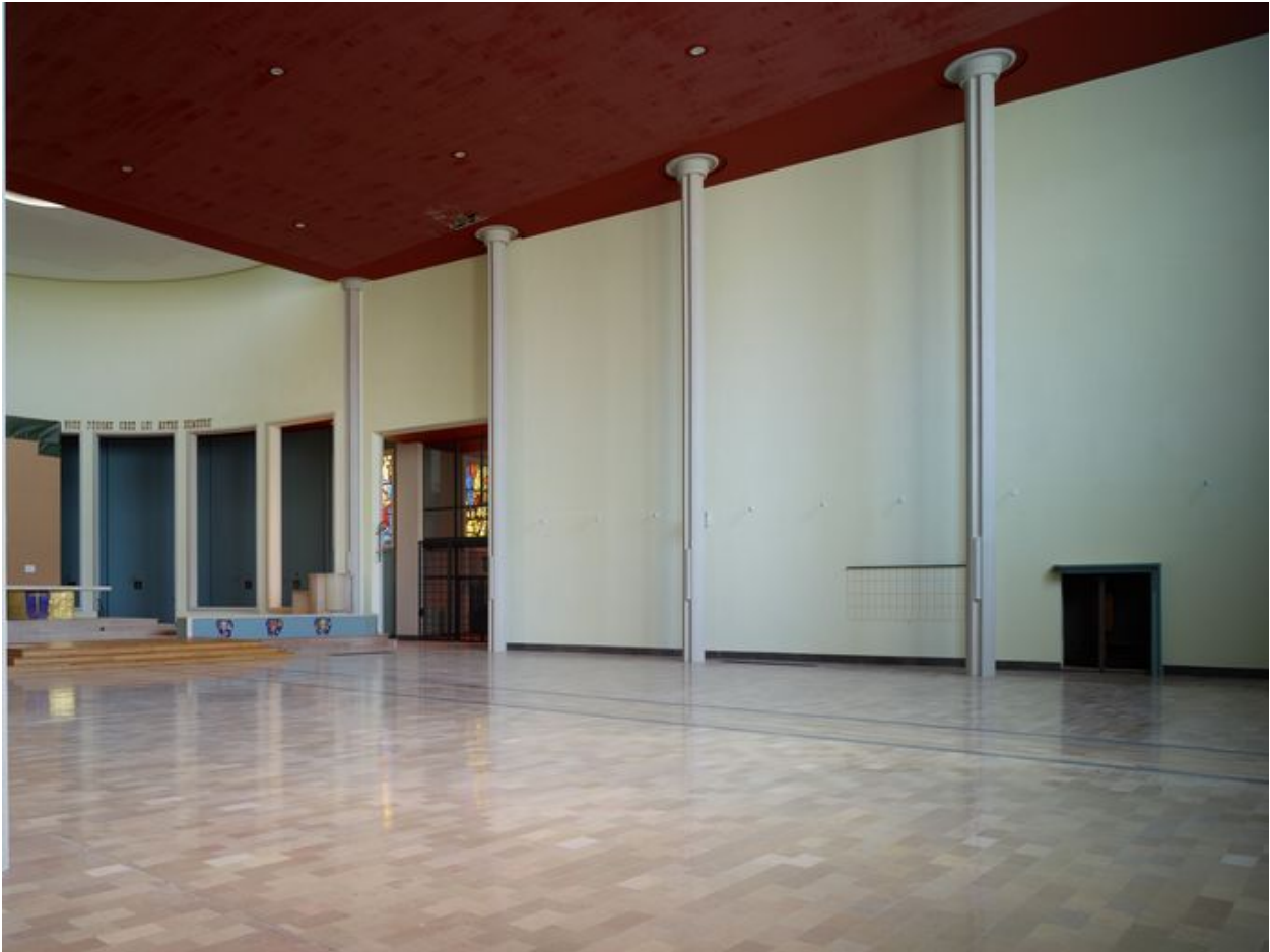
Vue générale de la partie droite de l'église, depuis l'entrée de la nef.
