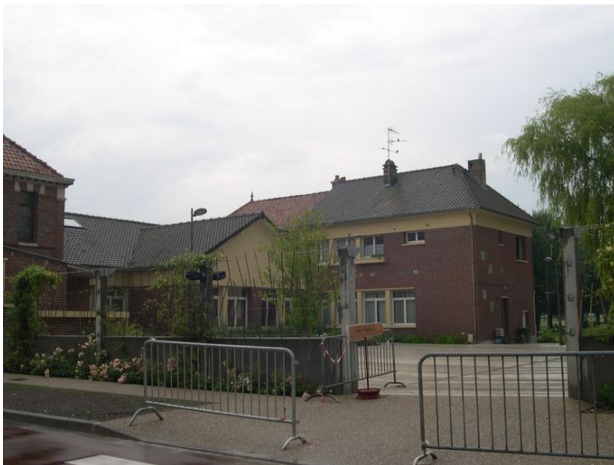
Détail sur l'extension nord-est.
