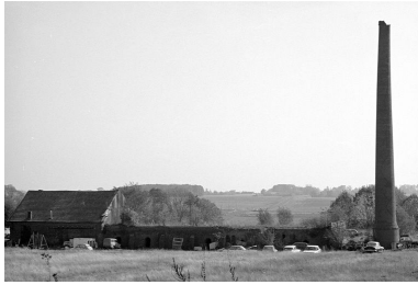
Cheminée d'usine, vue générale. Phot. Francis Dubuc IVR22_19908001291Z
