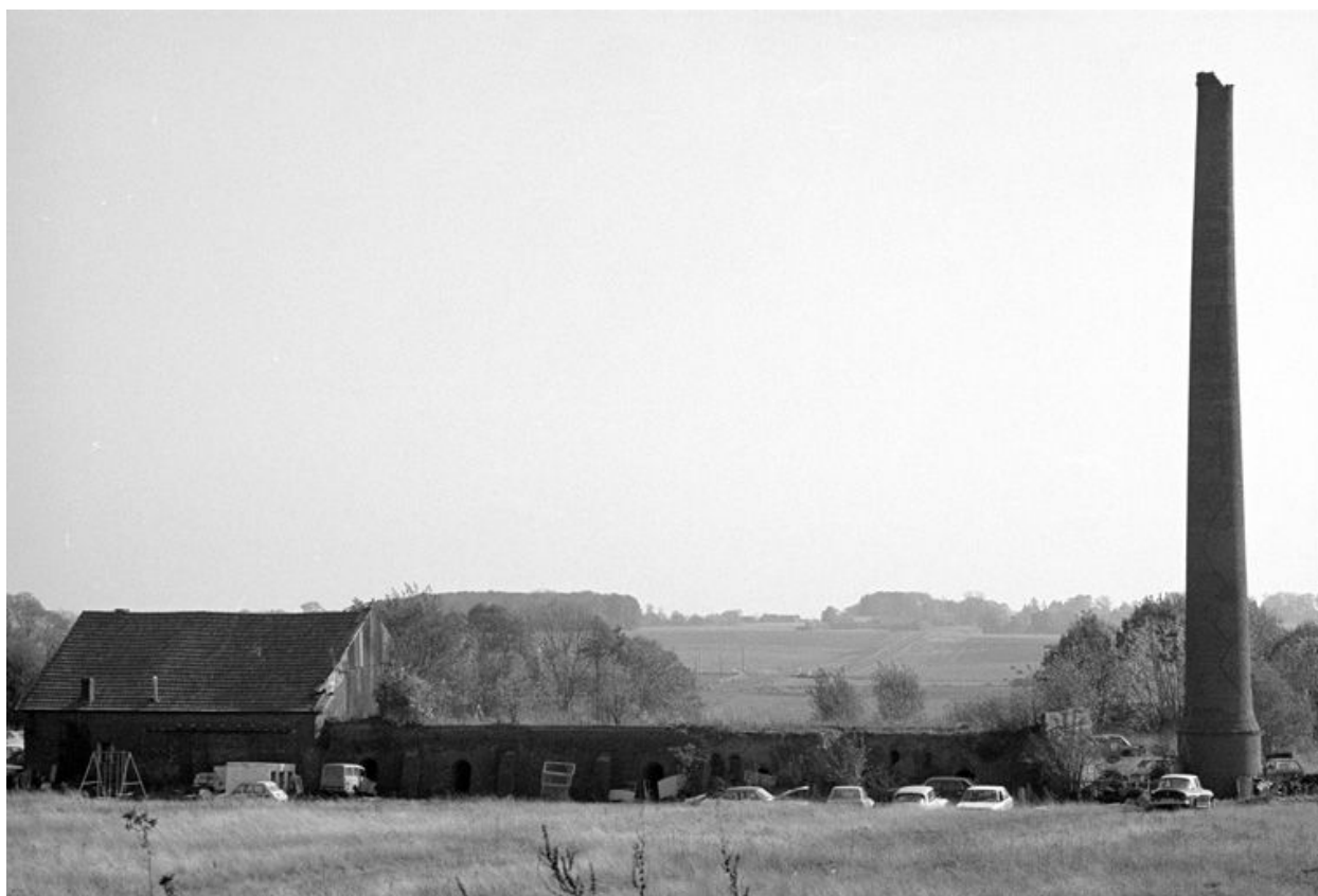
Cheminée d'usine, vue générale.
