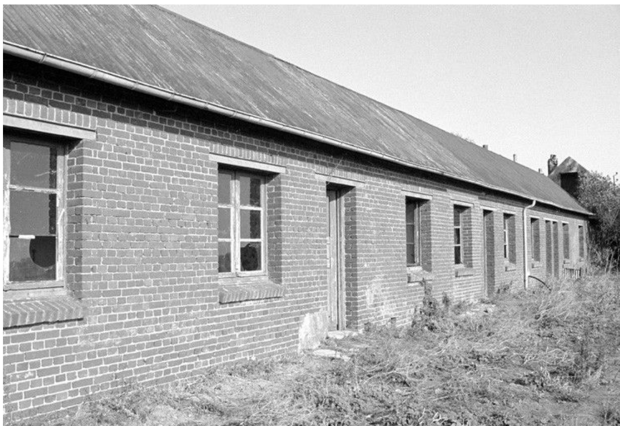
Logement d'ouvriers, vue générale, élévation antérieure.
