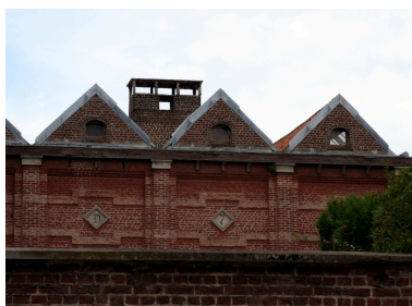
Trois travées des ateliers construits en 1877 : elles portent trois tables sculptées (D - 7 - 7 : D[esfossez] [18]77). Phot. Frédéric Pillet IVR22_20040200882NUCA
