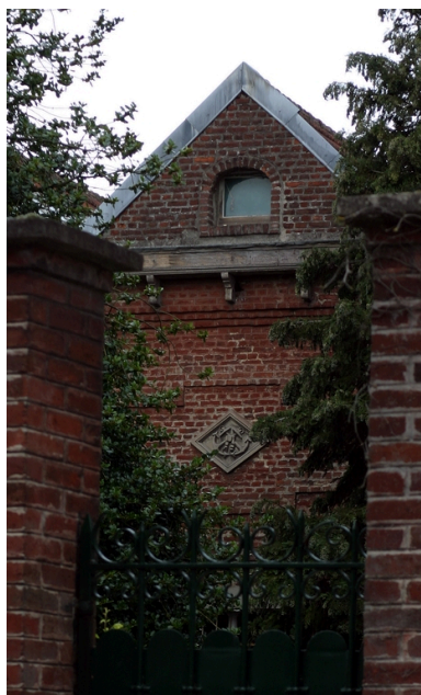
L'une des travées des ateliers bordant le boulevard : table saillante sculptée de deux ancrs entrecroisés. Phot. Frédéric Pillet IVR22_20040200881NUCA
