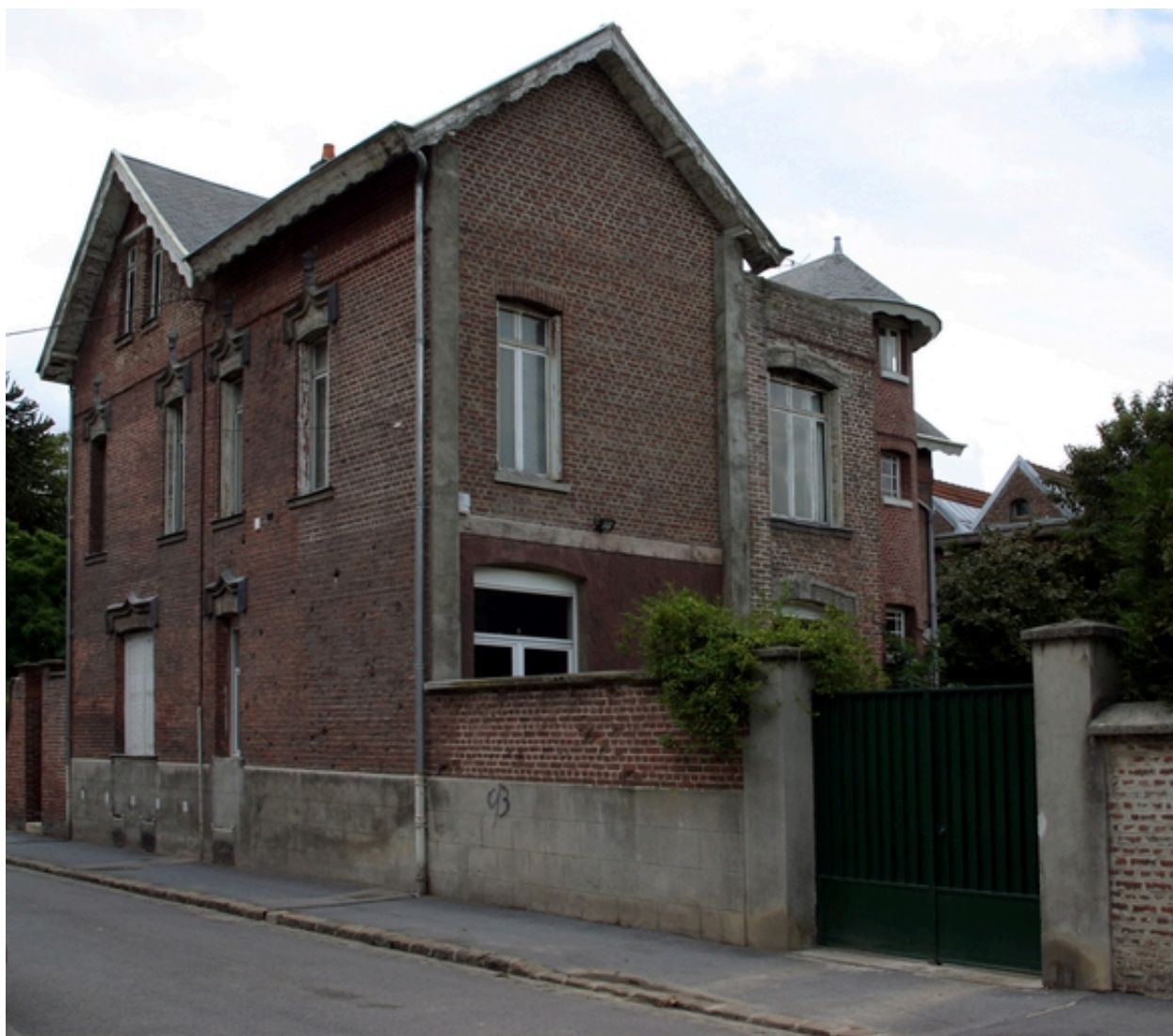
Façade postérieure du logement patronal.
