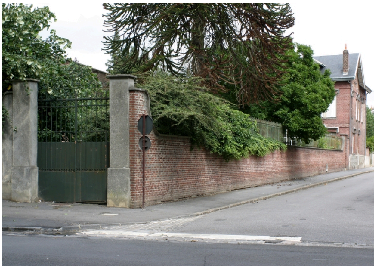
Logement patronal vu depuis le boulevard Gambetta.
