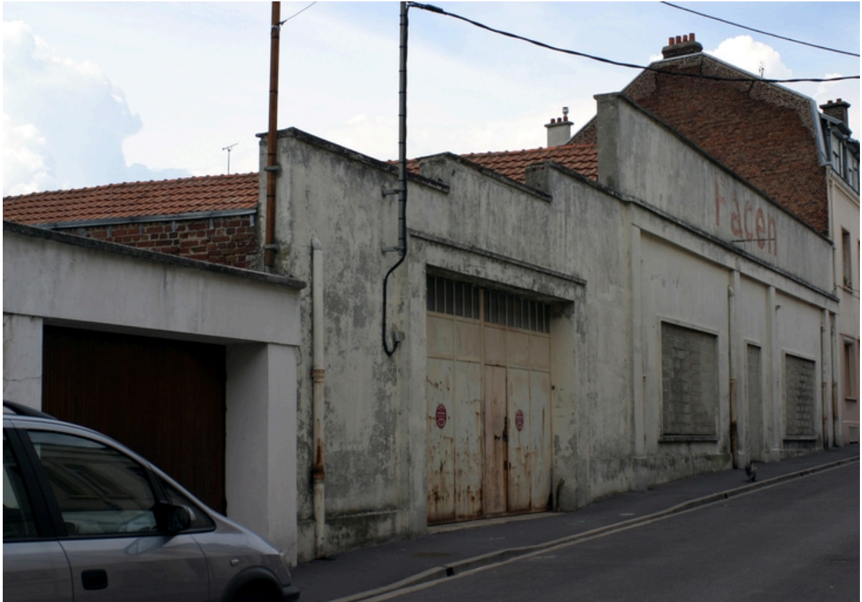
Façade des ateliers, rue de Nancy.
