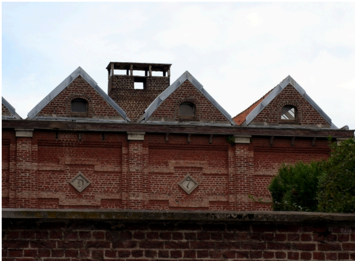
Trois travées des ateliers construits en 1877 : elles portent trois tables sculptées (D - 7 - 7 : D[esfossez] [18]77).
