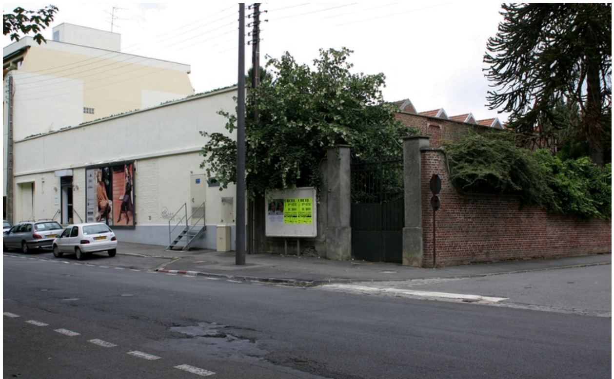
Façade antérieure des ateliers, boulevard Gambetta, et jardin du logement patronal.
