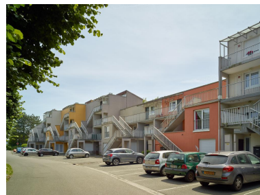
L'extrémité est de l'îlot depuis la rue des Chercheurs. Chaque appartement dispose d'une entrée privative, accessible par des coursives et des escaliers extérieurs communs.
