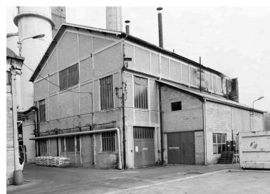
Chaufferie. Phot. Benoît Dufournier IVR22_19936002363Z
