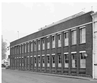
Bureau : élévation antérieure. Phot. Benoît Dufournier IVR22_19936002384Z
