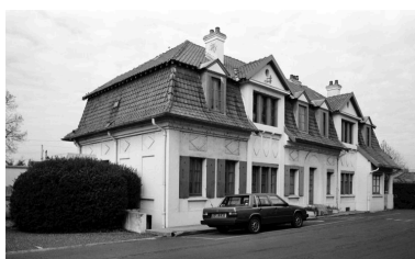
Immeuble de deux logements de cadres. Phot. Benoît Dufournier IVR22_19936002383Z
