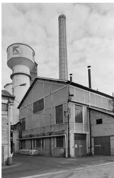
Chaufferie, château d'eau. Phot. Benoît Dufournier IVR22_19936002362Z
