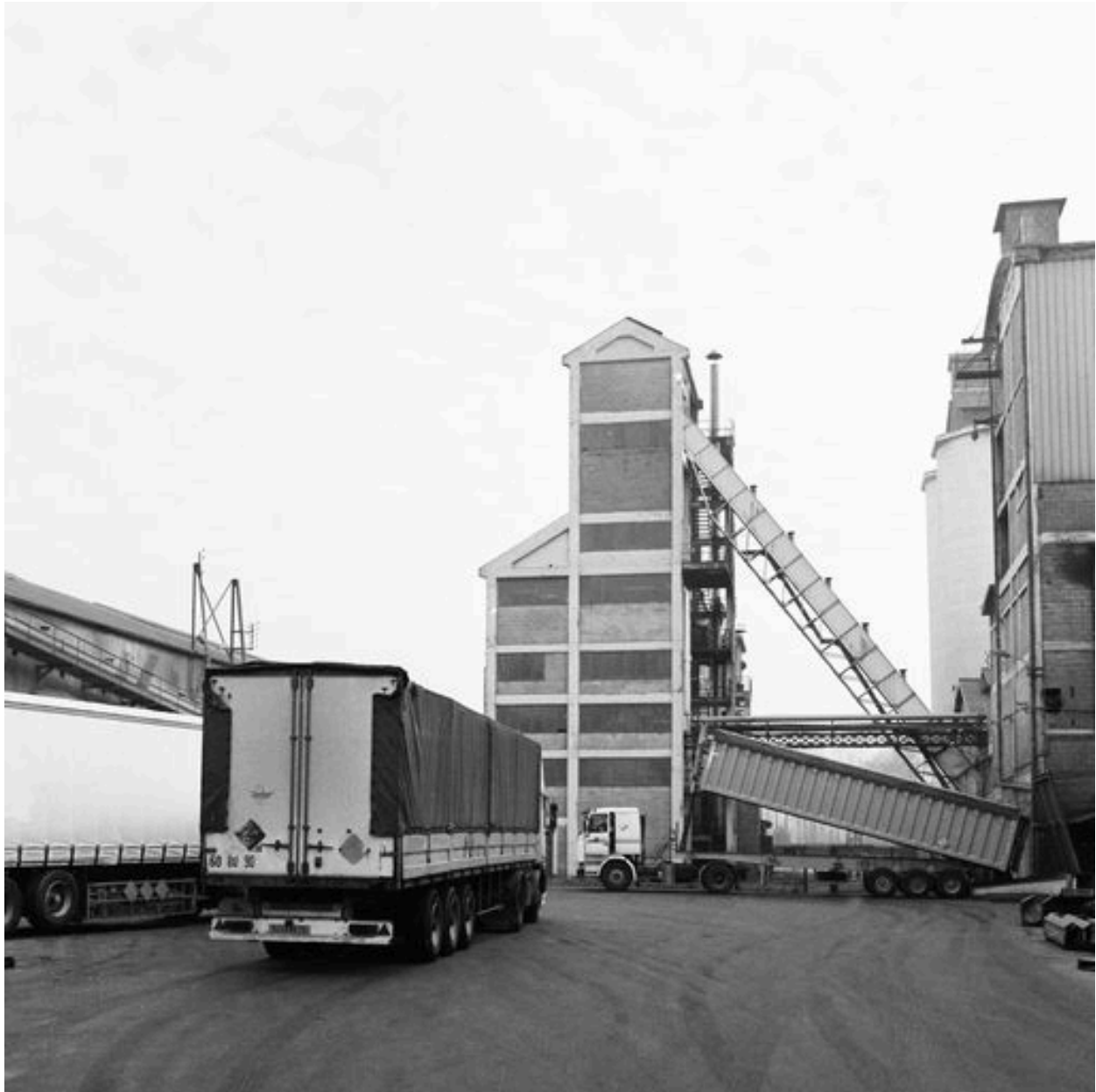
Atelier de fabrication : flanc ouest.
