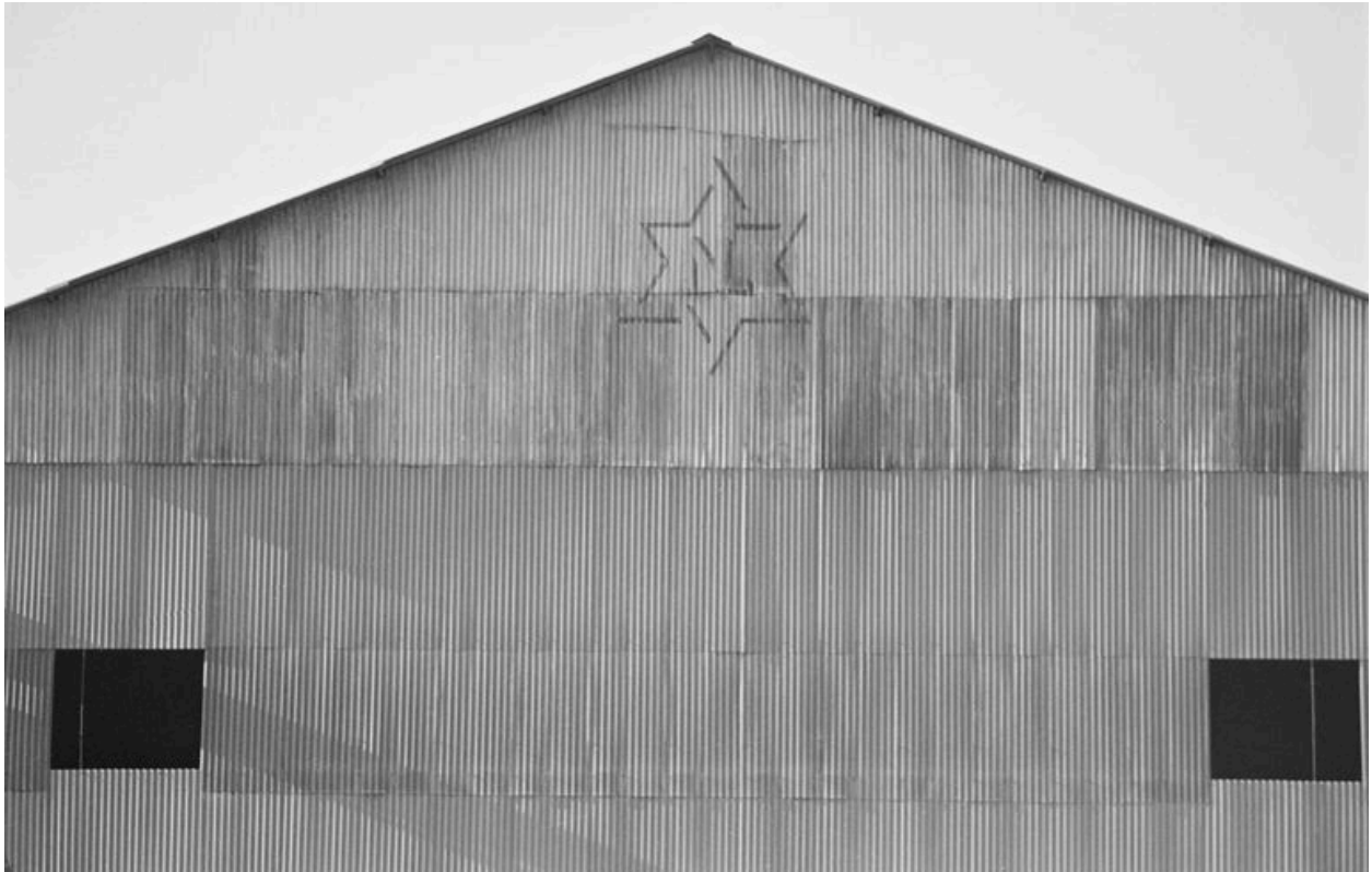
Magasin industriel : flanc est.
