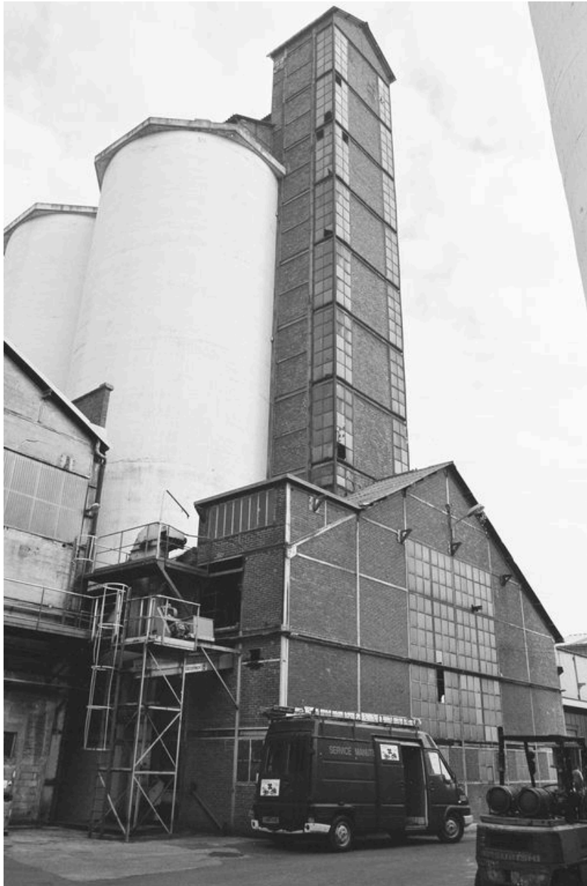
Réservoir industriel : vue partielle.
