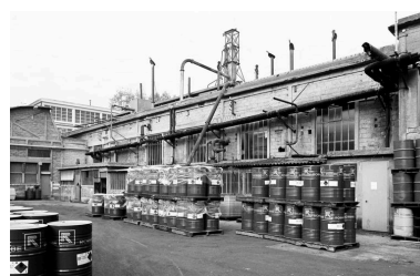
Ateliers de fabrication. Phot. Benoît Dufournier IVR22_19936002358Z
