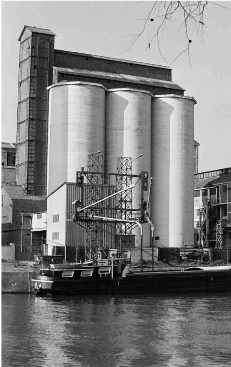
Réservoirs industriels : flanc est.
