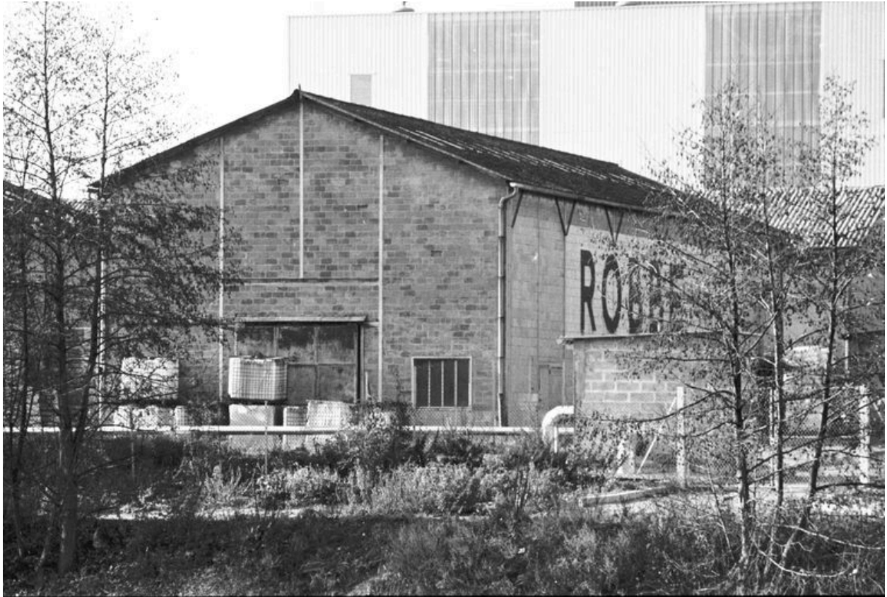
Magasin industriel, flanc est.
