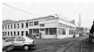
Bureau : flanc nord. Phot. Benoît Dufournier IVR22_19936002385Z
