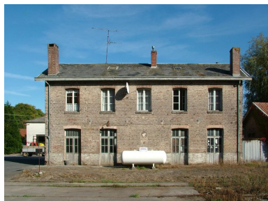
Vue du bâtiment principal de l'ancienne gare depuis les voies ferrées. Phot. Frédéric Fournis IVR22_20098005444NUCA
