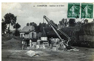
Chargement de blocs de pierre, avant 1908 (coll. part.). Phot. Monnehay-Vulliet Marie-Laure IVR22_20098000386NUCA
