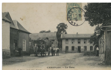
Vue générale depuis la rue, avant 1906 (coll. part.). Phot. Monnehay-Vulliet Marie-Laure IVR22_20098000332NUCA
