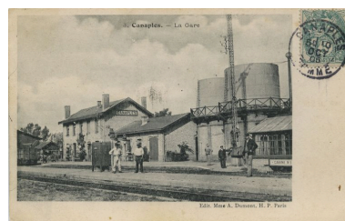
La gare avec les voies, les quais et les réservoirs d'eau, avant 1905 (coll. part.). Phot. Monnehay-Vulliet Marie-Laure IVR22_20098000334NUCA
