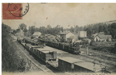
Vue générale depuis les voies, avant 1908 (coll. part.). Phot. Monnehay-Vulliet Marie-Laure IVR22_20098000333NUCA
