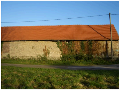
Vue depuis la rue de ce bâtiment. Phot. Inès Guérin IVR22_20068005661NUCA
