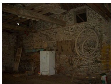
Vue intérieure. Phot. Inès Guérin IVR22_20068005655NUCA
