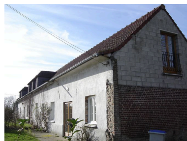
Vue de la façade du logis. Phot. Inès Guérin IVR22_20078005380NUCA
