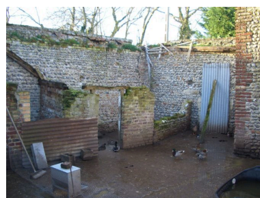
Vue de la cour du poulailler. Phot. Inès Guérin IVR22_20068005657NUCA
