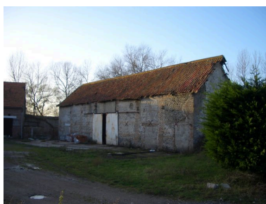
Vue de la grange. Phot. Inès Guérin IVR22_20068005653NUCA
