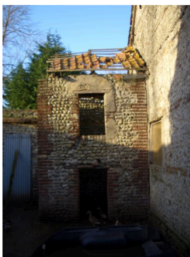
Vue du poulailler accolé à la grange. Phot. Inès Guérin IVR22_20068005656NUCA
