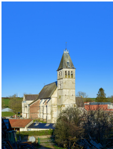
Vue de la tour depuis la rue Haute. Phot. Thierry Lefébure IVR32_20236200352NUCA
