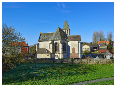
Vue du chevet de l'église. Phot. Thierry Lefébure IVR32_20236200353NUCA
