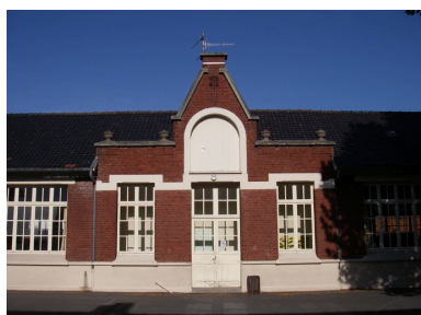
Groupe scolaire, salles de classes des garçons, détail de la porte et de la lucarne-pignon. Phot. Cyril Cailleau IVR31_20055907479NUCA
