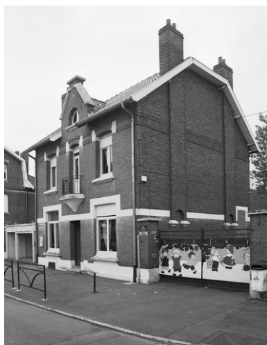
Groupe scolaire, façade principale du logement du directeur (1931-1937). Phot. Philippe Dapvril IVR31_20085901074X
