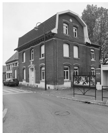
Groupe scolaire, façade principale du logement des institutrices (1904-1908). Phot. Philippe Dapvril IVR31_20085901073X
