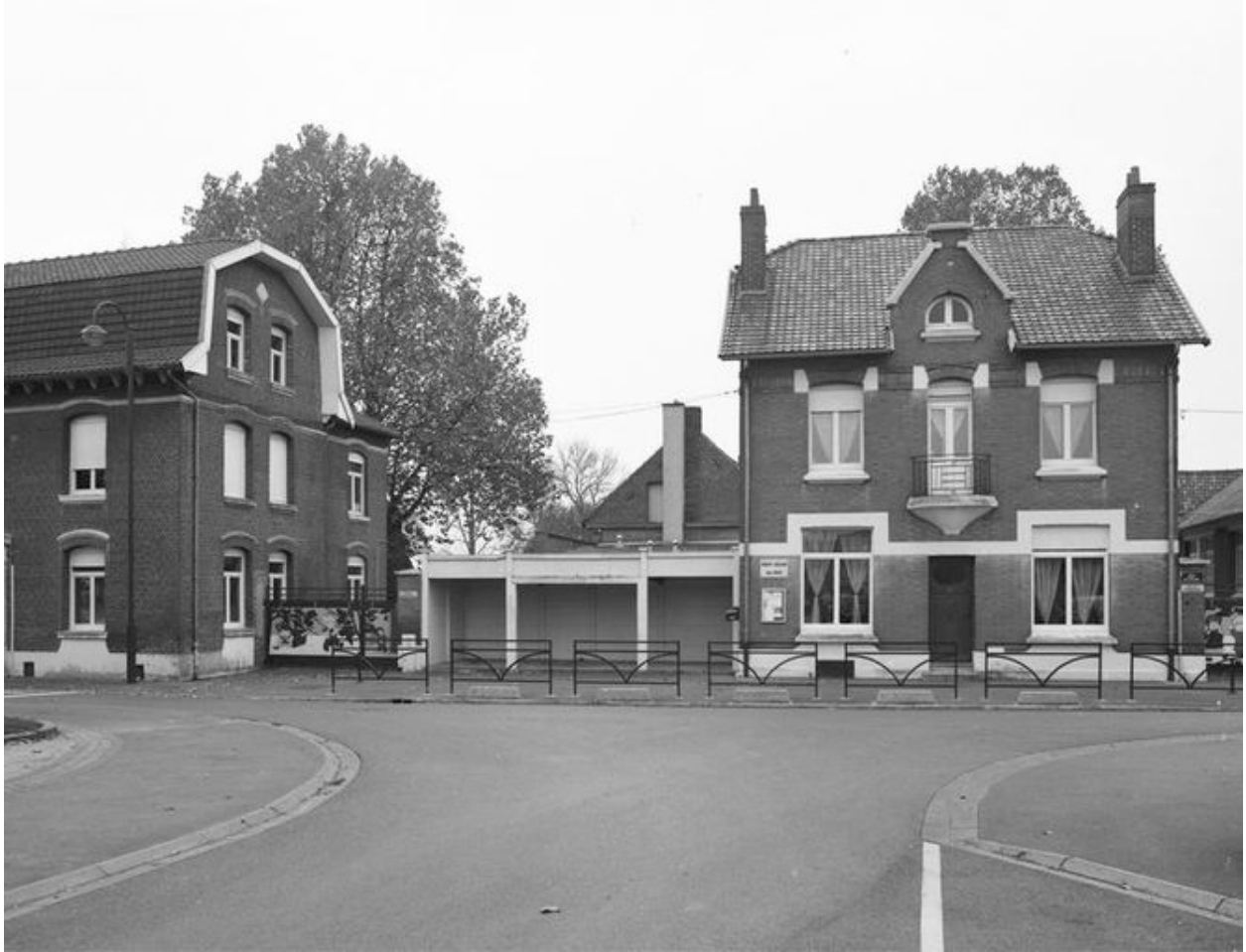
Groupe scolaire, façade principale du logement du directeur et du logement des institutrices.
