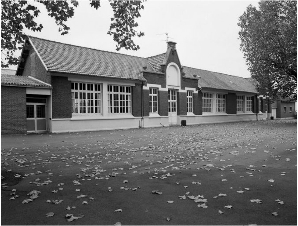
Groupe scolaire, façade sur cour des salles de classes des garçons (1931-1937).
