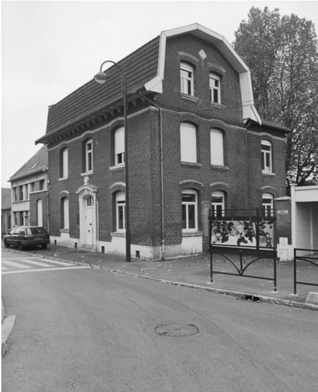
Groupe scolaire, façade principale du logement des institutrices (1904-1908).
