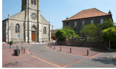
Vue générale de l'église. Phot. Pierre Thibaut IVR31_20125901782NUCA
