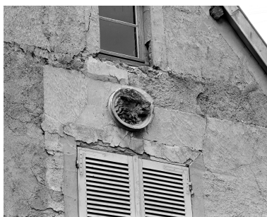
Détail d'un des médaillons du pignon sur jardin. Phot. Thierry Lefébure IVR22_19960200530X
