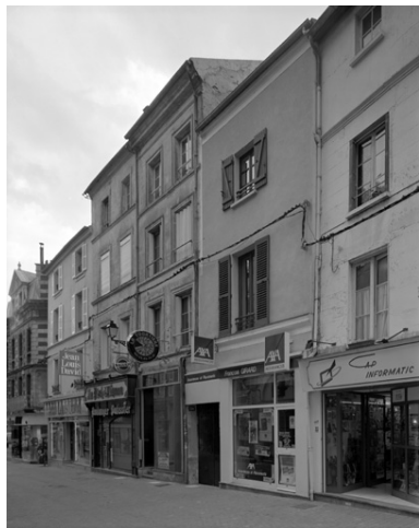
Vue de la façade sur la grande rue. Phot. Thierry Lefébure IVR22_19960200493V
