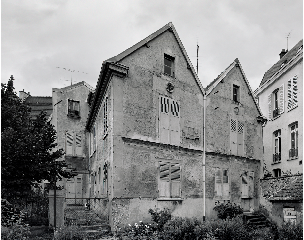
Vue des pignons sur le jardin.
