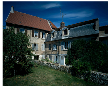
Vue d'ensemble sur la face arrière. Phot. Thierry Lefébure IVR22_19930200954VA
