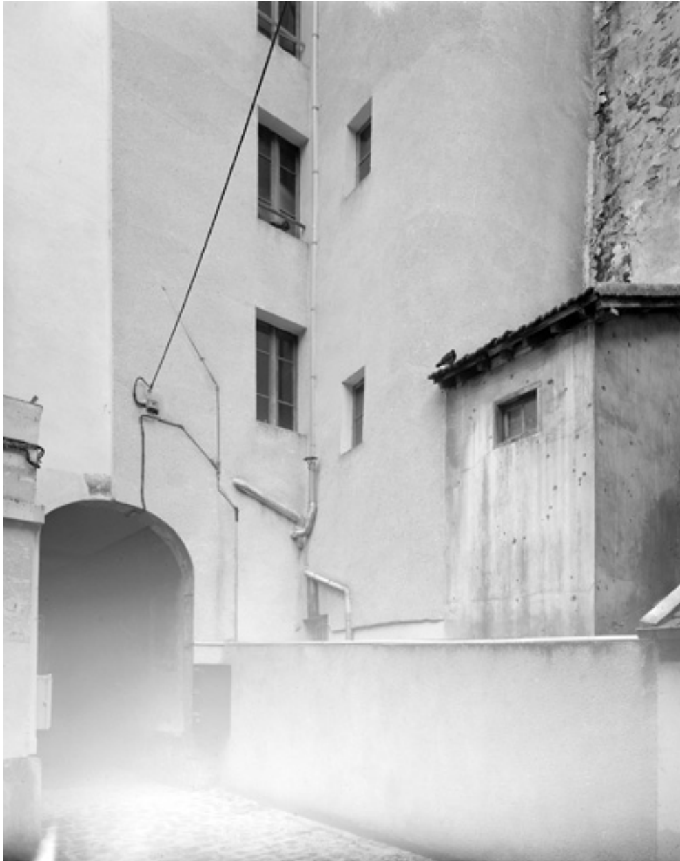
Vue du porche d'entrée pris de la cour avec l'escalier hors oeuvre du n° 60.
