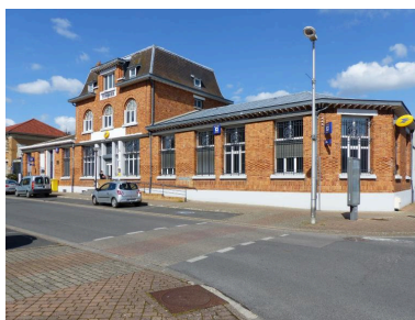
Vue générale depuis le sud-ouest. Phot. Isabelle Barbedor IVR32_20210205020NUCA
