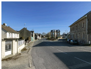
Vue vers l'est de la Grande rue. Phot. Thierry Lefébure IVR22_2015800092NUC2A
