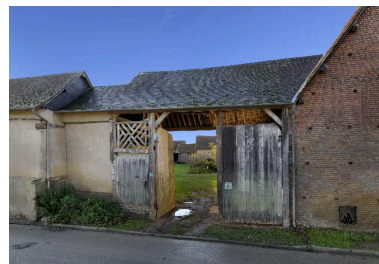
Ferme, 127 rue de Friaucourt. Phot. Thierry Lefébure IVR22_20158001020NUC2A
