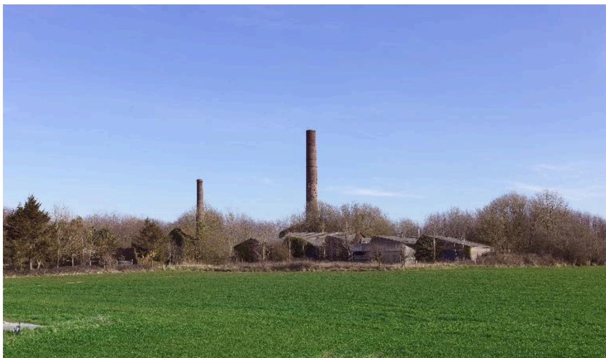
Ancienne briqueterie Flet.
