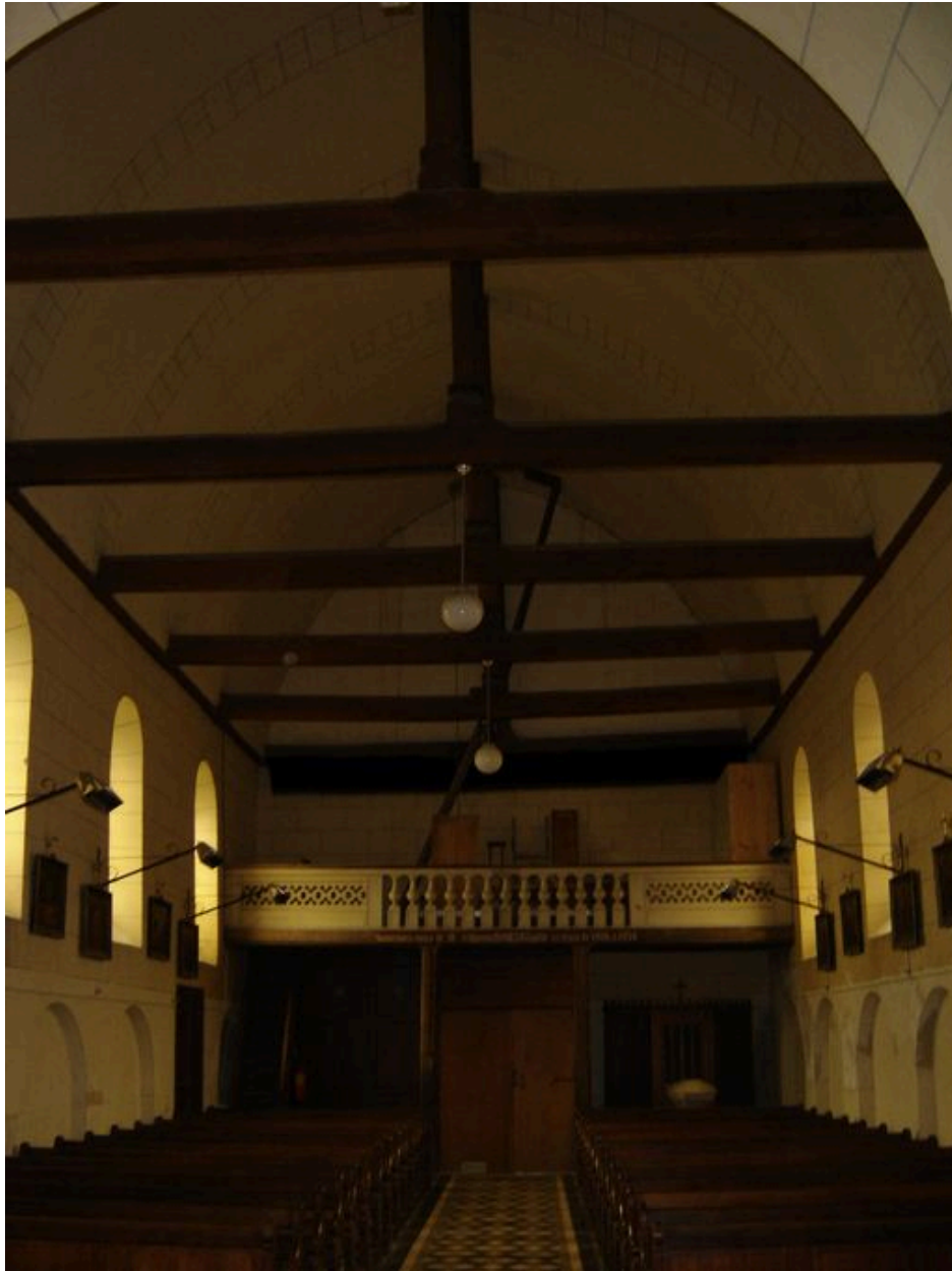
Vue intérieure de la nef.
