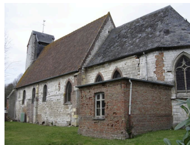
Vue générale depuis le sud-est. Phot. Inès Guérin IVR22_20068005388NUCA
