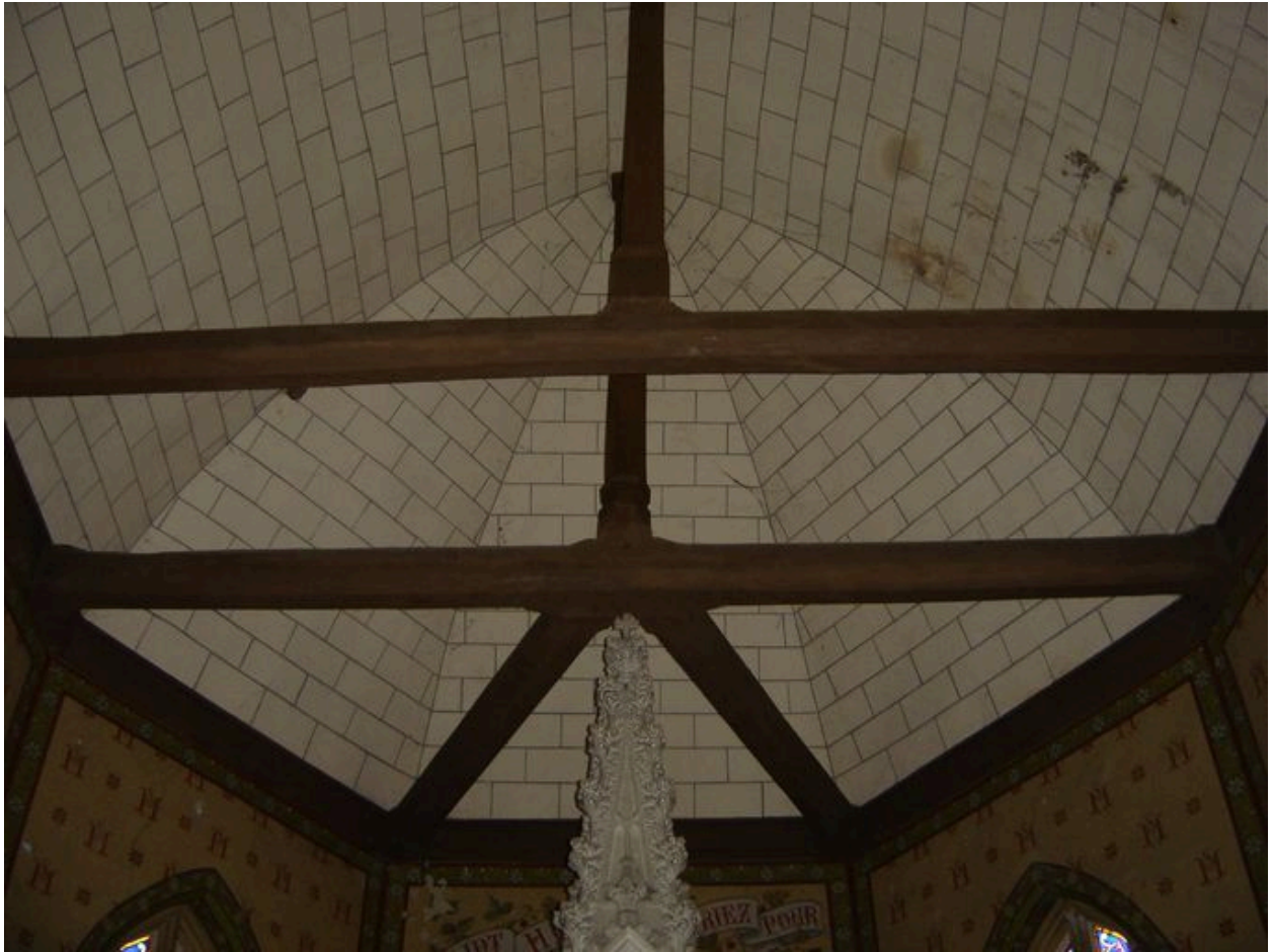
Détail de la charpente apparente dans le chœur.
