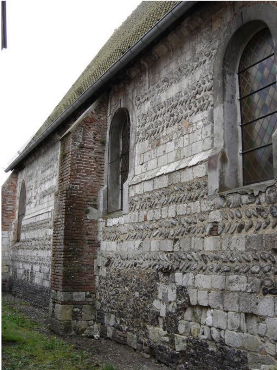
Vue latérale du mur nord.
