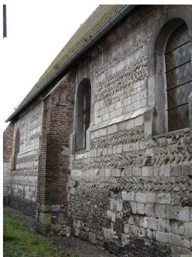
Vue latérale du mur nord. Phot. Inès Guérin IVR22_20068005387NUCA
