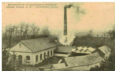
Bourseville. Vue générale de l'ancienne usine Opaix Frères et Cie. Carte Postale, vers 1905 (coll. part.). Phot. Frédéric-Nicolas Kocourek (reproduction) IVR22_20158005092NUCA
