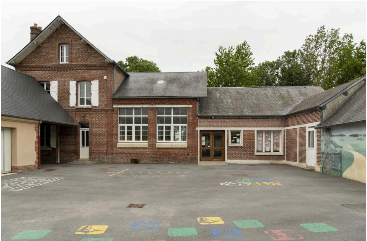
Cour et école de Viefvillers: ancien logement de l'instituteur, salle de classe et à droite, extension avec reprise de l'ancien préau.
