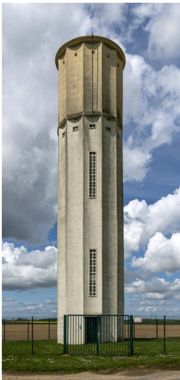
Vue générale du château d'eau de Viefvillers, à la sortie du village, route du Gallet.
