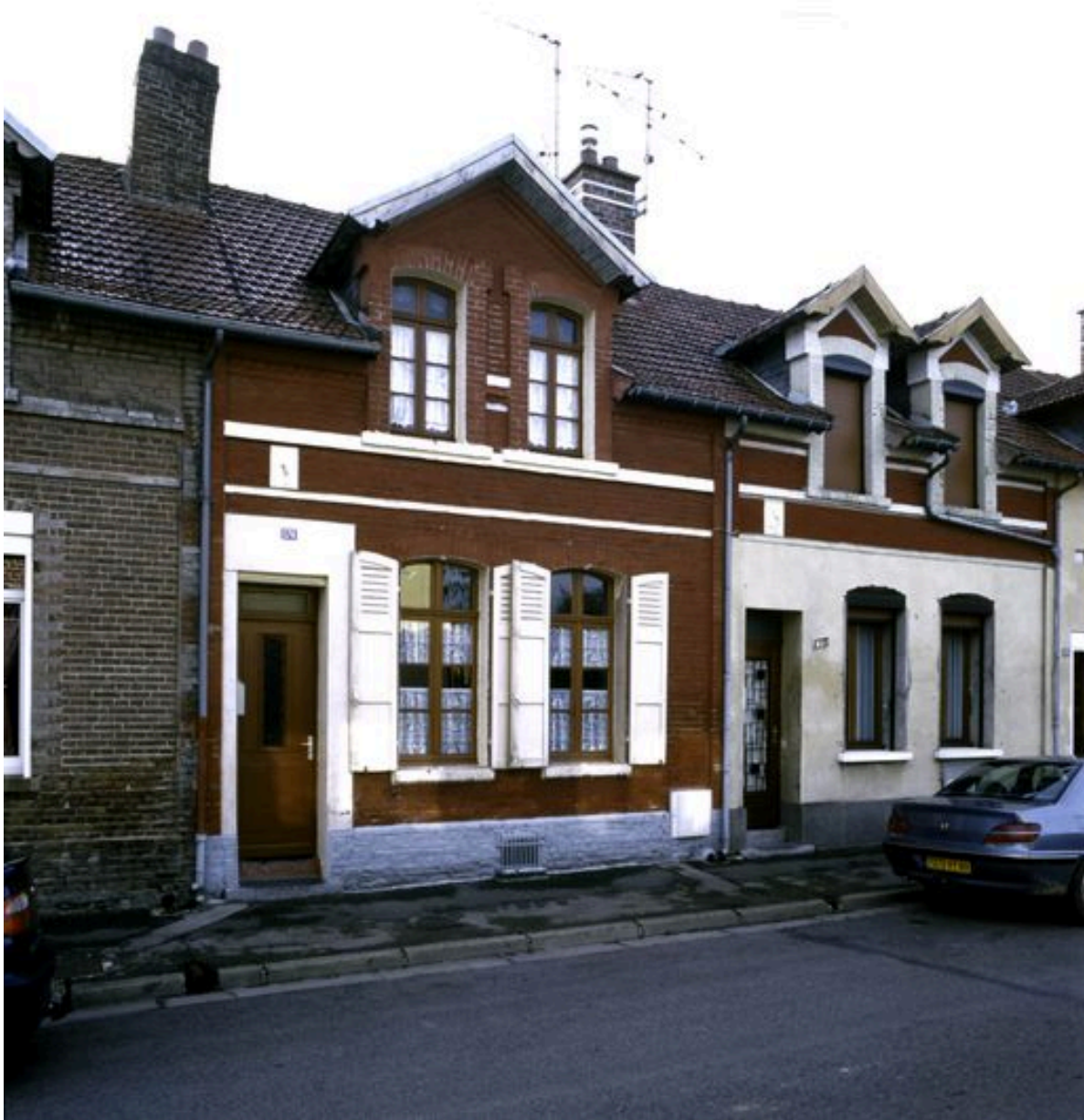
174 et 176 rue Jean-Catelas, maisons construites en 1922 et 1923.
