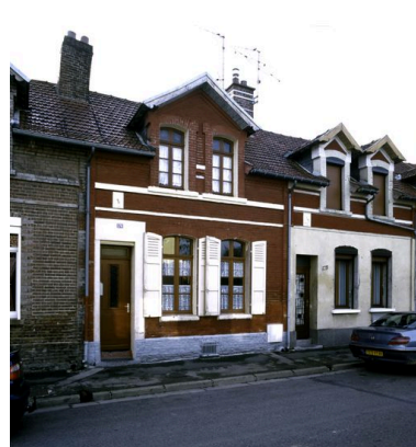
174 et 176 rue Jean-Catelas, maisons construites en 1922 et 1923. Phot. Thierry Lefébure IVR22_20038001078XA
