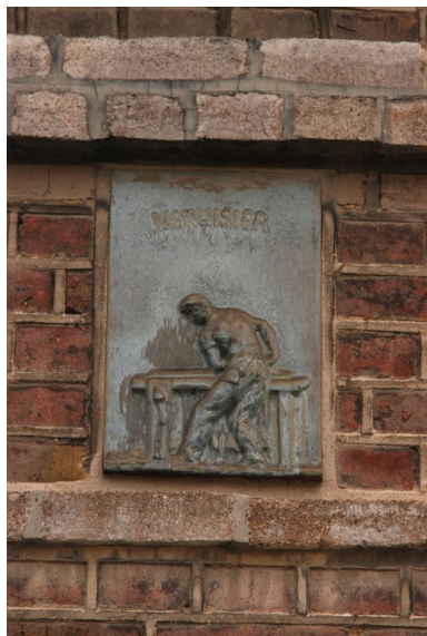
172 rue Jean-Catelas, détail de l'enseigne de menuisier. Phot. Thierry Lefébure IVR22_20038001003NUCA
