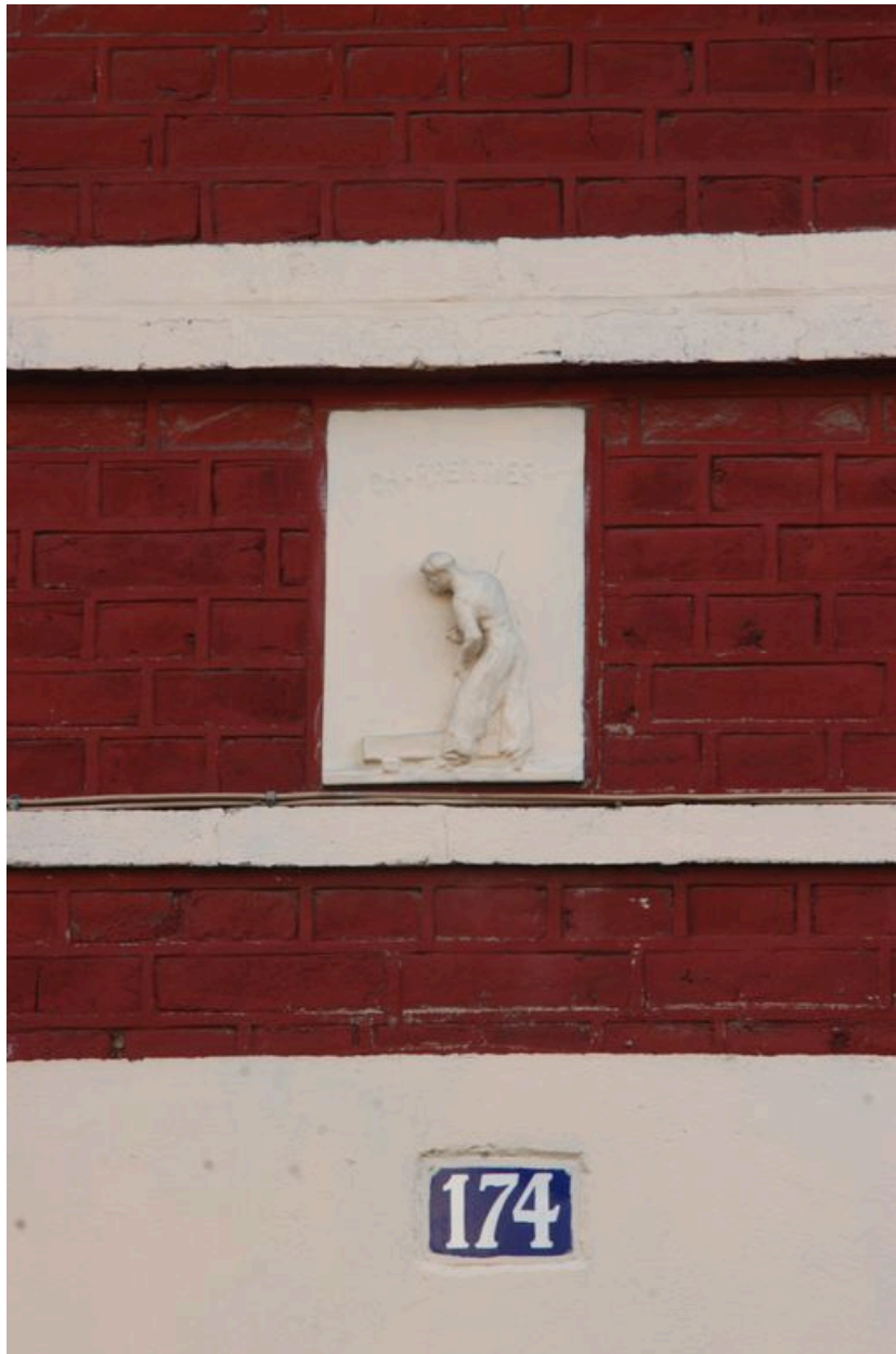
174 rue Jean-Catelas, détail de l'enseigne de charpentier.
