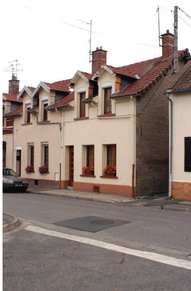
178 et 180 rue Jean-Catelas, maisons construites en 1922. Phot. Thierry Lefébure IVR22_20038001008NUCA
