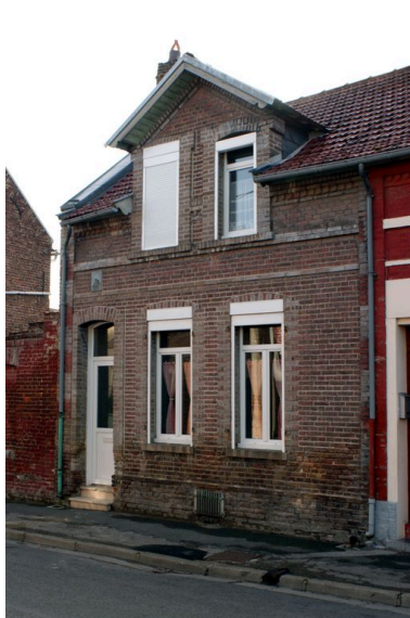
172 rue Jean-Catelas, maison dite Le Menuisier, construite en 1923. Phot. Thierry Lefébure IVR22_20038001002NUCA
