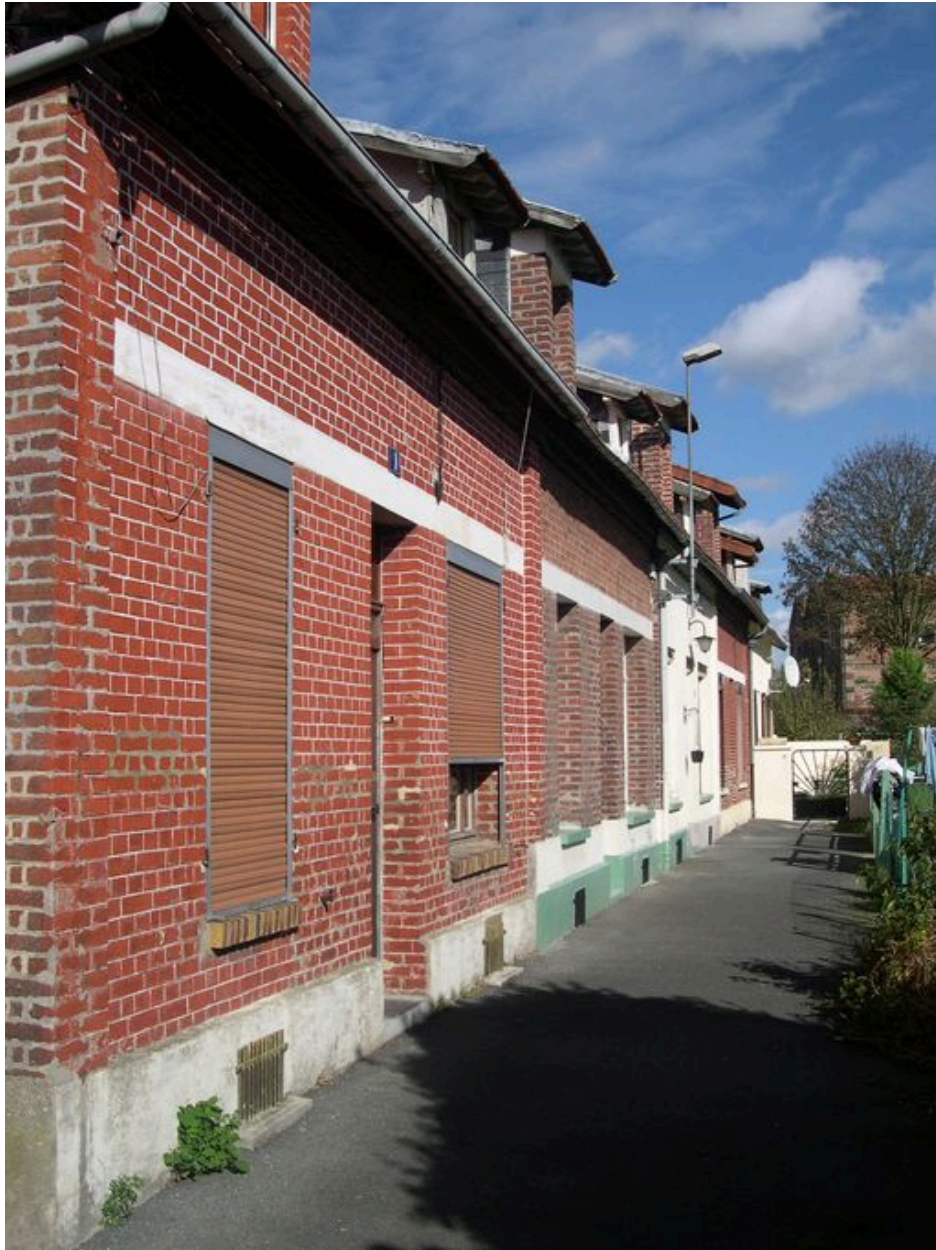
Cité Saint-Jean, maisons construites en 1921.
